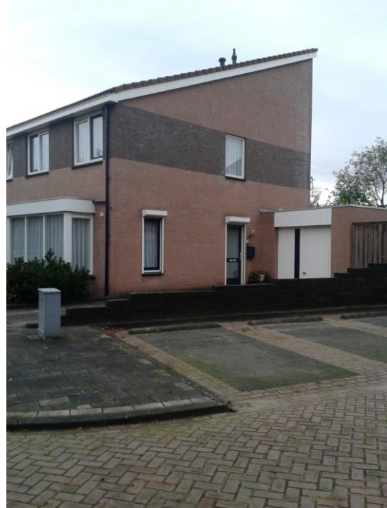
Fig. 9 tegenovergelegen pand Wim Sonneveldstraat 96
