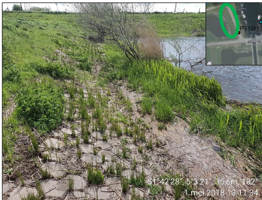
Figuur 10: primaire waterkering met Basaltonbekleding
