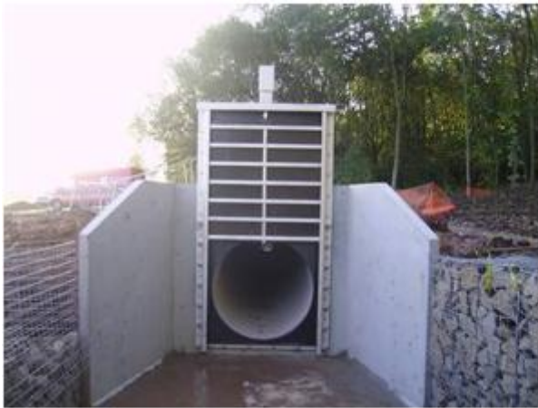
Figuur 13: impressie van afsluitmiddelen spindelschuif (links) en terugslagklep (rechts)
