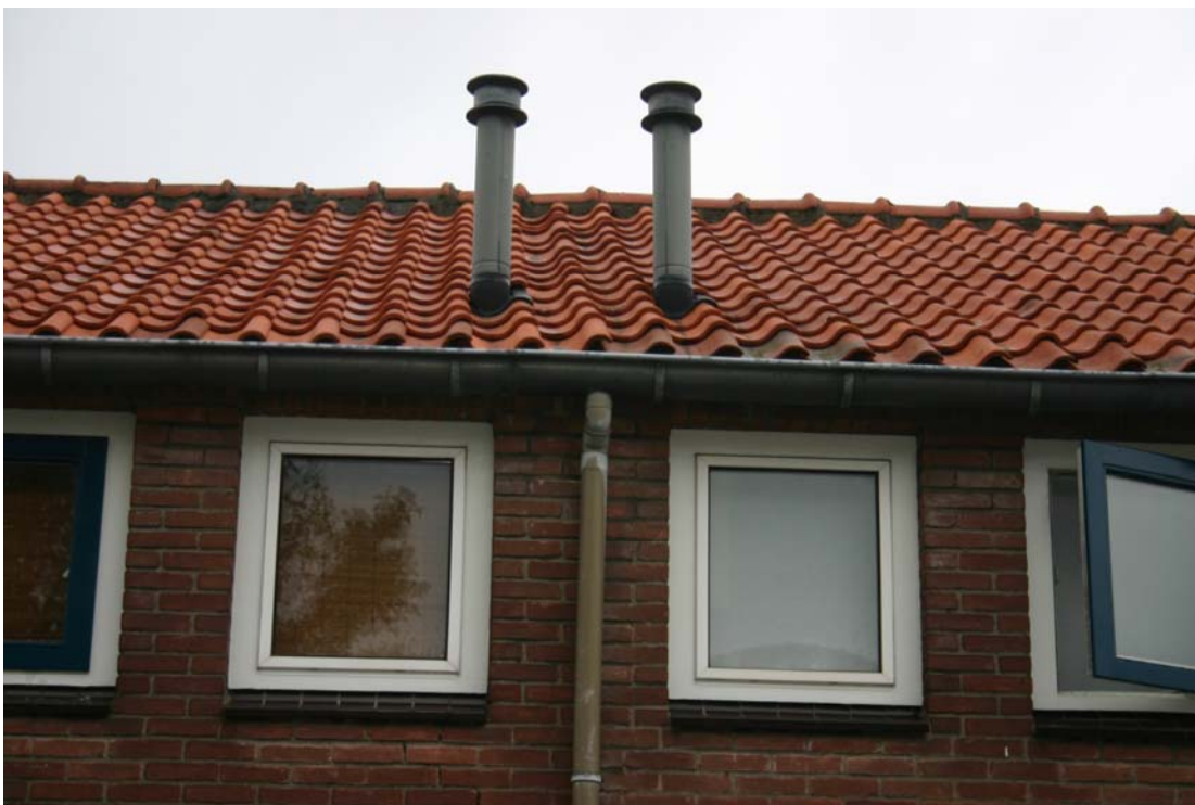
Foto 4.2.4. De onderste pannen hebben een ruimte die geschikt is als nestlocatie voor de huismus.
