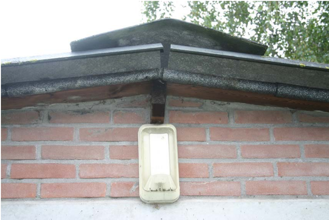
Foto 4.2.3. De ruimte onder de bovenste eternieten plaat is geschikt als nestlocatie voor vogels als de huismus.
