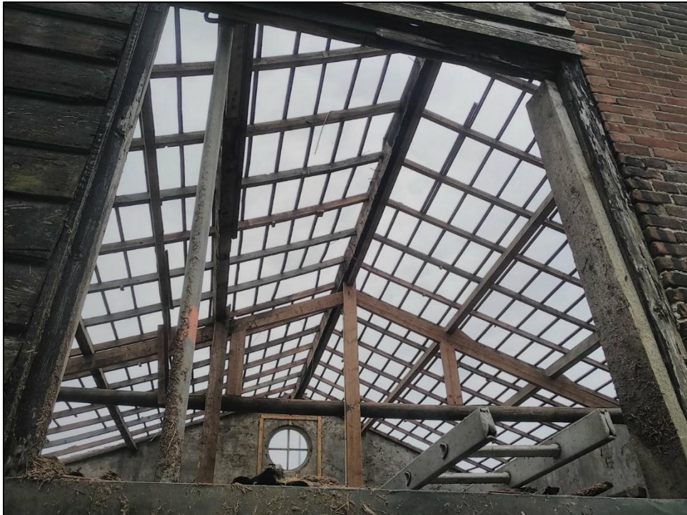
Kapconstructie hoofdgebouw (geen dakbeplating aanwezig)
