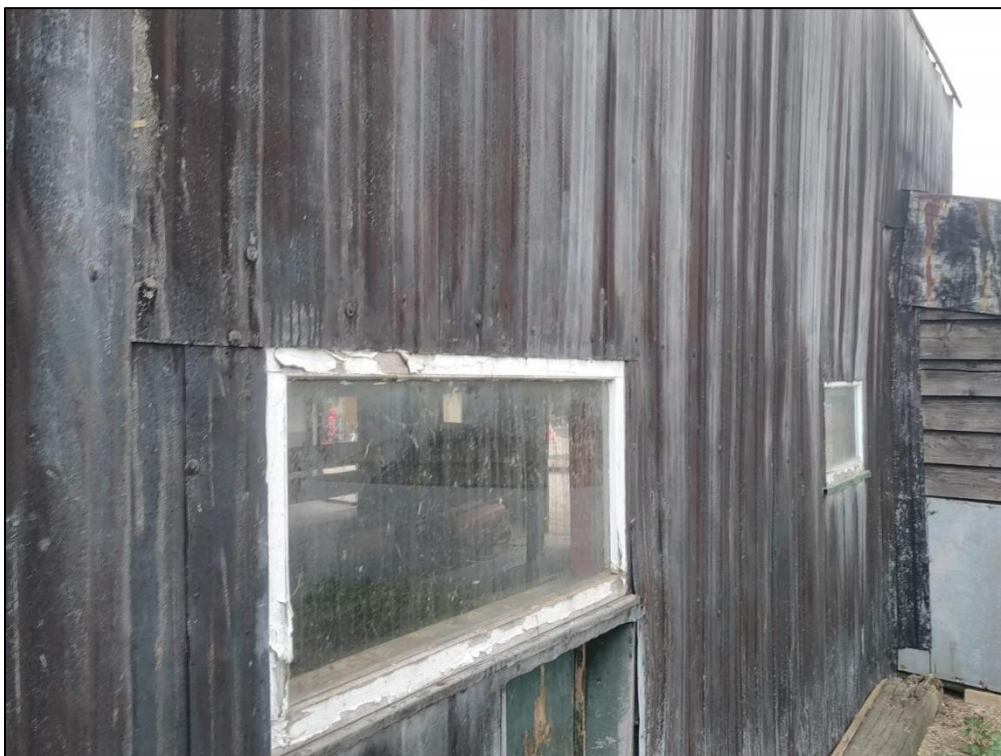
Zijgevel hoofdgebouw met metalen beplating
