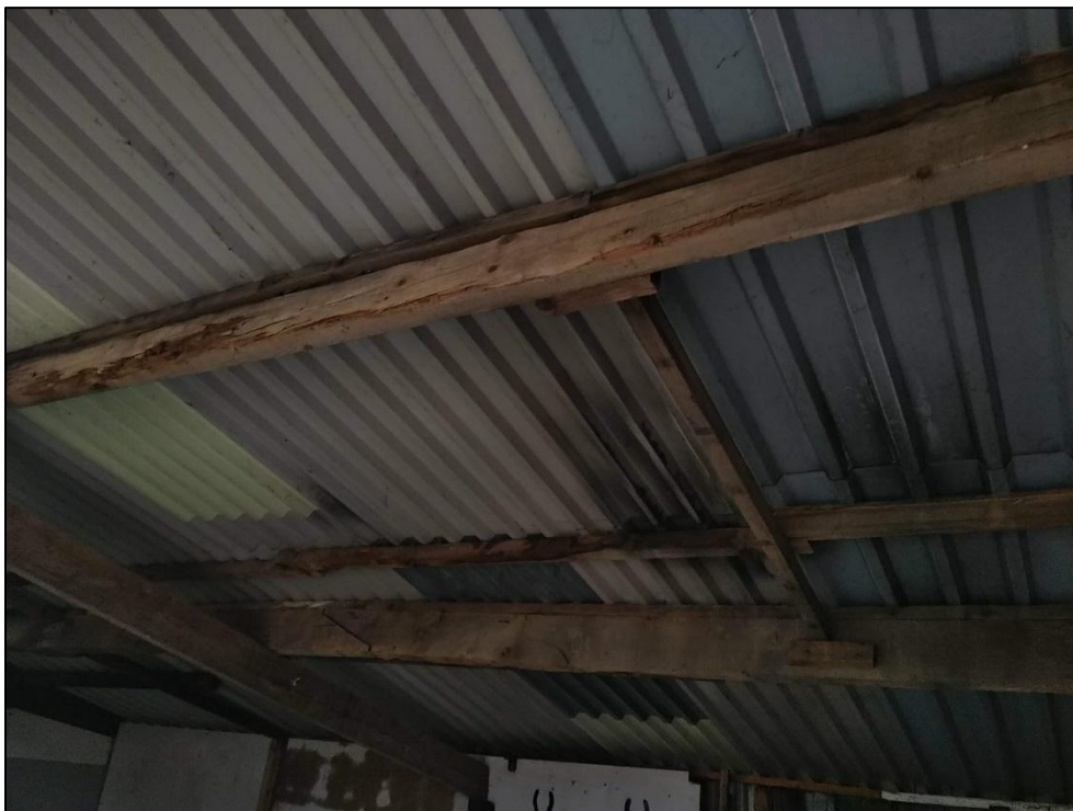
Metalen dakbeschot bijgebouw (damwand)
