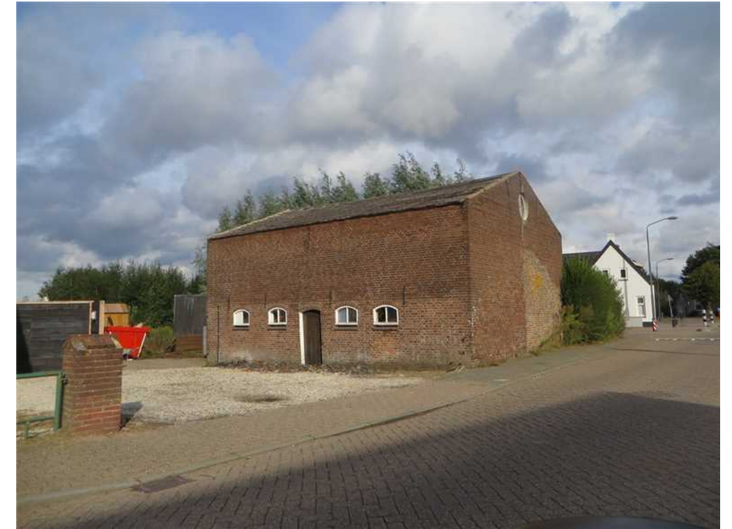
Te slopen schuur (zicht vanuit het westen)
