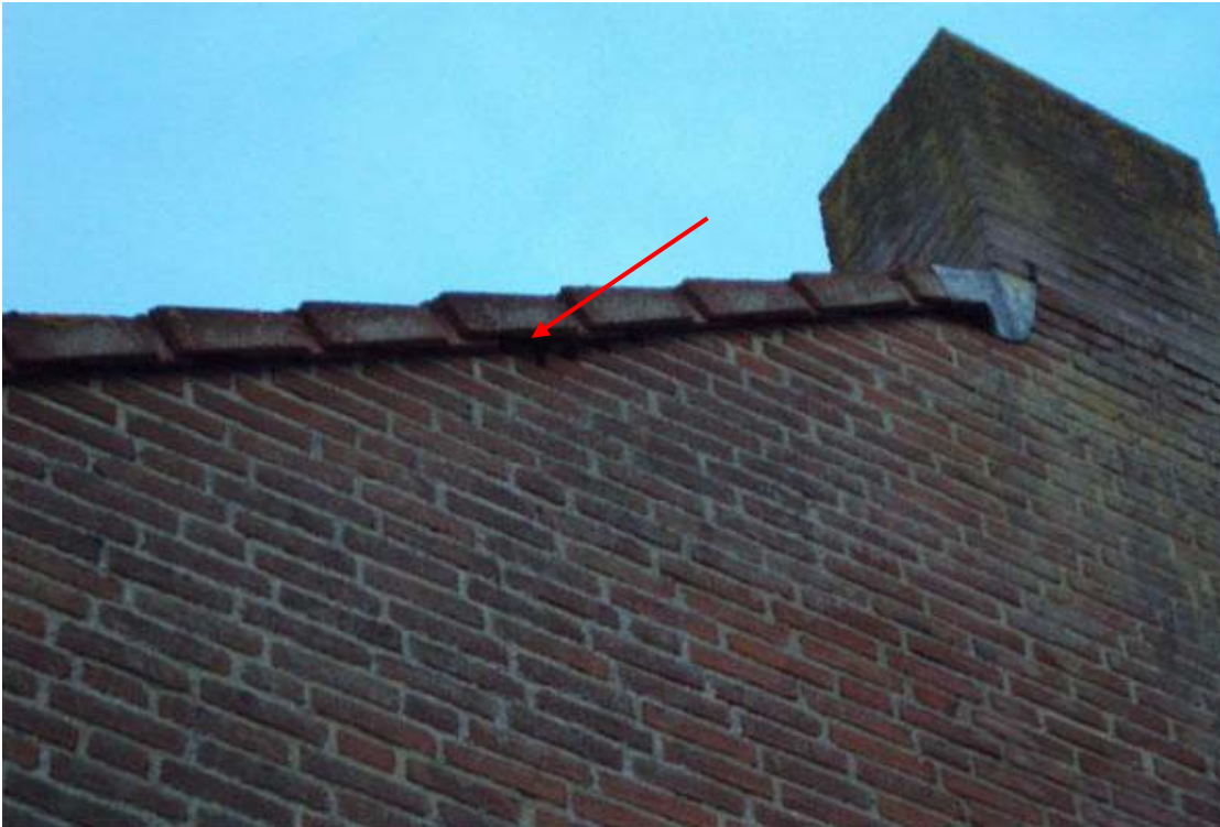
Foto 3. nestverblijf gierzwaluw. Zijgevel Emmastraat nr. 27, bij 5 e dakpan vanaf nok van het dak.
