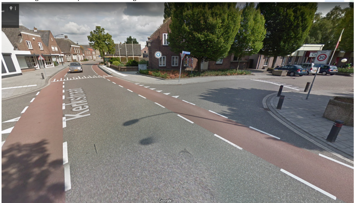
Situatie weg Kerkstraat t.p.v. nieuwe woning
