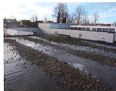
Foto 8: Bitumen dakbedekking (Abm/001 en Abm/001A): geen asbest
