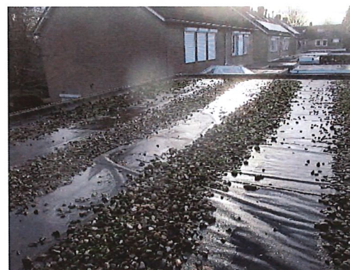
Foto 7: Bitumen dakbedekking (Abm/001 en Abm/001A): geen asbest
