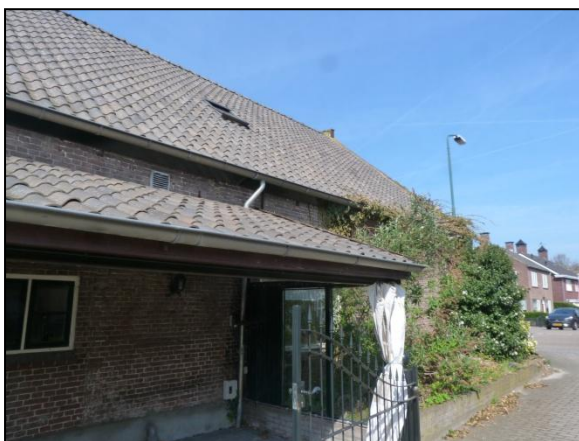
Figuur 9. Dakconstructie woonhuis.
