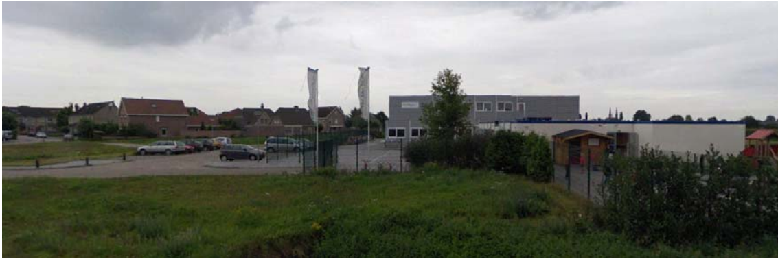
Afbeelding 2.1: bestaande situatie plangebied
