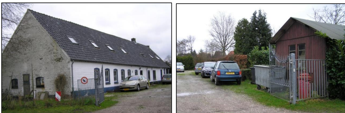
Foto's aanzicht Rooisestraat 1-3, genomen vanuit Rooisestraat (Bron: Tritium Advies)
