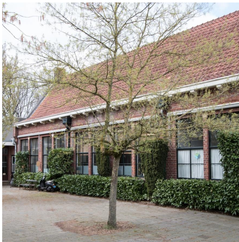
De bouwmassa uit 1965 onderscheidt zich van het oudste bouwdeel door het ontbreken van dakkapellen.
