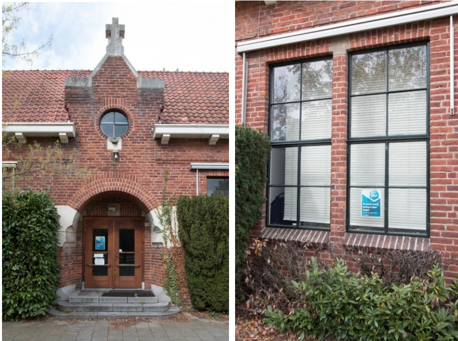
Verbijzonderde entreepartij en recht de per twee gekoppelde vensters met secundaire zonwering.
