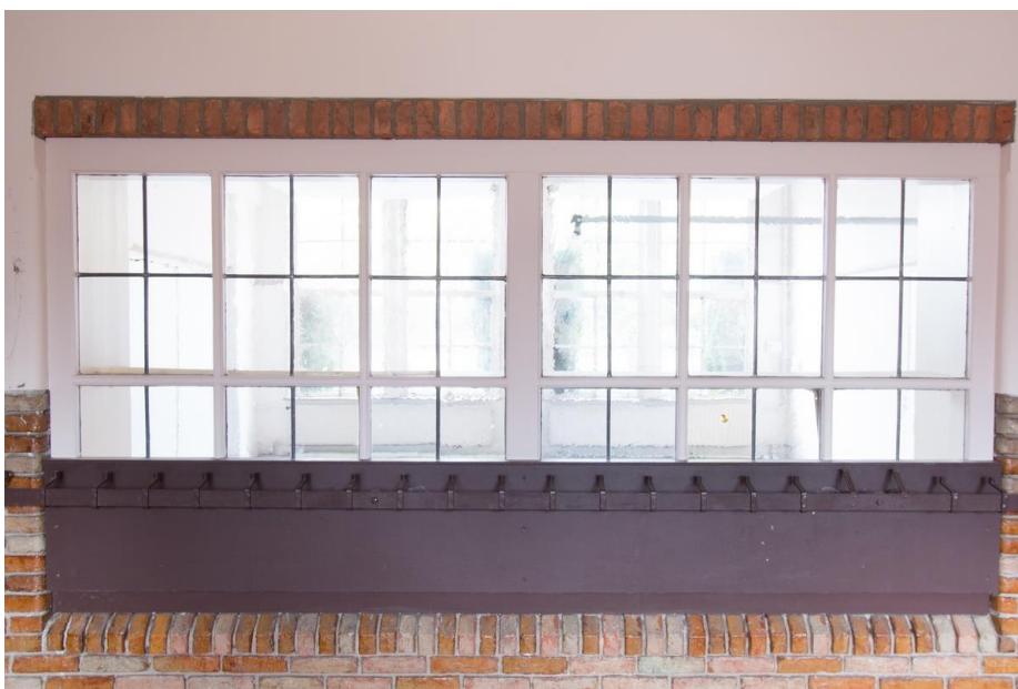
Venster met glas-in-lood in de muur tussen lokaal en gang. Kapstokken zijn hier vrijwel zeker later aangebracht. Houtwerk niet in oorspronkelijke kleur.
