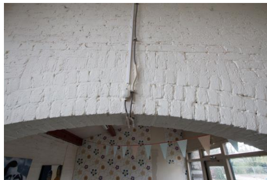
Voormalige buitenruimte met rechts de gevolgen van overschildering van het metselwerk.
