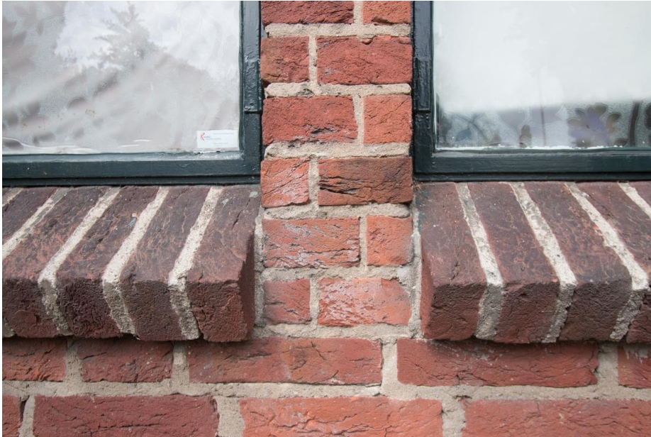
Detailering van het metselwerk, karakteristiek voor het werk van de architect(en).
