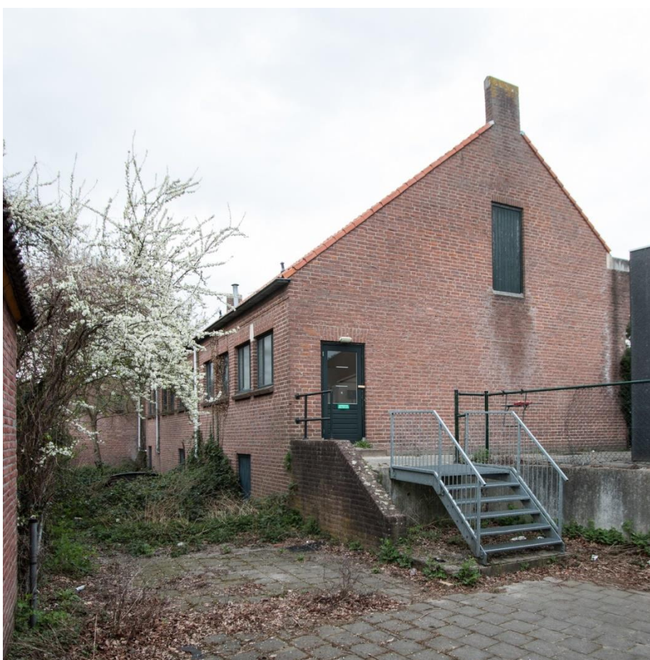
Zijgevel en een deel van de achtergevel van de laatste uitbreiding. Kwaliteit is matig.
