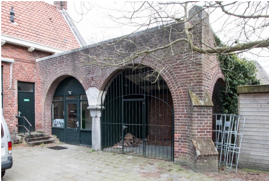
Buitenruimte met secundaire pui en vermoedelijk niet-oorspronkelijk hek.
