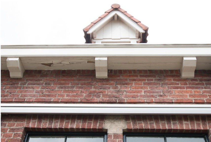
Gootlijst uit de bouwtijd. Oorspronkelijkheid van de kleurstelling nader te bepalen.
