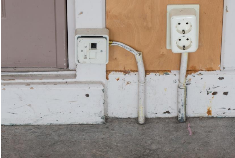
Houten plinten uit de bouwtijd, secundair installatiemateriaal.
