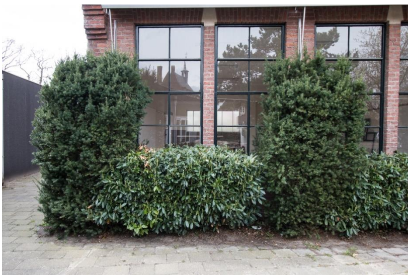
Vensters in de voorgevel, wederom per twee gekoppeld. Links de aanzet van de karakteristieke schouderstukken.
