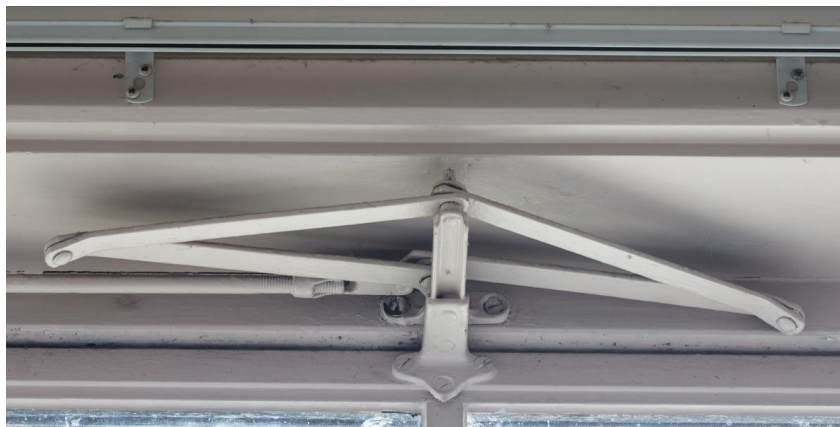
Detailering vensters uit de bouwtijd.
