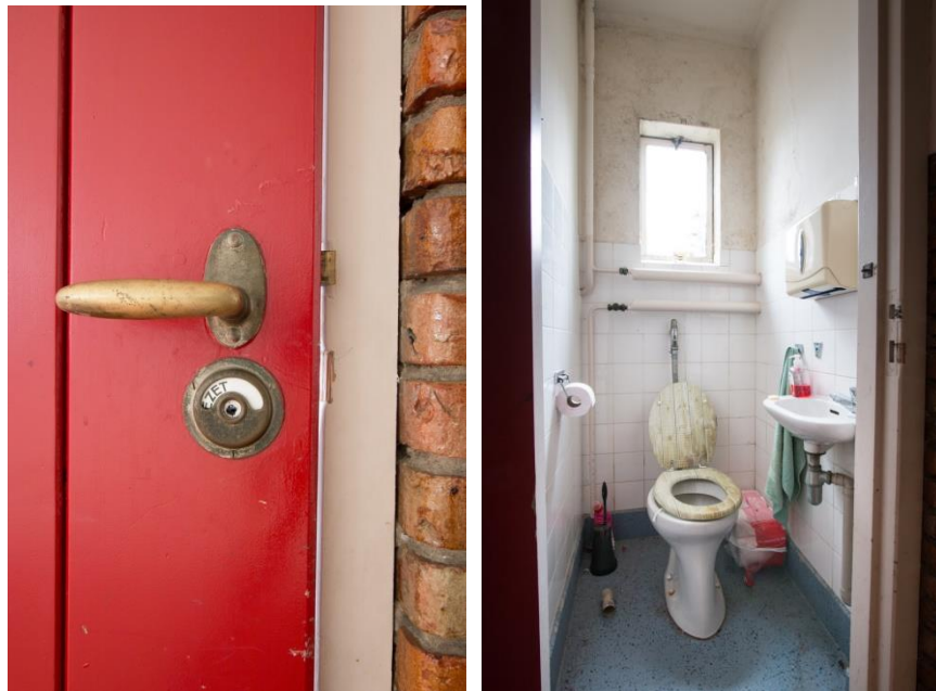
Oorspronkelijke kruk van toiletdeur in oudste bouwdeel. Rechts toilet met vernieuwde vloerafwerking, pot en mogelijk ook tegelwerk.
