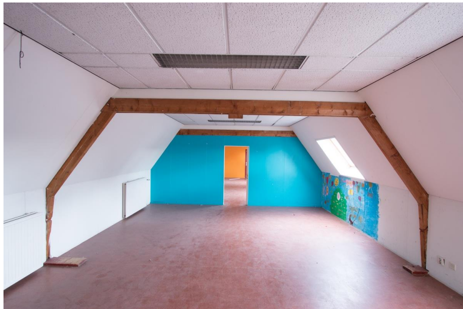
Eén van weinige spanten die de oorspronkelijke trekbalen behouden heeft.
