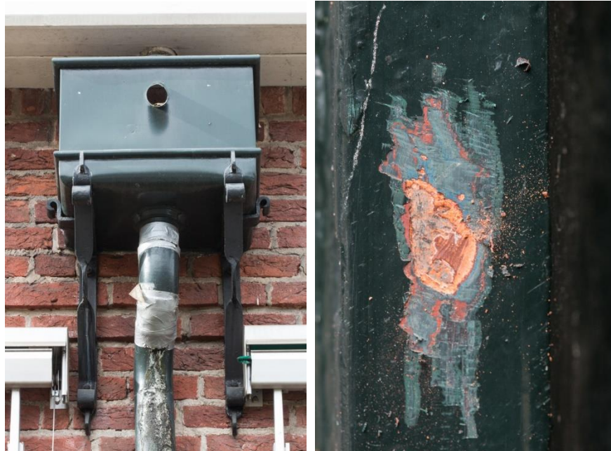
Oorspronkelijke vergaarbakken en oudere kleurstelling op de ijzeren vensters.
