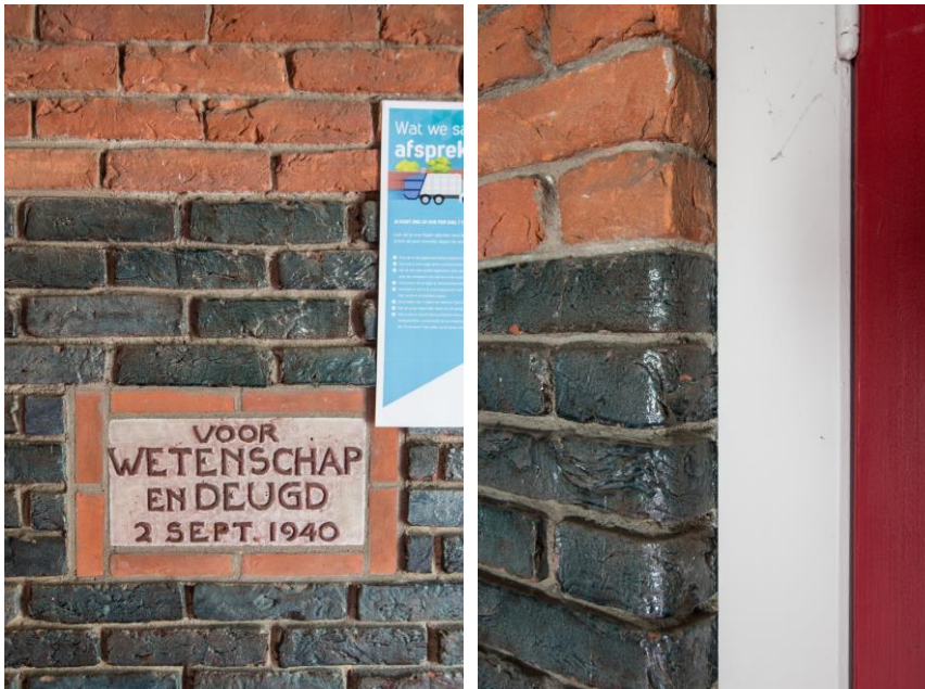
Gedenksteen en detaillering metselwerk, met rechts de overgang van stenen van de lambrisering met afgeronde hoek op de reguliere stenen daarboven. Kozijnhout was oorspronkelijk groen in plaats van wit.
