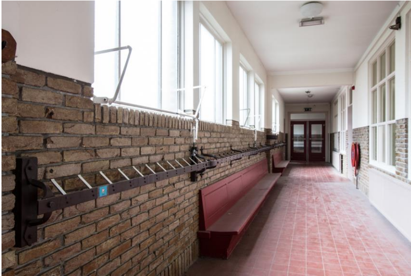
Gang langs achtergevel en lokalen. Voorste kapstok jonger dan de overige. Bankjes langs de achtergevel vermoedelijk uit de bouwtijd.
