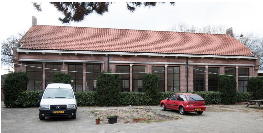
De voorgevel van de laatst gerealiseerde uitbreiding.
