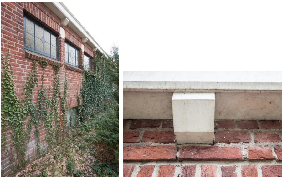
De achtergevel van het oudste bouwdeel, rechts vereenvoudigde gootconsoles.
