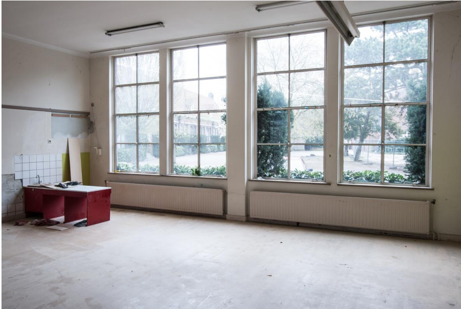
Klaslokaal richting de voorgevel.
