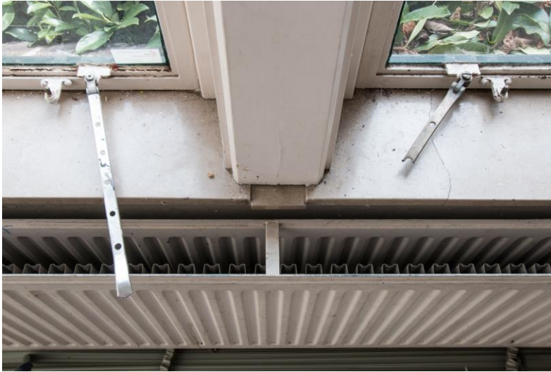
Secundaire radiatoren onder vermoedelijk oorspronkelijke vensterbanken.
