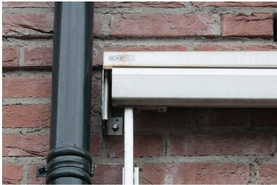
Zonwering aangebracht door de firma Schuijt, vóór 1995.
