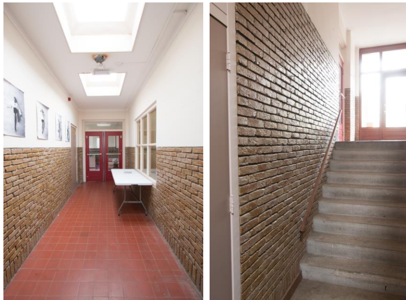
Wat onbestemd ganggedeelte dat de koppeling vormt tussen oud- en nieuwbouw, rechts het gymnastieklokaal. De foto rechts toont de trap naar het gymnastieklokaal.
