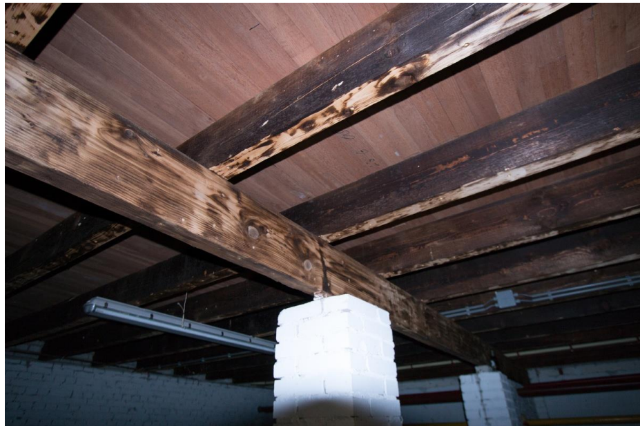
Enkelvoudige balklaag met onderslag op gemetselde pijlers.
