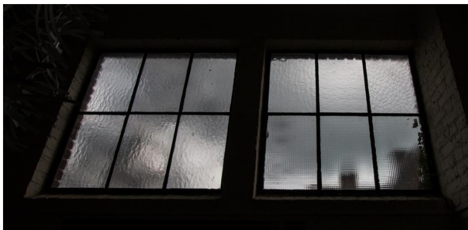
Een deel van de oorspronkelijke beglazing is vervangen door draadglas (rechtsonder) in de vensters die niet uit de bouwtijd (1939) zijn.
