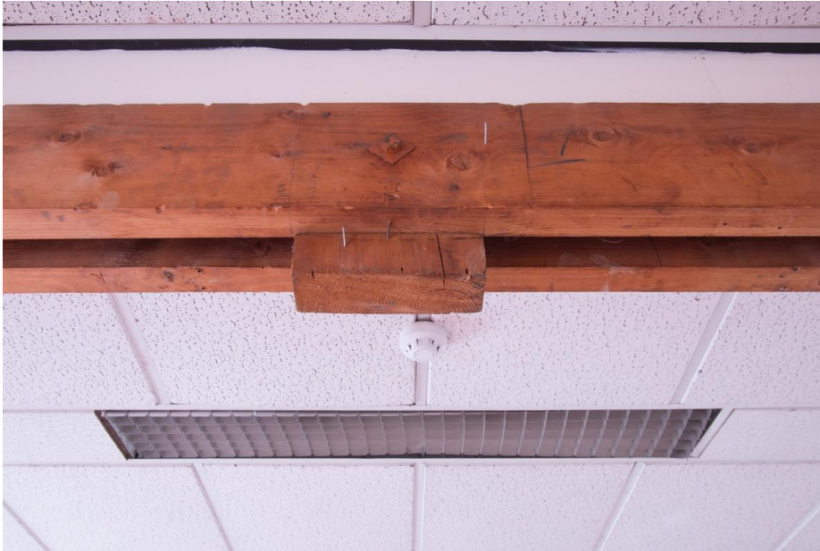
Detail van de constructie die in 1965 werd gemaakt: gebout en genummerd.
