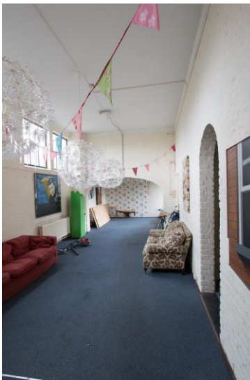
Voormalige buitenruimte met rechts de gevolgen van overschildering van het metselwerk.
