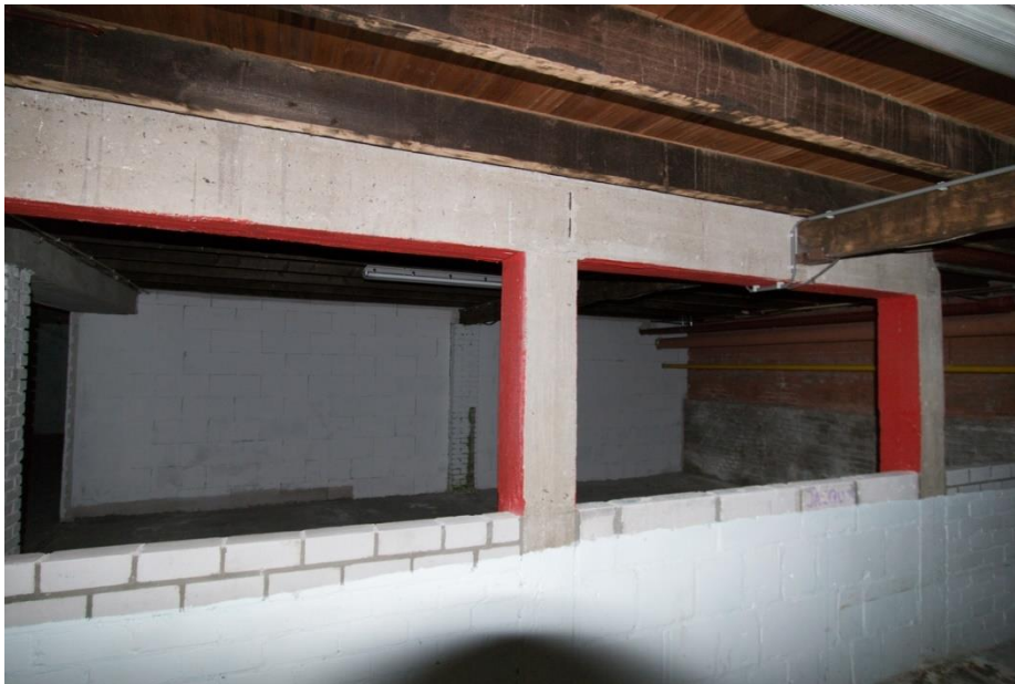
Betonnen spantconstructie in de kelder. Ten behoeve van de scheidingsmuren op de begane grond, onduidelijk is waarom hier niet 'gewoon' een muur is gemetseld.
