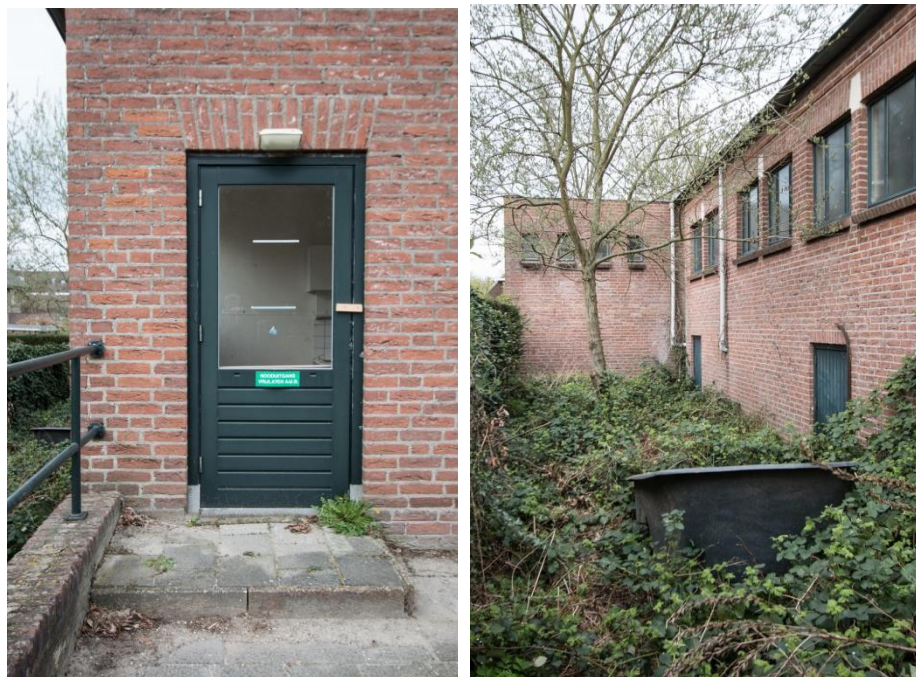
Standaarddeur in linker zijgevel en rechts de achtergevel met zicht op de toiletgroep.
