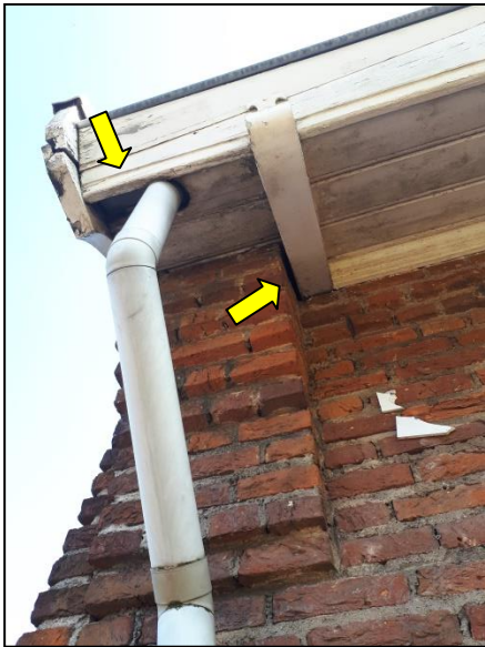
Figuur 11. Dakdetail Rozenoord met openingen geschikt voor vleermuizen.
