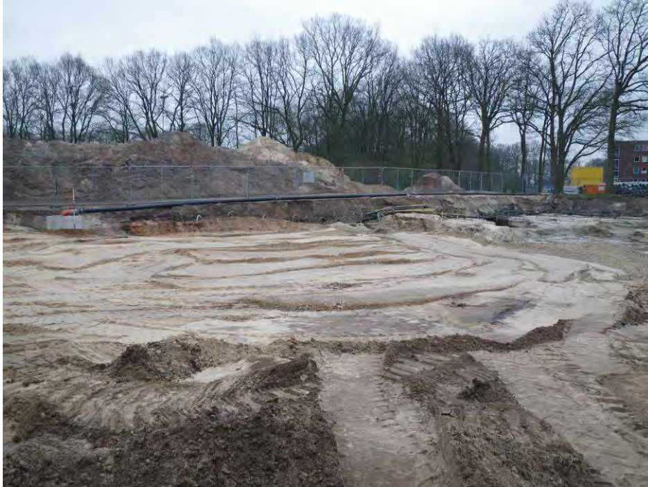
Foto 9. Aanvullen zuidoostelijk terreindeel
