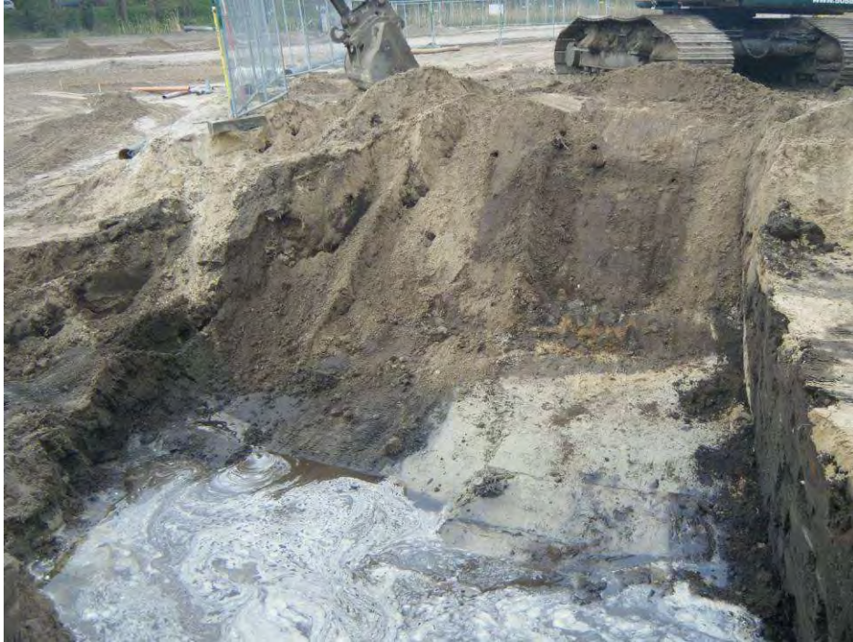
Foto 5. Ontgraving ter plaatse van uitloper
