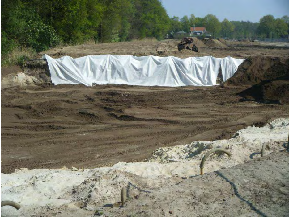
Foto 7. Aangebrachte geotextiel noordelijke wand van fase 2 saneringsgebied
