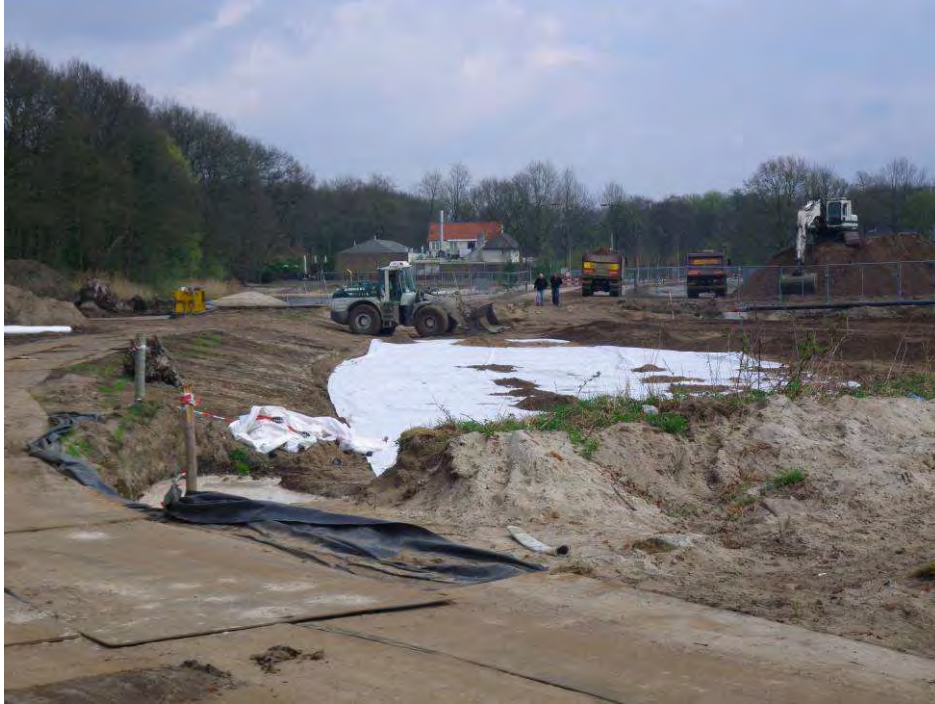
Foto 11. Aanbrengen geotextiel ter plaatse van weggedeelte
