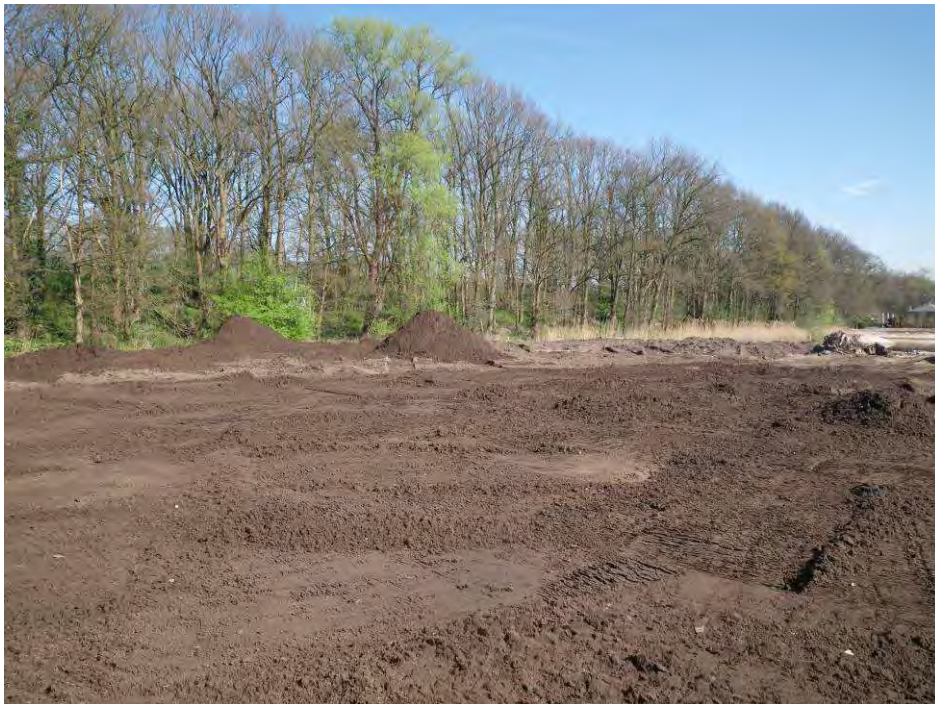
Foto 12. Aanbrengen deklaag op zuidwestelijk en westelijk terreindeel
