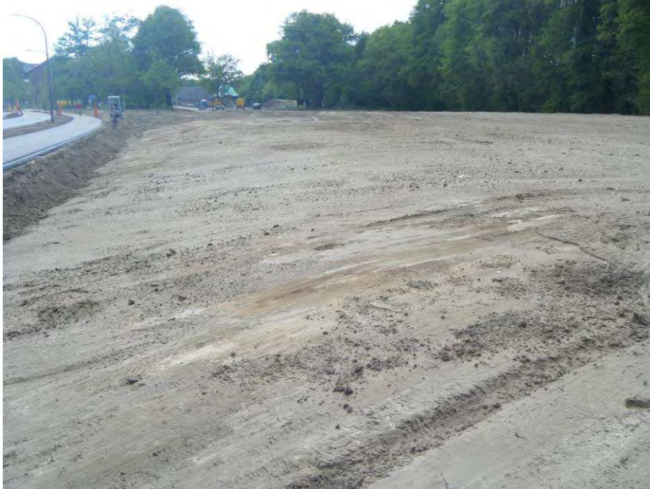
Foto 13. Aangebrachte deklaag klasse wonen grond op westelijk terreindeel
