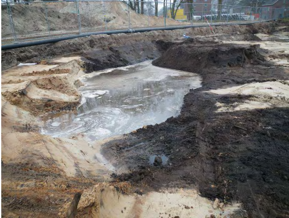
Foto 1. Sanering zuidoostelijk terrein deel –oliespot (Fase 1)
