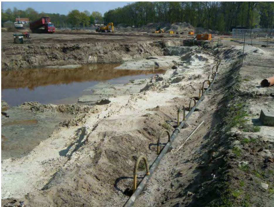
Foto 6. Sanering zuidwestelijk deel (Fase 2)
