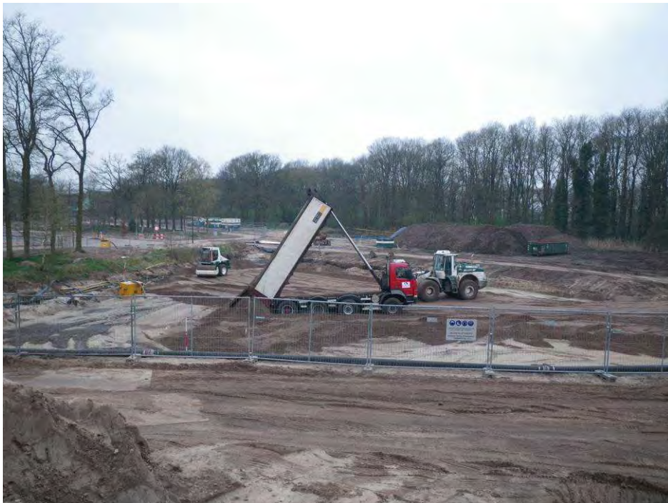
Foto 10. Aanvullen zuidoostelijk deel
