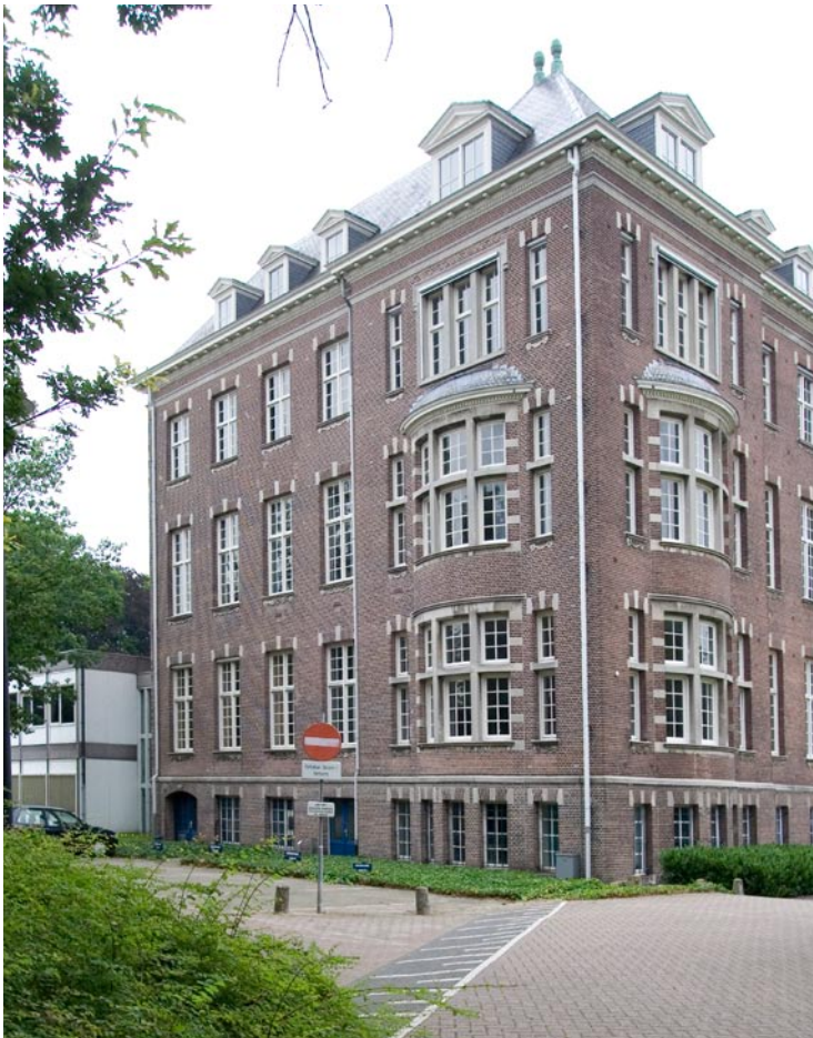
Afb. 3. De linker zijgevel (westgevel) van hoofdgebouw.
