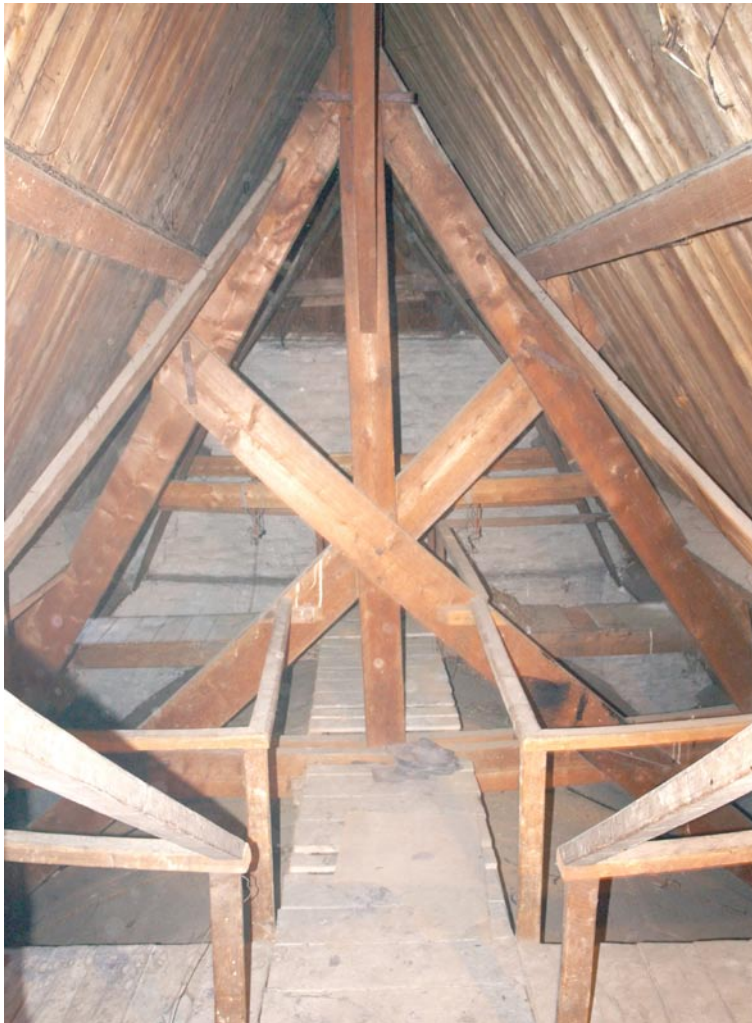
Afb. 23. De kapconstructie van de kapel met houten middenpad en zijpaden naar de dakkapellen.
