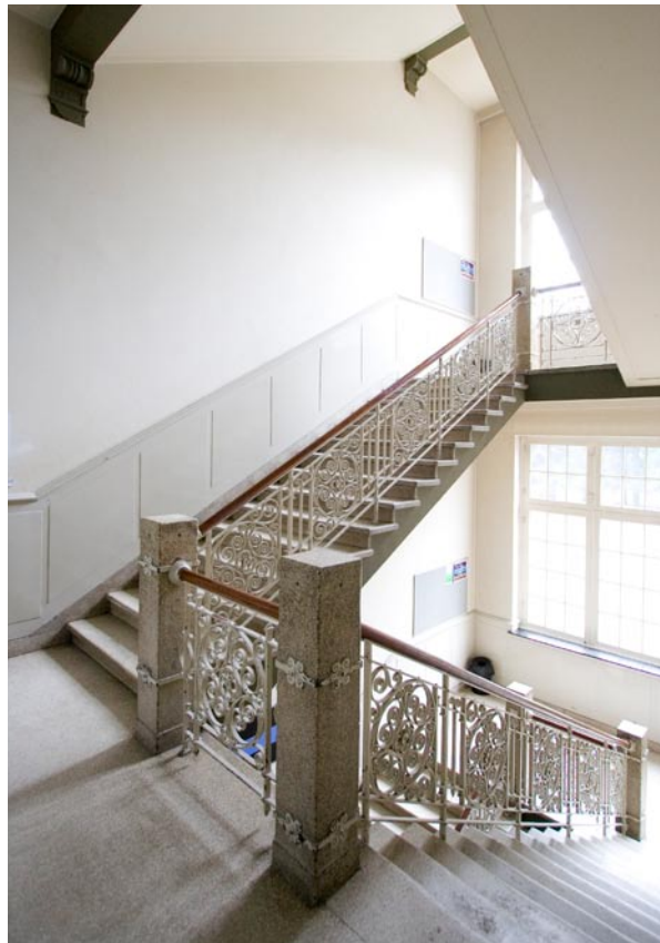
Afb. 21. De bordestrap met smeedijzeren balustrade vanaf de eerste verdieping.
