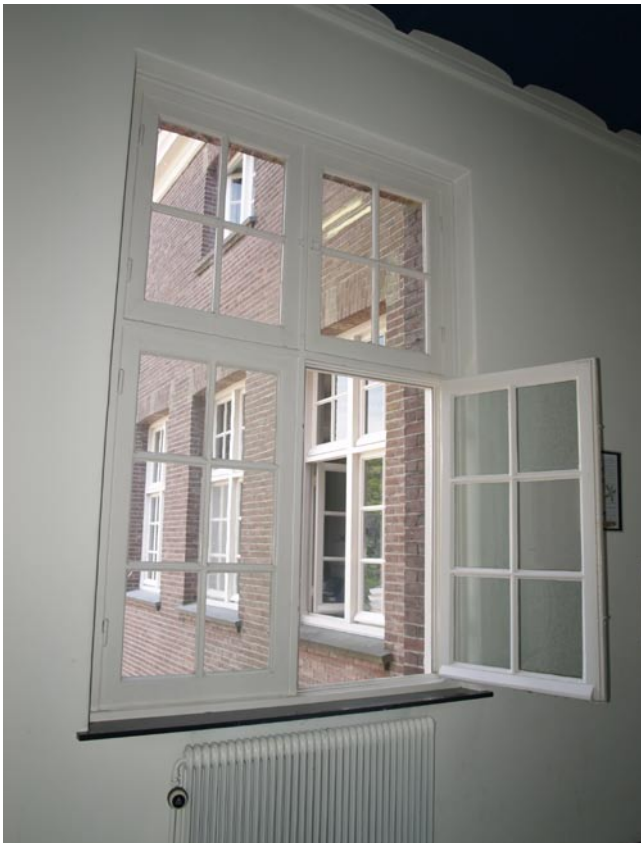
Afb. 22. Een nog oorspronkelijk venster met houten kozijn en ramen op de tweede verdieping.
