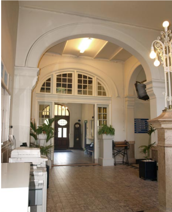
Afb. 13. Zicht vanuit de imposante traphal naar de entree. De troggewelven van de verdiepingsvloer zijn zichtbaar.
