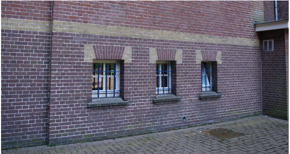
Afb. 6. Gele baksteendecoratie aan de achtergevel als alternatief voor het natuursteen dat aan de voorgevel is gebruikt.
