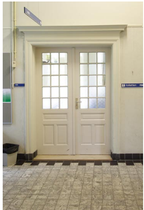
Afb. 16. Eén van de vele oorspronkelijke houten paneeldeuren (hier op de bel-etage).
