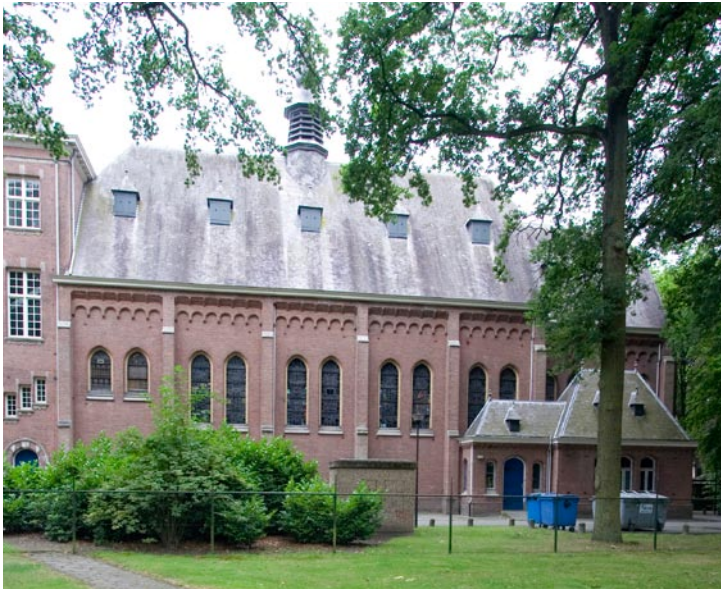
Afb. 8. De rechter zijgevel van de voormalige kapel.
