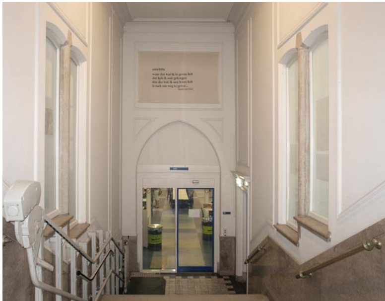
Afb. 17. Trappartij naar de kapel met aan weerszijden vensteropeningen waar oorspronkelijk glas-in-loodramen hebben gezeten. Helemaal rechts in de hoek de opening waar het touw hing waarmee de klok geluid kon worden.
