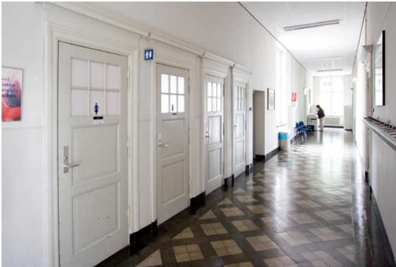
Afb. 20. De gang op de eerste verdieping met een oorspronkelijke, geglazuurde plavuizenvloer en paneeldeuren gevat in met architraven gesierde kozijn.
