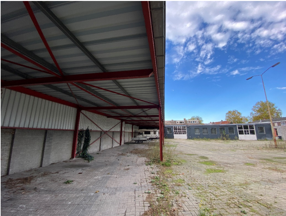
Figuur 5. Beeld van de overkapping aan de noordzijde van het terrein.
