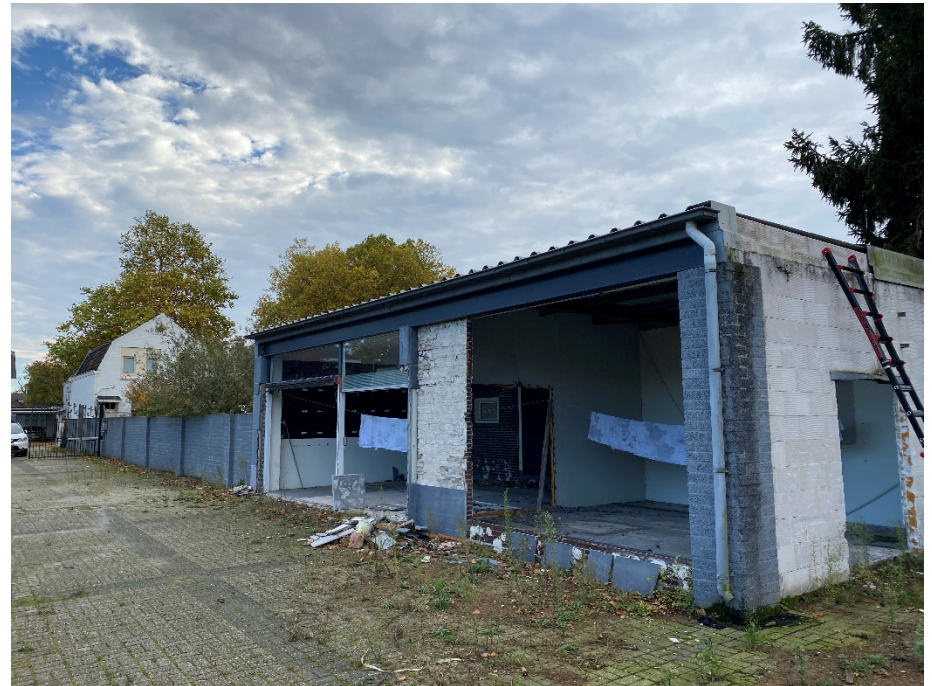
Figuur 3. Gedeeltelijke gesloopte oude showroom aan de westzijde van het terrein.
