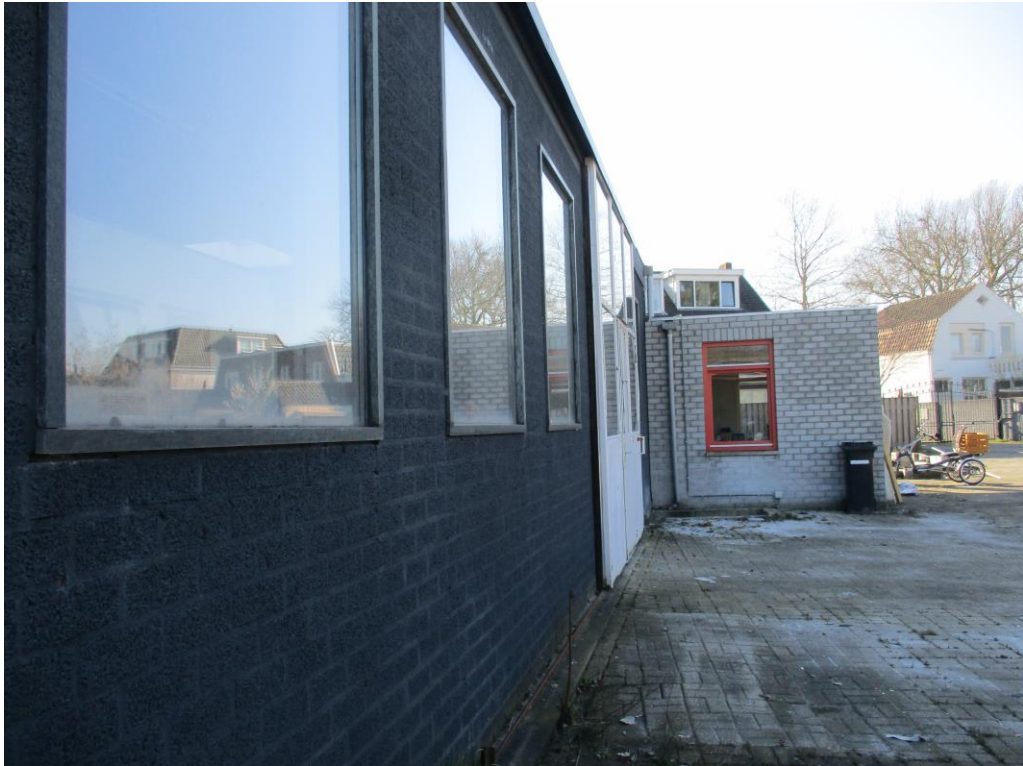
Figuur 3 Loods D en gebouw E.
