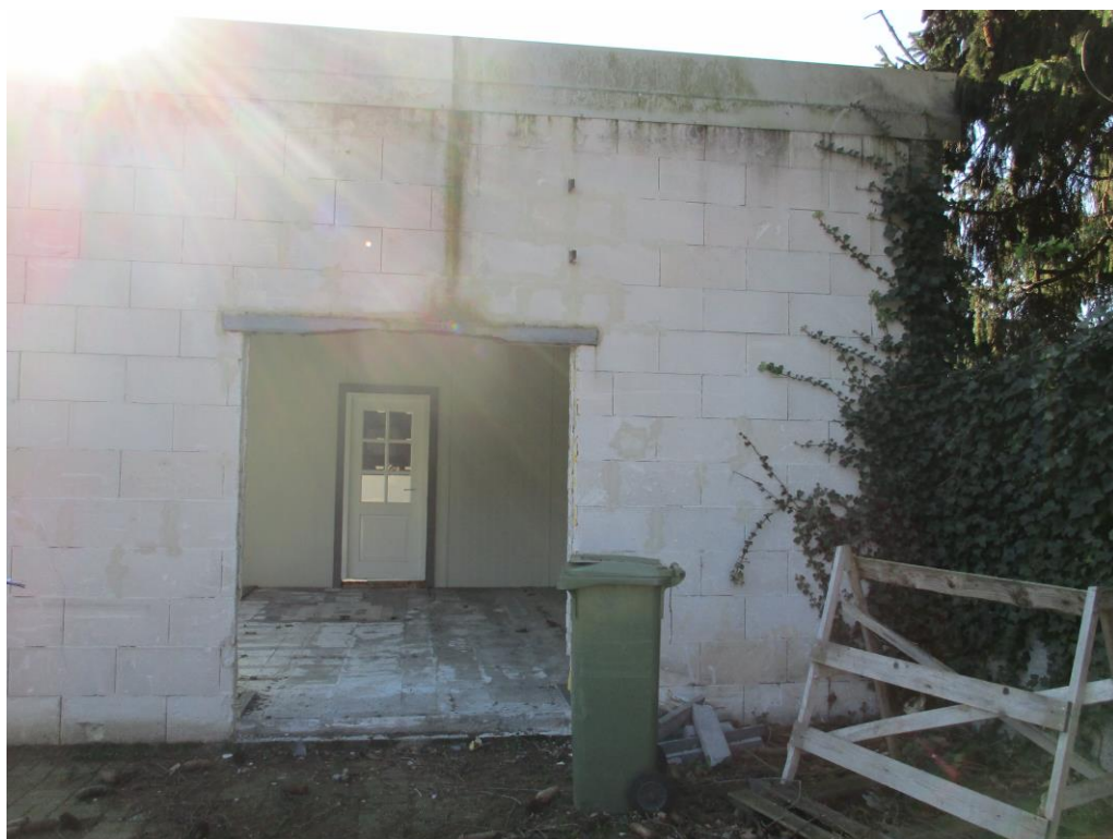
Figuur 2 Gebouw A.
