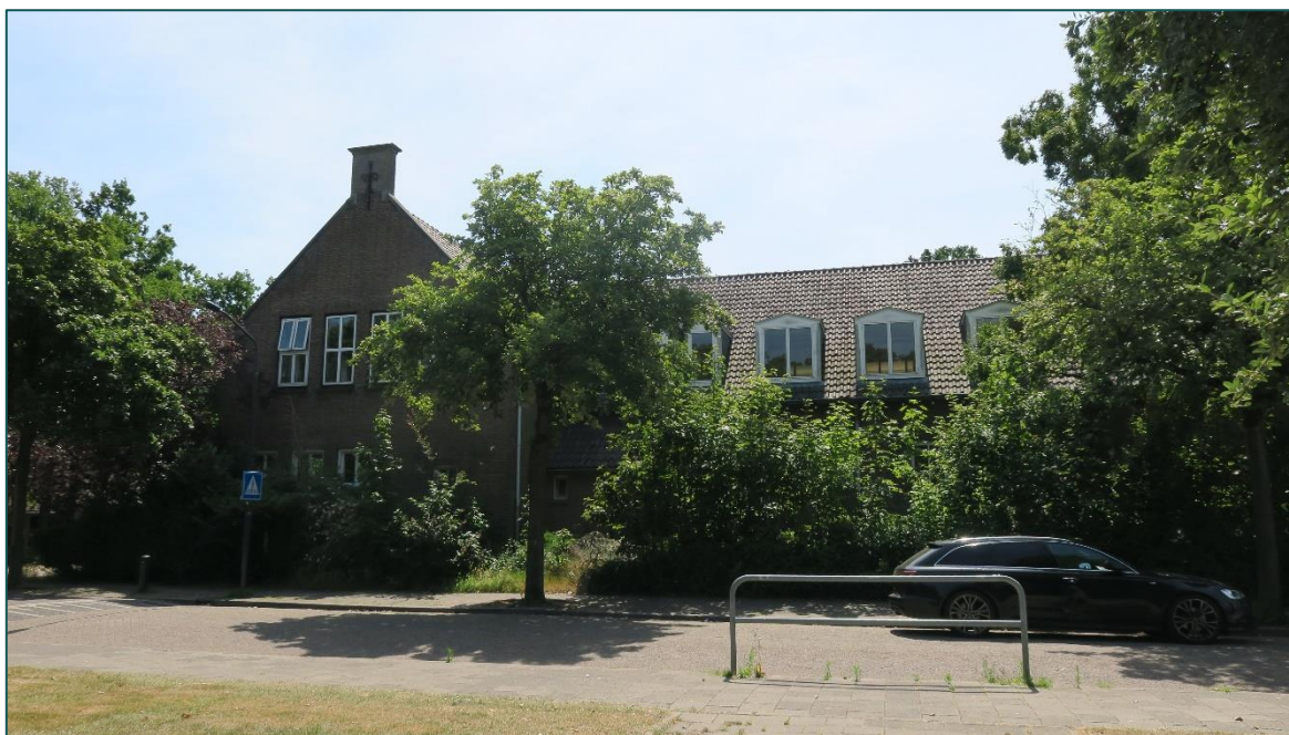
Figuur 1 De planlocatie is gelegen aan de Lidwinastraat 42 e.o. te Vught en bestaat uit twee voormalige schoolgebouwen en een gymzaal. De beoogde ruimtelijke ingreep betreft het renoveren en slopen van de bebouwing t.b.v. de realisatie van 50 tot 60 woningen.
