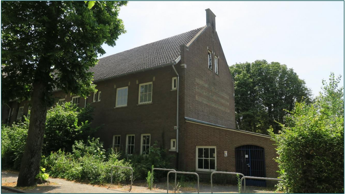
Figuur 3 Het noordelijke gelegen schoolgebouw welke deels wordt gerenoveerd en deels gesloopt.
