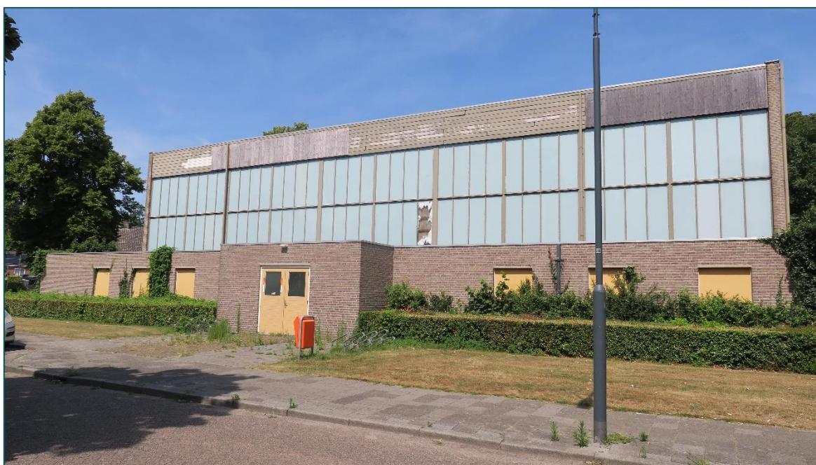
Figuur 2 De te slopen gymzaal.
