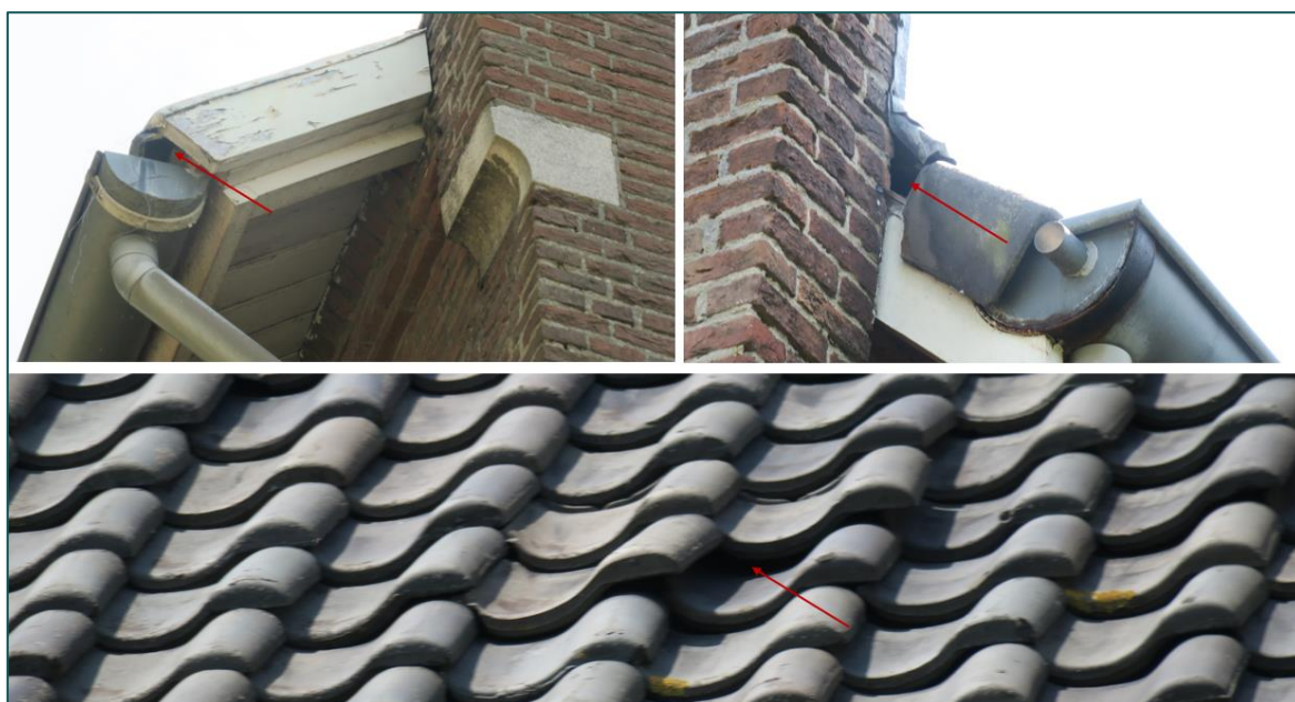
Figuur 3.3 De dakruimte van de schoolgebouwen is toegankelijk voor de gierzwaluw middels openingen nabij de dakvoet en losliggende dakpannen.
