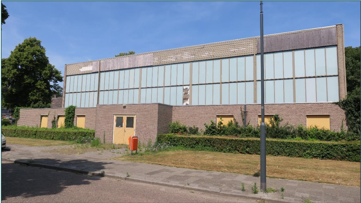
Figuur 1.4 De te slopen gymzaal.
