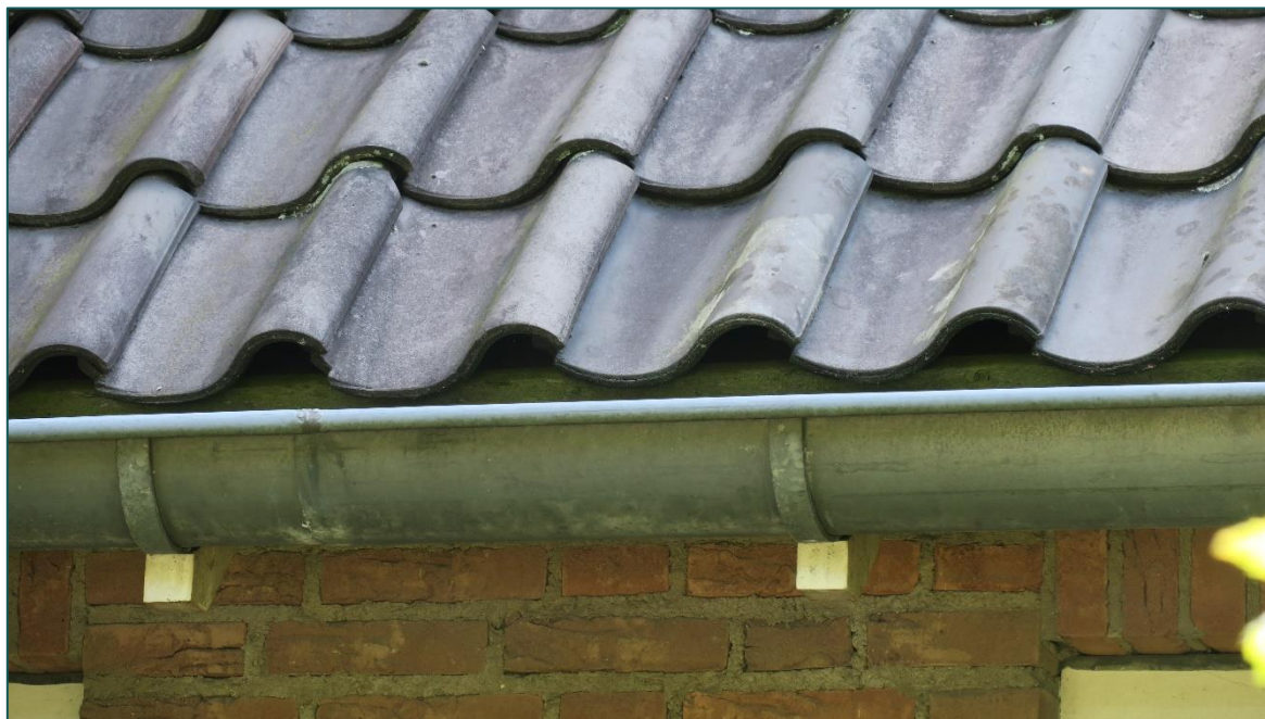
Figuur 3.2 Beide schoolgebouwen beschikken over een toegankelijke dakruimte via de dakvoet.
