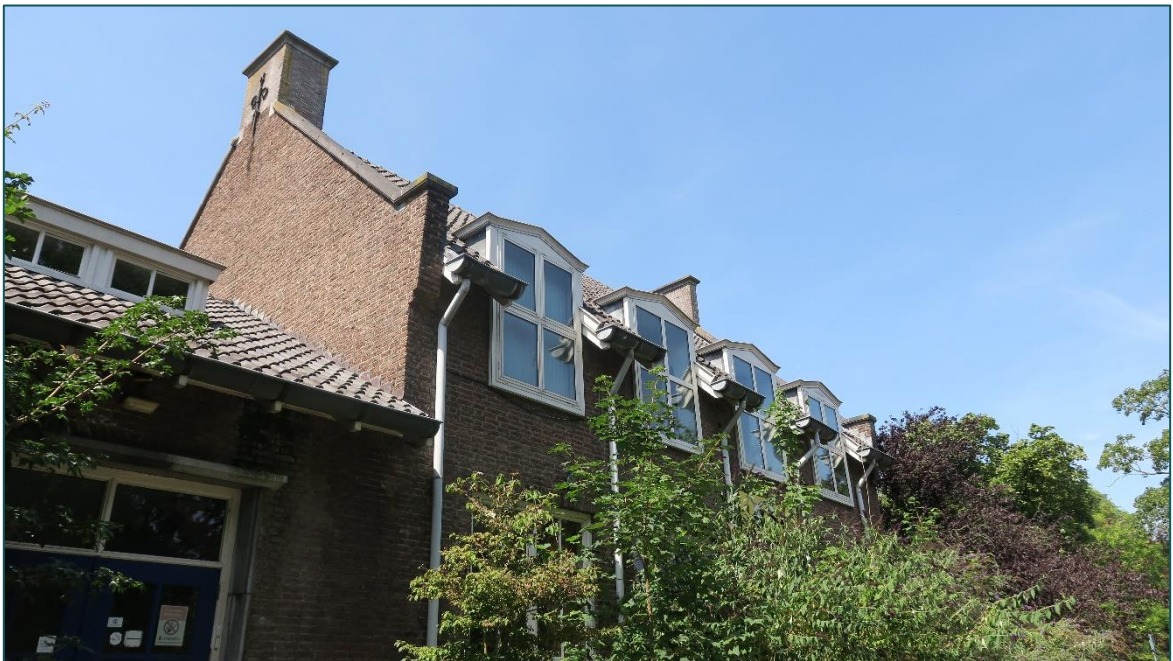
Figuur 4 Het zuidelijk gelegen schoolgebouw welke gesloopt zal worden.
