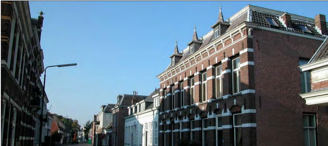
historische bebouwing Taalstraat
