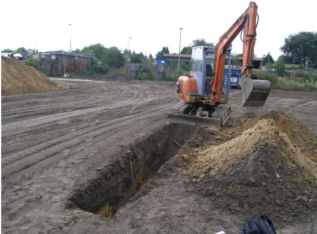
afb. 2 Het graven van de proefkuilen met behulp van een minigraver.
