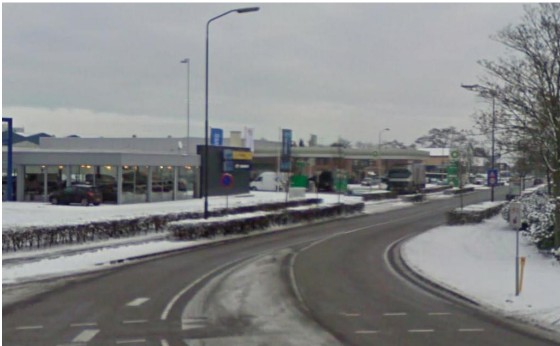
F 5 Het LPG-station aan de N.C.B.-laan 117c, Veghel (bron: Google Earth)
