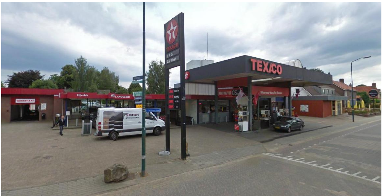
Figuur 7.2 Het LPG-station aan de Cruijgenstraat 34, Erp (bron: Google Earth)
