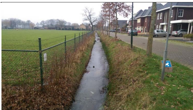
Figuur 4.11 Foto van de sloot tussen Steenoven II en de straat Ringoven. Rechts de woningen van Steenoven I fase 3 (bezoek plangebied op 21 januari 2016)
