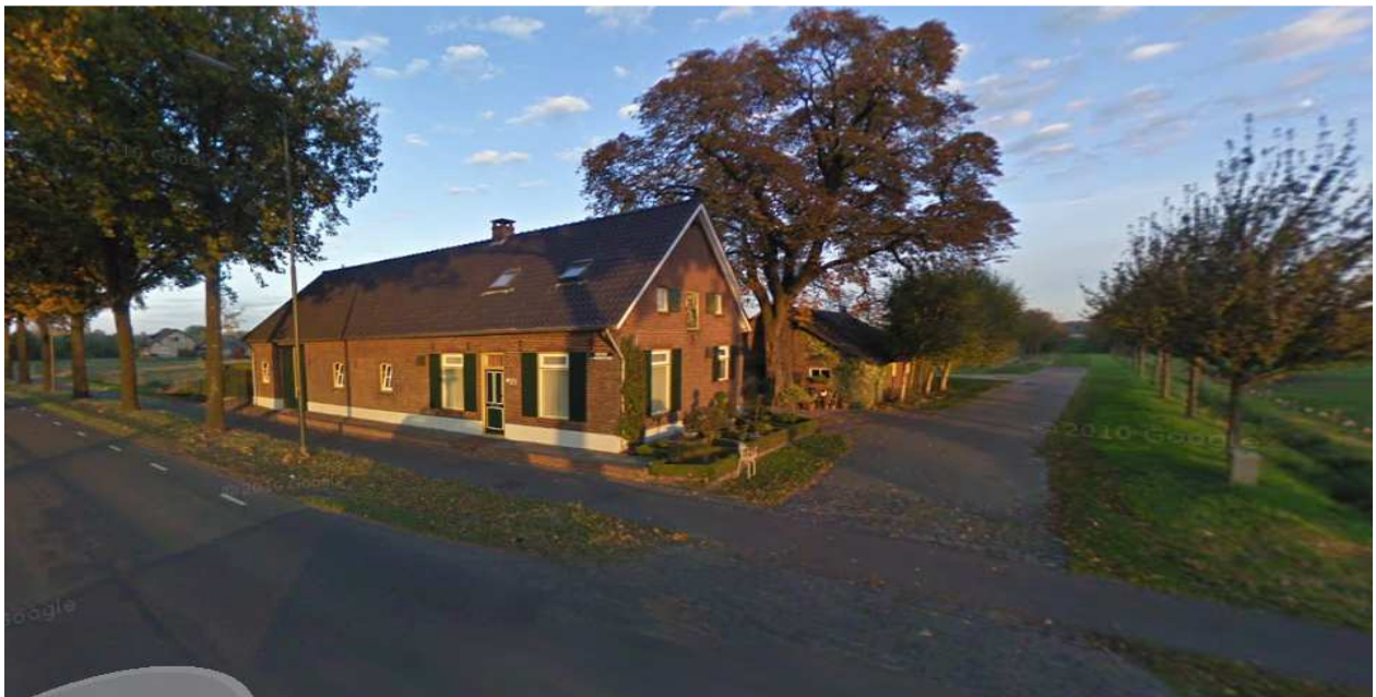
Figuur 2.1: de voormalige langgevelboerderij met daarachter de bergschuur
