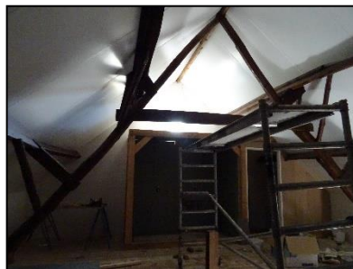
Figuur 8. Nieuwe dakisolatie en dakbeschoot in de aangrenzende schuur (binnenkant).
