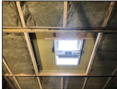
Figuur 5. Isolatie tegen het oorspronkelijke dak aan tijdens verbouwing.
