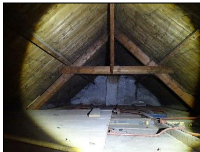
Figuur 2. Houten zolderdak met dwarsbalken.
