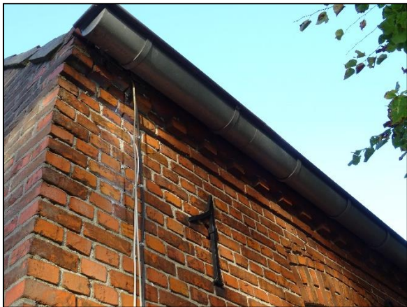
Figuur 10. Dakgoot aan de voorkant van het woonhuis.
