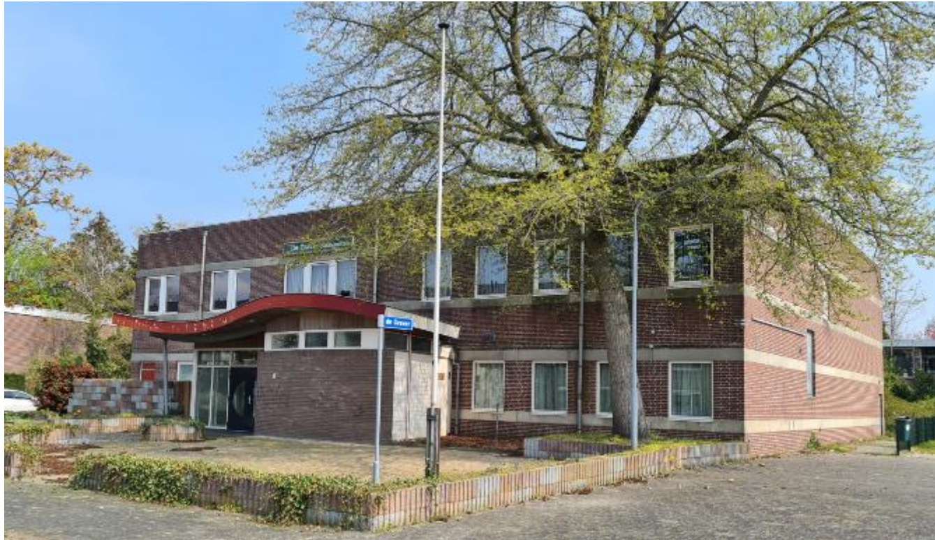
Figuur 1: Plangebied gezien vanuit het westen
