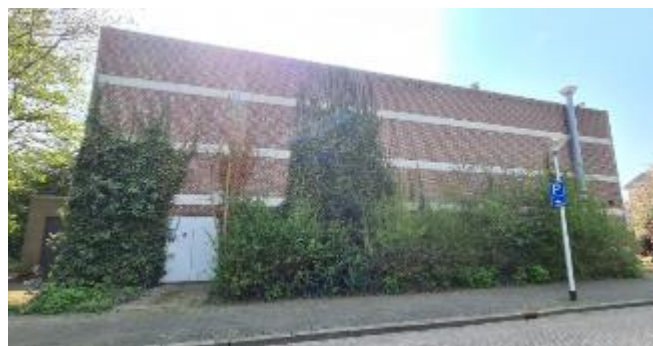
Figuur 5: Noordgevel van het zalencentrum
