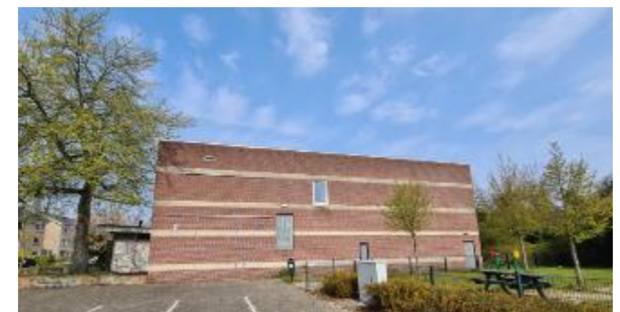
Figuur 6: Zuidgevel van het zalencentrum
