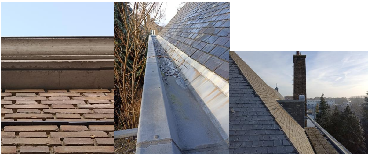
Figuur 4.4.2. Een beeld van de onder- en bovenzijde van de dakgoten.
