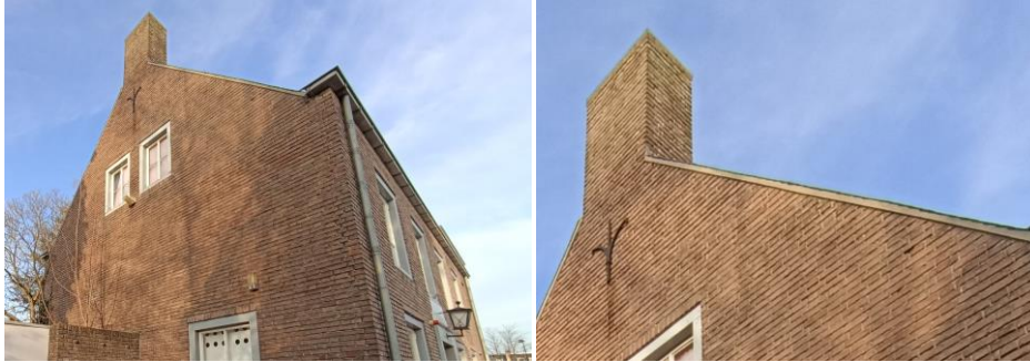
Figuur 4.4.1. Een beeld van de kopgevel en de afwerking met specie aan de bovenzijde.
