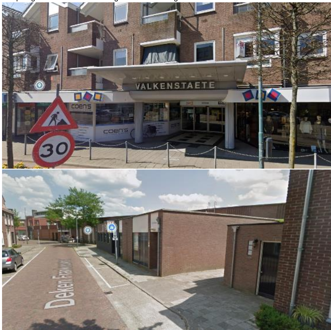
Figuur 4.1: Weergave huidige situatie. Figuur boven geeft weergave vanuit de Eindhovenseweg. Figuur beneden geeft weergave vanuit de Deken Frankenstraat.
