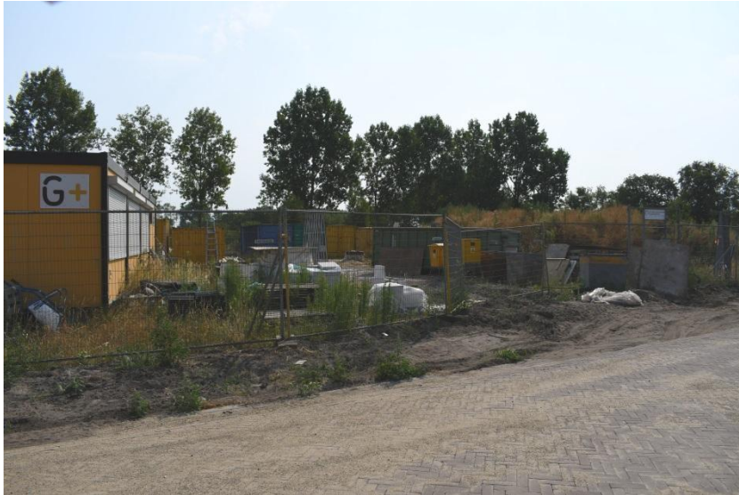
Foto 3: Deelgebied 2 - noordelijk gedeelte (links bouwkeet rechts opslag bouwmaterialen)
