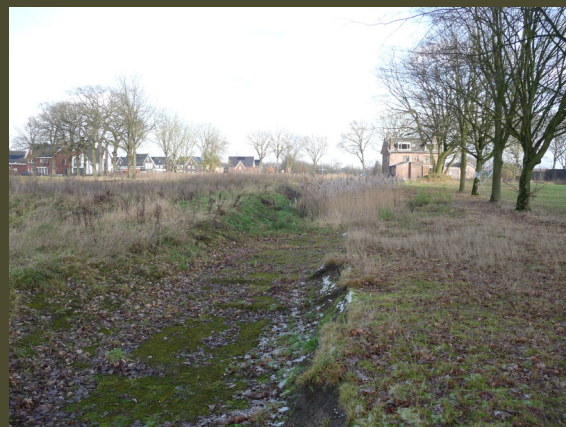
nieuw gegraven waterberging aan noordzijde perceel
