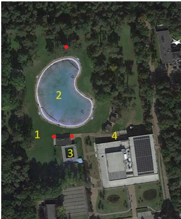
f 5.1 Situering zwembad te Valkenswaard. De ligweide (1), het grote zwembad (2), kleine zwembad (3), het terras (4) en muziek-, omroepinstallatie (rood)
