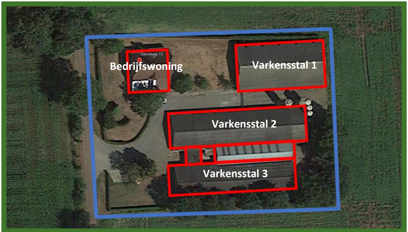
Bestaande situatie met te slopen bedrijfswoning en varkensstallen genummerd in rood. Bron: Google Maps
