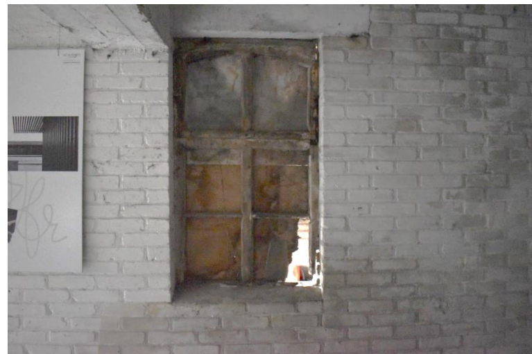
Gevelopening in de achtergevel van de magazijnruimte vanuit het interieur gezien.
