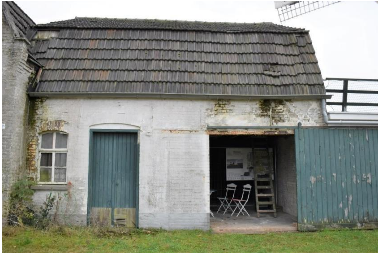
Voorgevel voormalige motormaaldery.
