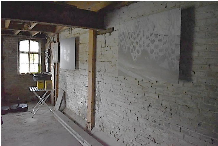
Begane grond voormalige motormaalderij richting het noorden georiënteerd.
