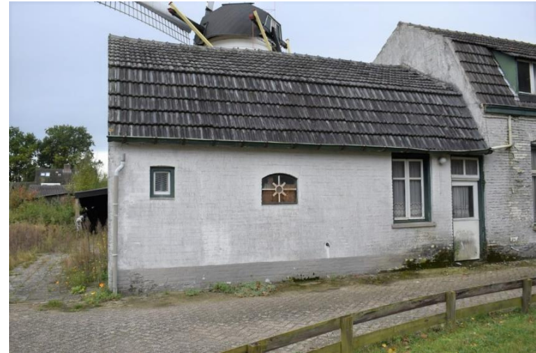
Later geplaatst houten toiletraam onder grotere getoogde rollaag.
