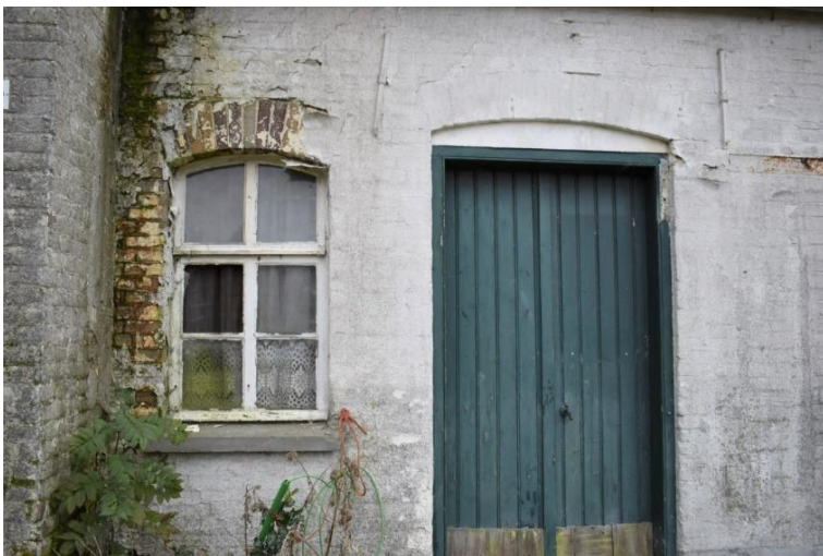
Houten vierruits schuifvenster met getoogd dubbel bovenlicht met betonnen dorpel onder rollaag en dubbele houten deur onder getoogde rollaag voorzien van gestucte boogvelden.
