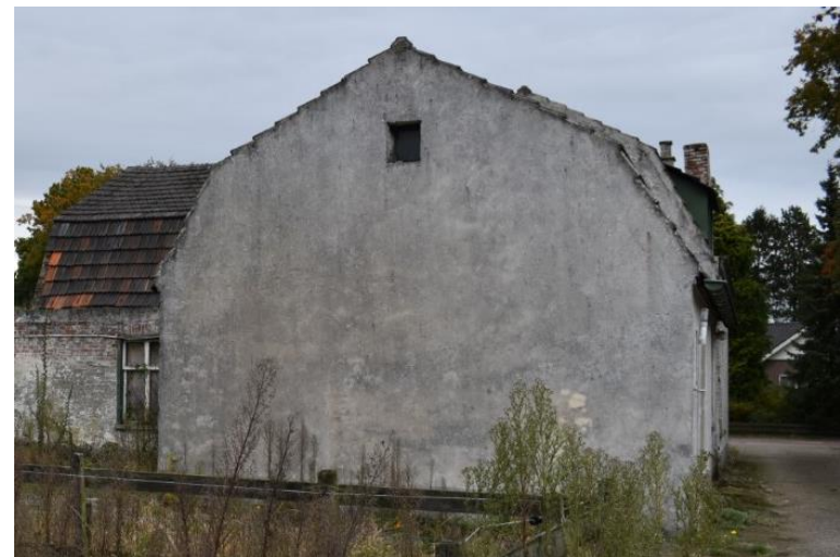
Achtergevel zuidelijk gedeelte van de molenwoning.
