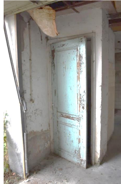
Bruynzeeldeuren uit de jaren dertig.
