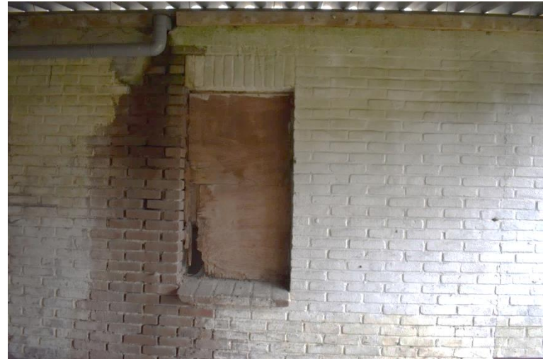
Gevelopening in de achtergevel van de magazijnruimte.
