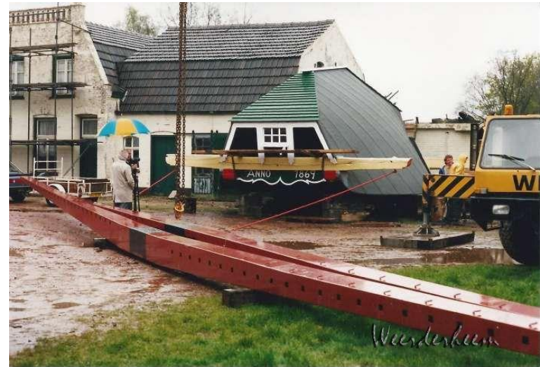
Historische foto uit 1989 waarop werkzaamheden aan de molenwoning zichtbaar zijn. Bron: Beeldbank Heemkundekring Weerderheem, nr. 25022.
