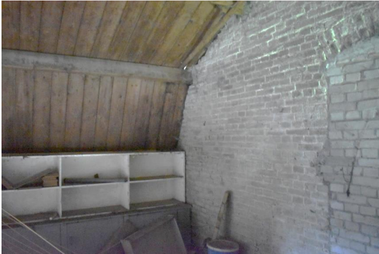
Gording met dakbeschot en rechts een dichtgemetselde gevelopening (westgevel).
