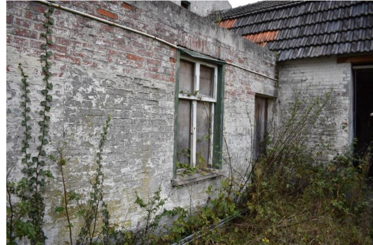
Houten tweeruits schuifvenster met dubbel bovenlicht.
