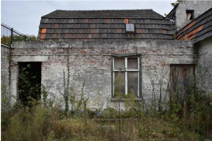
Achtergevel van de aanbouw aan de voormalige motormalderij.
