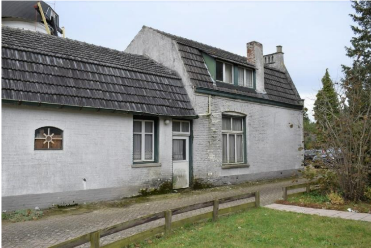
Houten stolpraam met horizontale roede en met hardstenen dorpel en een houten paneel deur.
