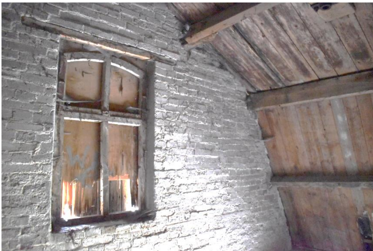
Een dichtgezette gevelopening in de westgevel van de voormalige motormalderij.
