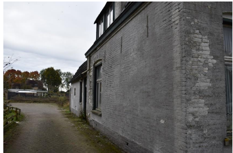
Muurankers ter hoogte van de eerste verdiepingvloer.
