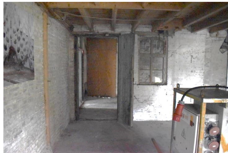
Begane grond voormalige motormaalderij richting het zuiden georiënteerd met de oorspronkelijke gevelopeningen.
