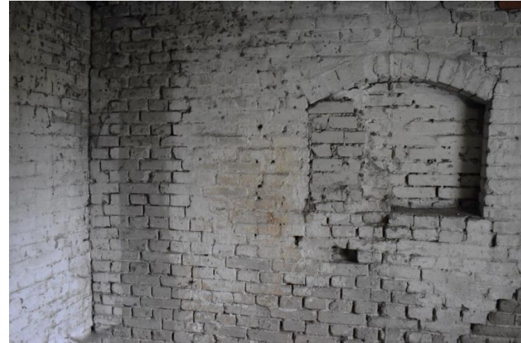
Westgevel van de voormalige motormaalderij gelegen naast de latere aanbouw aan de zuidzijde.
