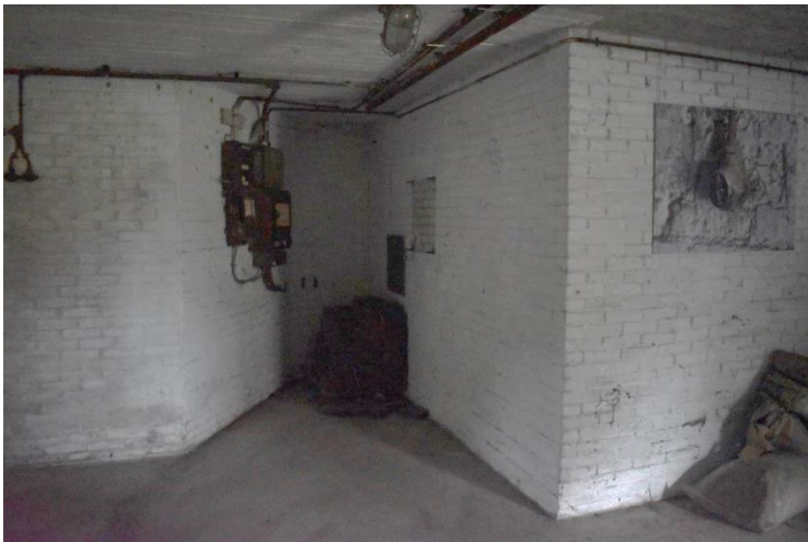
Magazijnruimte richting het westen georiënteerd.
