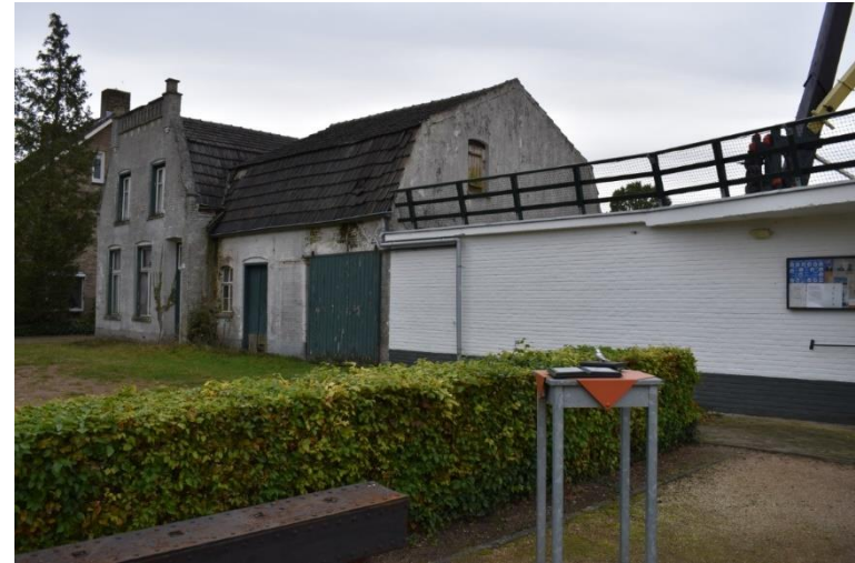
Later toegevoegde opgeklampte houten schuifdeur onder stalen latei en de blinde voorgevel van de magazijnruimte.
