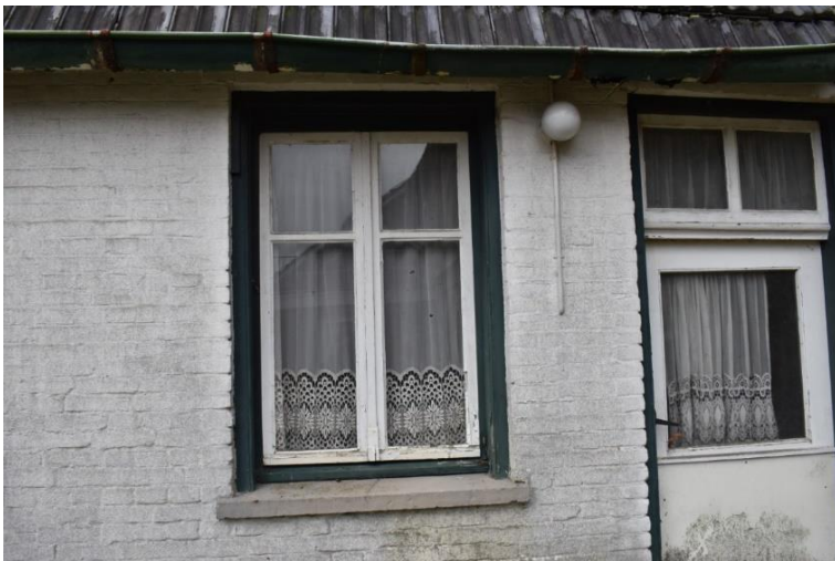
Houten stolpraam en een houten paneel deur.
