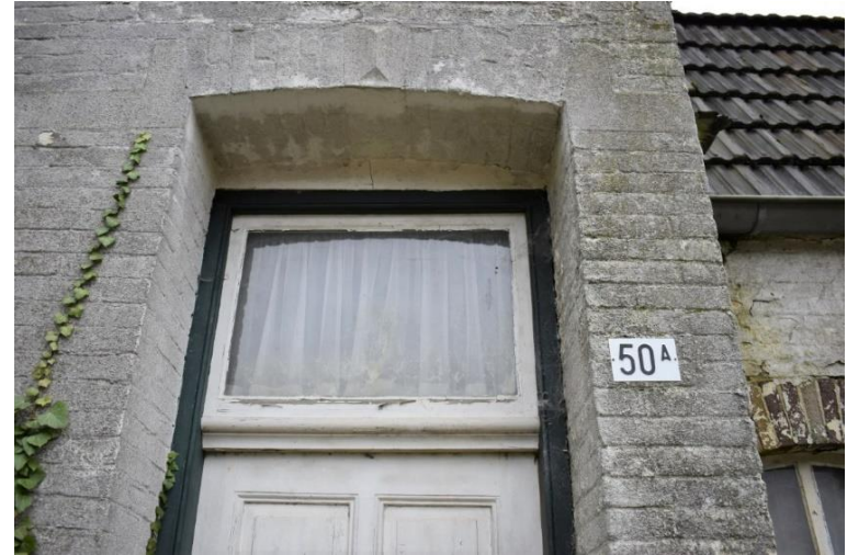
Ondiep portiek voorzien van een paneeldeur met bovenlicht. .
