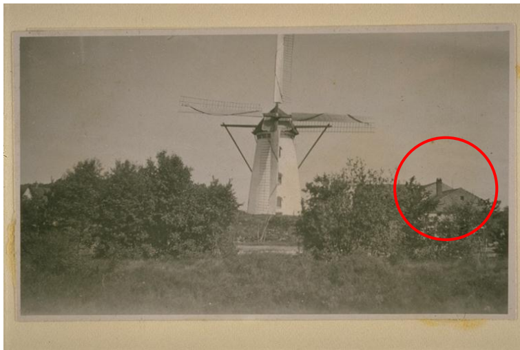
Historische foto uit na 1935. Rood omcirkeld de schoorsteen van het voorhuis van de molenwoning. Bron: BC Brabant-collectie, nr. 0836-037.
