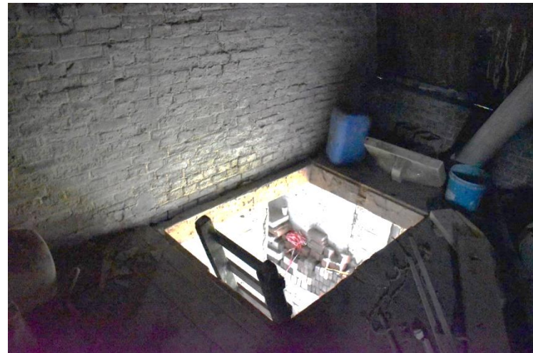
Trap richting de eerste verdiepingvloer van de voormalige motormalderij.
