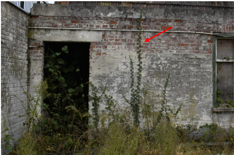
Links baksteen in kruisverband en rechts baksteen in halfsteensverband. Met rode pijl is aangegeven waar de overgang zich bevindt.
