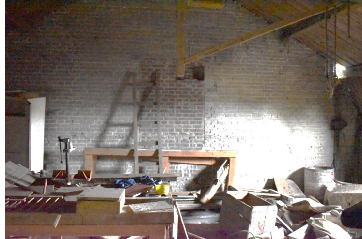
Een dichtgemetselde gevelopening in de oostgevel van de voormalige motormalderij.
