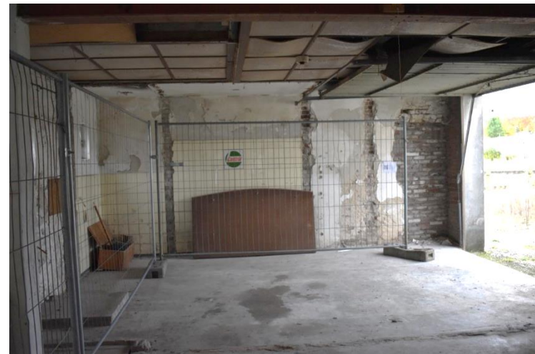
Begane grond zuidelijke gedeelte van de molenwoning richting het zuiden georiënteerd.
