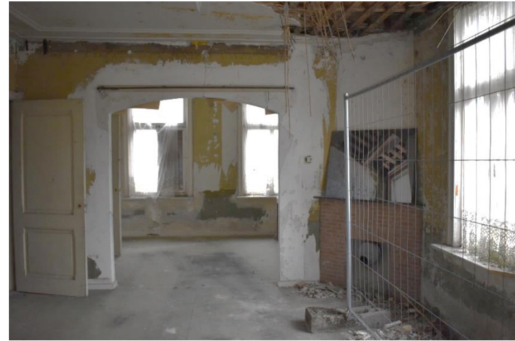
Begane grond noordelijke gedeelte van de molenwoning richting het noorden georiënteerd.
