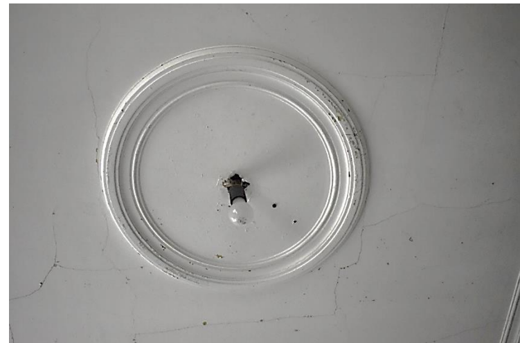
Plafondafwerking kamer aan de noordzijde.
