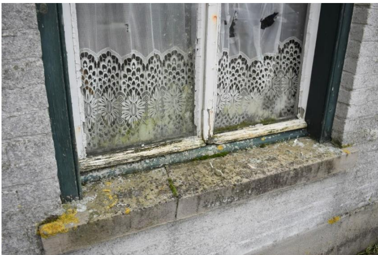
Houten stolpraam met hardstenen onderdorpel.
