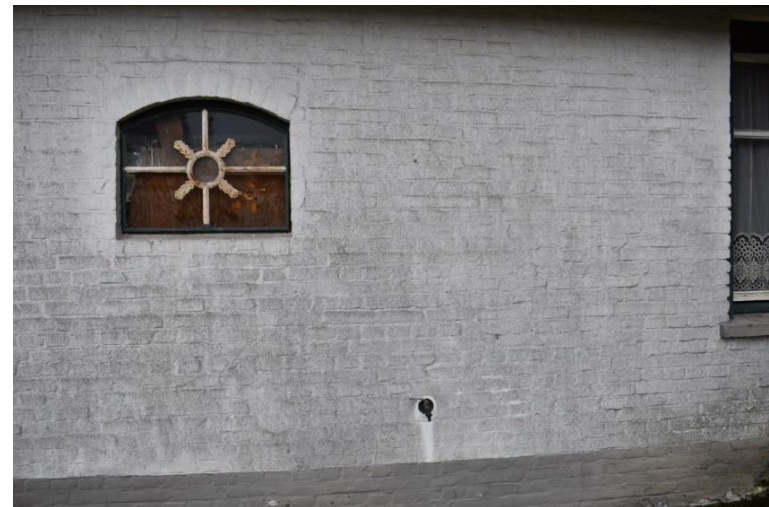
Gietijzeren getoogd spinraam onder rollaag.
