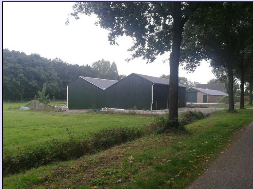
Figuur 2.1 Foto bestaande bebouwing
