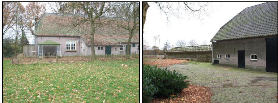
Figuur 6 Achterzijde bestaande woning en te verbouwen en te slopen bedrijfsruimte
