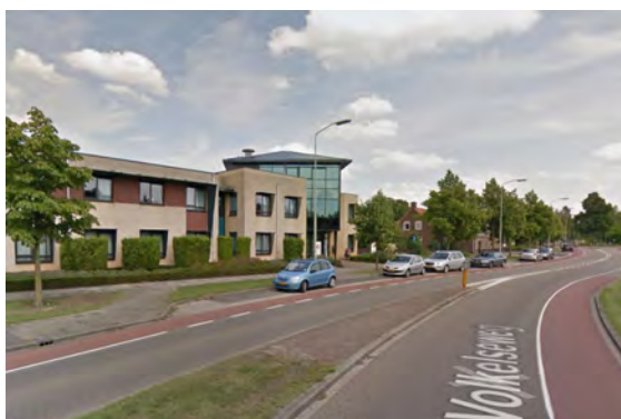
Kantoren en woningen ten oosten van plangebied (Volkelseweg)
