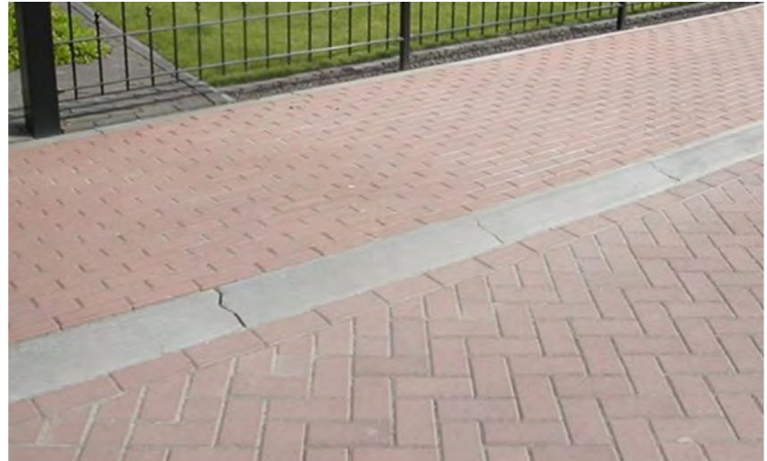
Rode betonklinkers en fietsopsluitbanden
