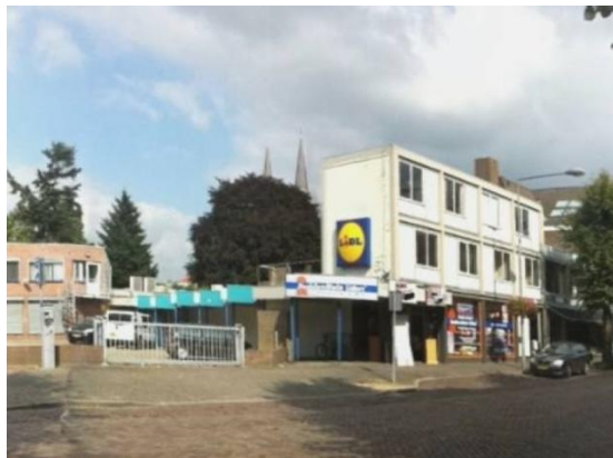
Foto bestaande situatie
