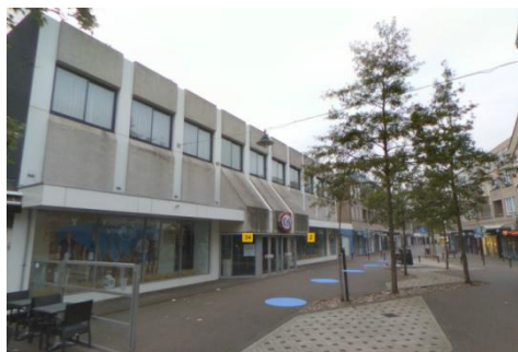
Bestaande situatie Sacramentsweg 2
