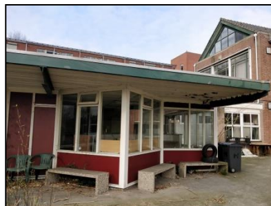
Figuur 4. Westzijde van het voormalige basisschool gebouw.
