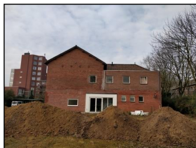
Figuur 7. Oostelijke zijde van het voormalige basisschool gebouw.
