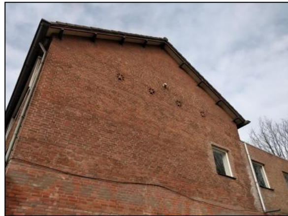
Figuur 13. Ruimtes langs de dakrand bieden toegangsmogelijkheden tot onder het dak. Luchtgaten bieden toegangsmogelijkheden tot de spouwmuur en tot het gebouw.
