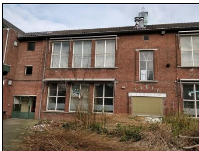
Figuur 3. Zuidzijde van het voormalige basisschool gebouw.
