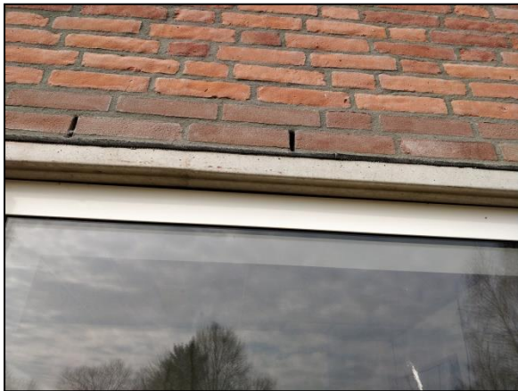
Figuur 12. Stootgaten bieden toegangsmogelijkheden tot de spouwmuur.
