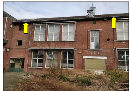
Figuur 10. Ruimtes tussen het dak en de dakgoot bieden potentieel geschikte ruimtes voor de huismus.
