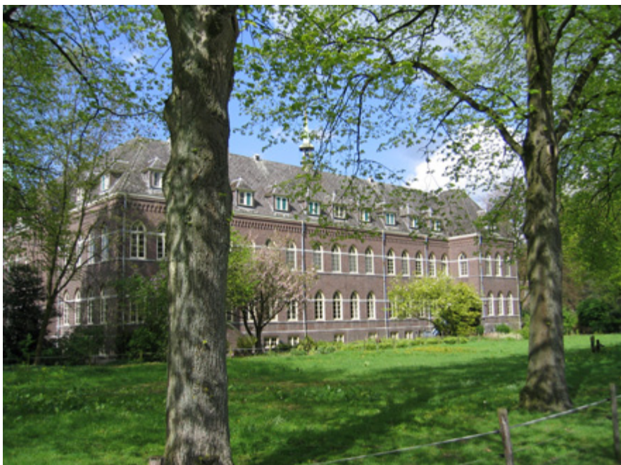
hoofdgebouw Adbij (zuidwestzijde)
