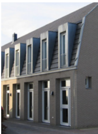
dakkapellen in lage deel mansardekap
