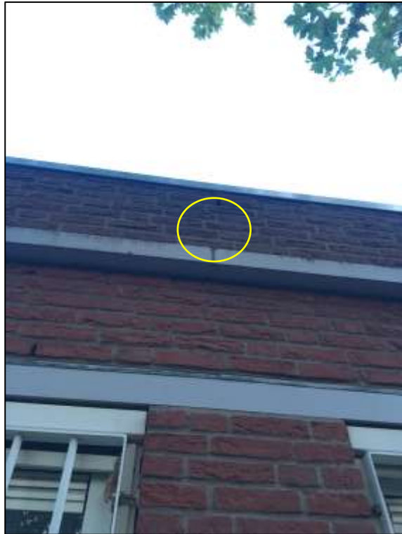
Foto 2. Open stootvoeg aan de zuidoostkant van het zuidelijke gebouw die toegang geeft tot de spouw en wordt gebruikt als zomerverblijfplaats van de gewone dwergvleermuis (gele cirkel)
