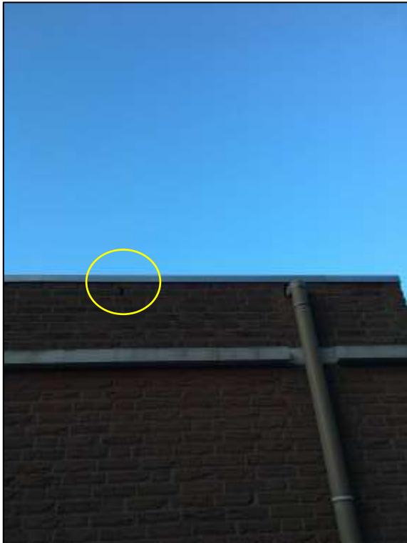
Foto 1. Open stootvoeg aan de noordkant van het zuidelijke gebouw die toegang geeft tot de spouw en wordt gebruikt als zomerverblijfplaats van de gewone dwergvleermuis (gele cirkel)
