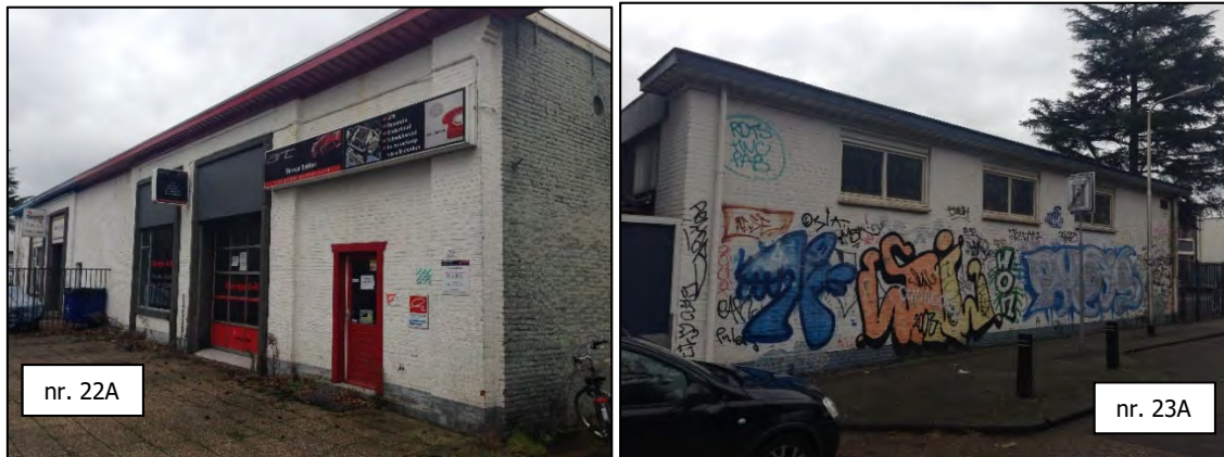
Figuur 2.2 Aanzicht bestaande bebouwing aan de Zuid-Oosterstraat te Tilburg
