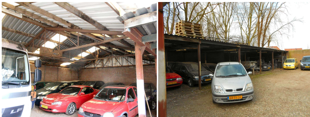
Figuur 7. De open garage biedt geen geschikte verblijfplaatsen voor vleermuizen.
