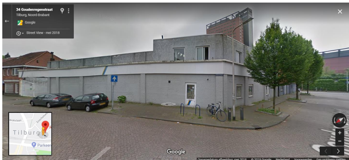
Figuur 3: Westelijke bouwblok vanuit het noorden (Streetview opname mei 2018)
