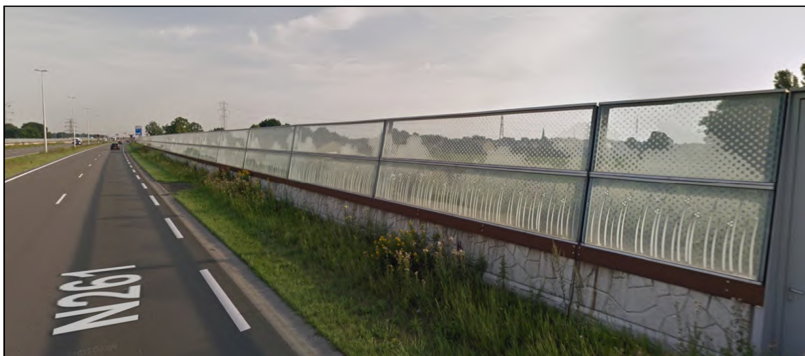
Figuur 4.3: Geluidsscherm Burgemeester Bechtweg ter hoogte van plangebied 'Enschotsebaan'
