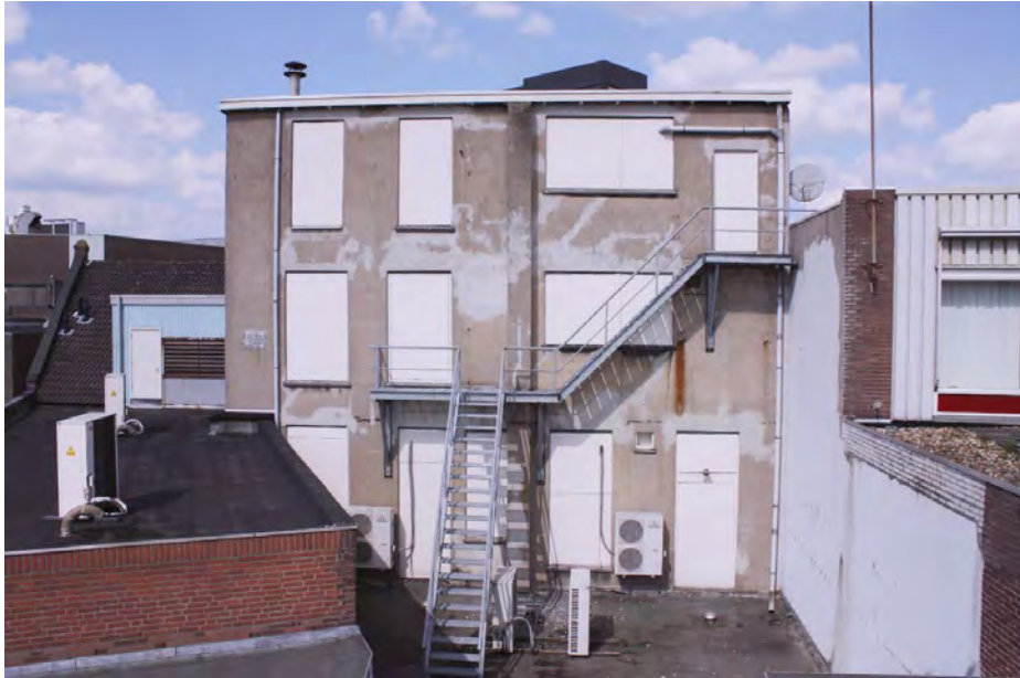
Zicht op de achtergevel van de voorbouw met de afgetimmerde gevelopeningen en brandtrap uit 1961.
