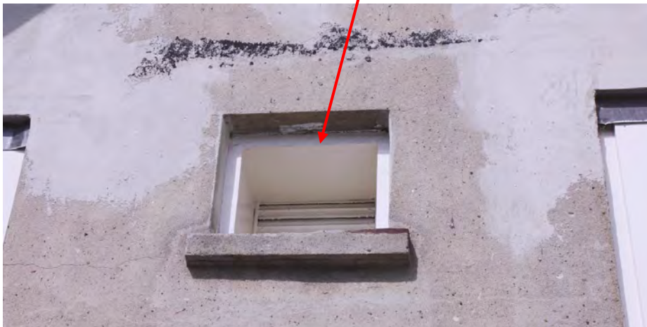
Detail van het ventilatierooster op de eerste verdieping.
