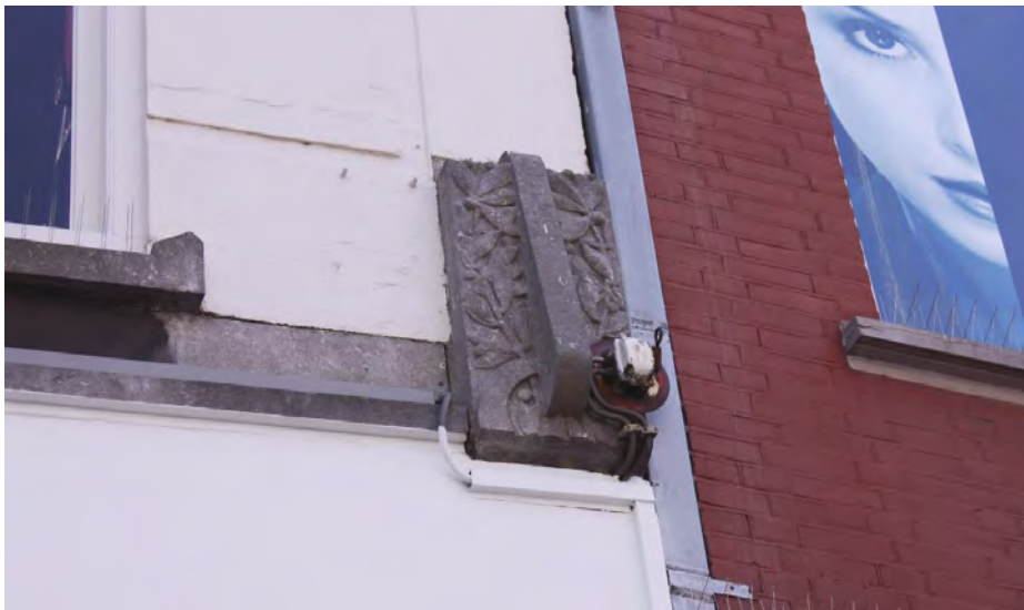
Detail van de hardstenen deksteen aan de rechterzijde.
