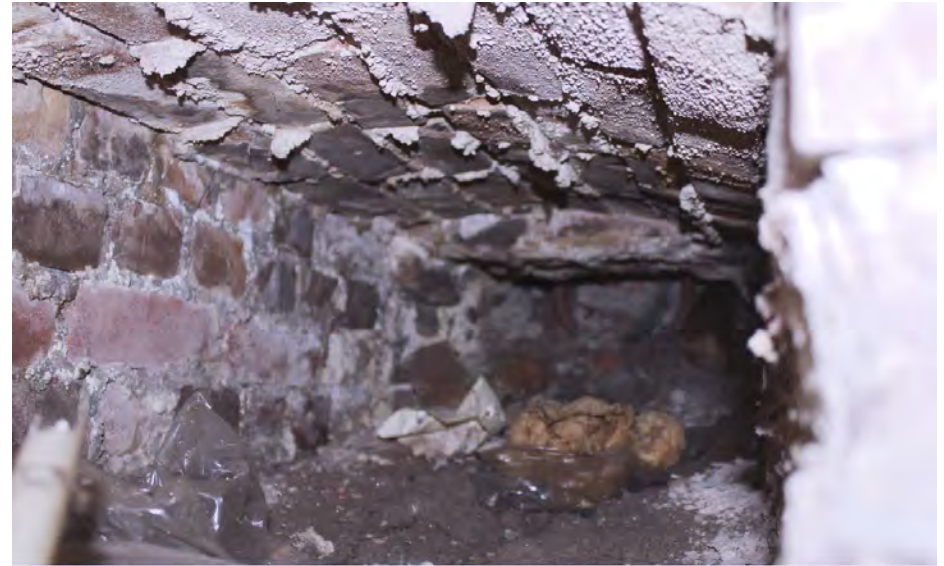
Achter het rooster is een gewelfde ventilatieschacht.
