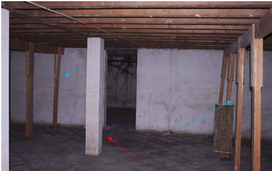
De vloerconstructie van de begane grond vloer bestaat uit een enkelvoudige balklaag, die later is voorzien van een houten onderslag met stijlen (blauwe pijl). De omtimmerde kolom is nog wel oorspronkelijk (rode pijl).
