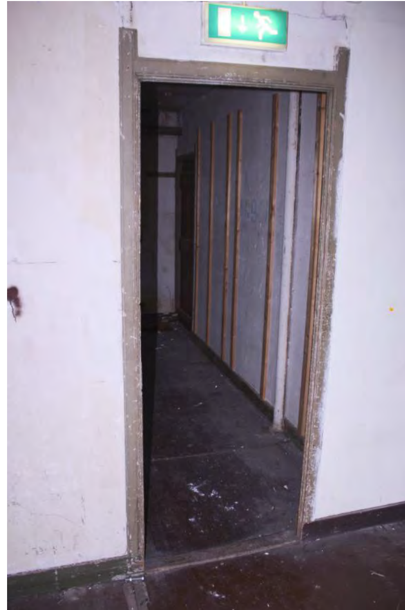
Oorspronkelijk deurkozijn naar de linker ruimte tegen de achtergevel in de binnenwand uit 1905.
