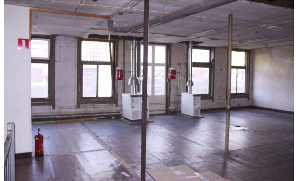
Derde verdieping gezien richting de voorgevel.
