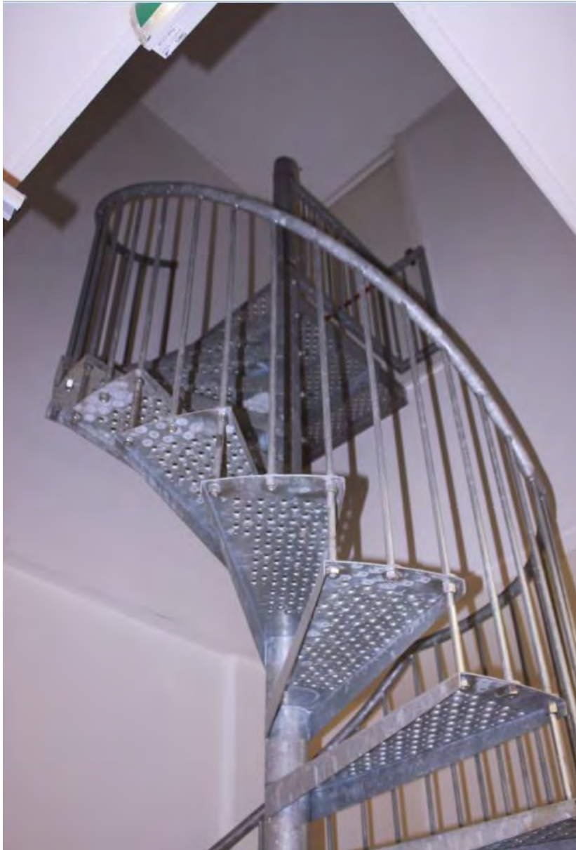
De stalen wenteltrap aan de achterzijde van de begane grond.
