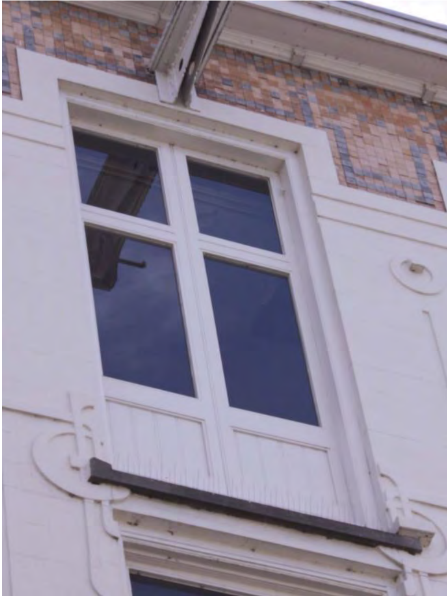
Detail van de later aangebrachte stolpdeuren op de bovenste verdieping zijn een kopie van de oorspronkelijke deuren.
