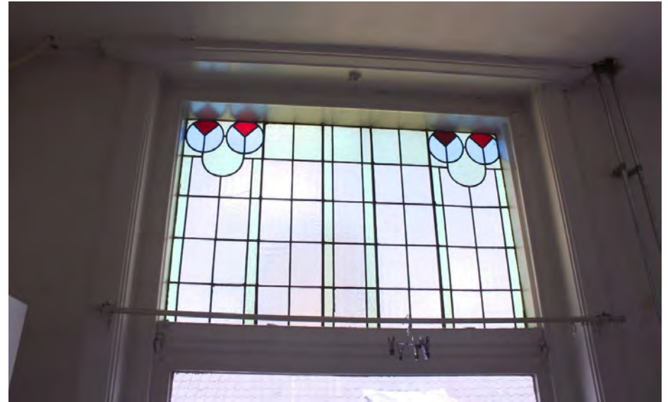
Detail van het glas in lood bovenlicht in het rechter venster op de tweede verdieping.
