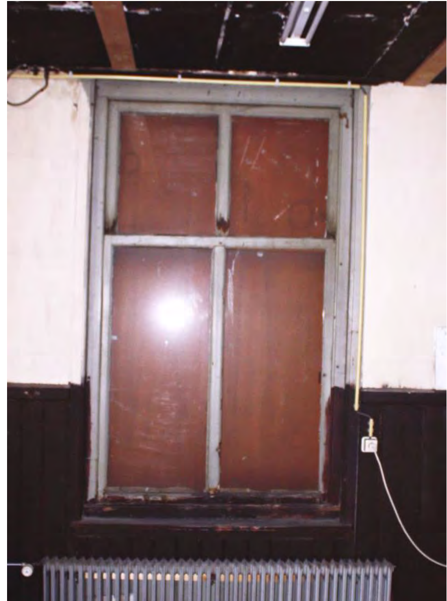
Zicht op de binnenzijde van het rechter venster op de tweede verdieping. Het oorspronkelijke schuifraam en bovenlicht zijn nog aanwezig.
