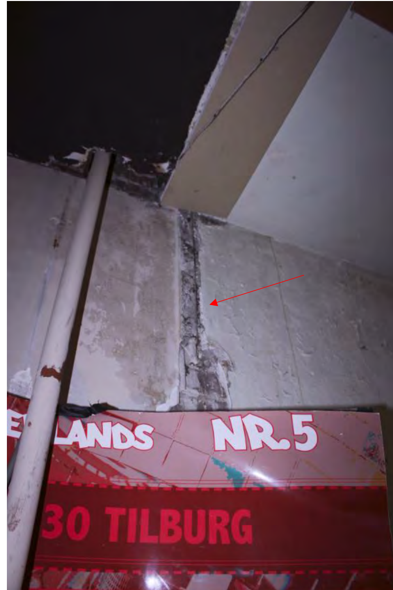
De afdruk van de oorspronkelijke scheidingsmuur bij de partiekamer en de trapgang naar de derde verdieping.
