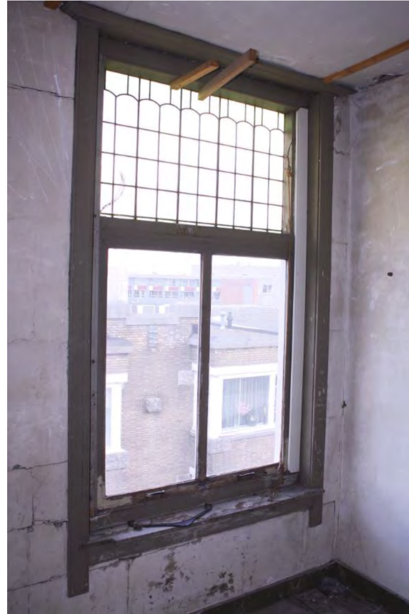
Het linker venster op de bovenste verdieping heeft een dubbelruits schuifraam en glas in lood bovenlicht.
