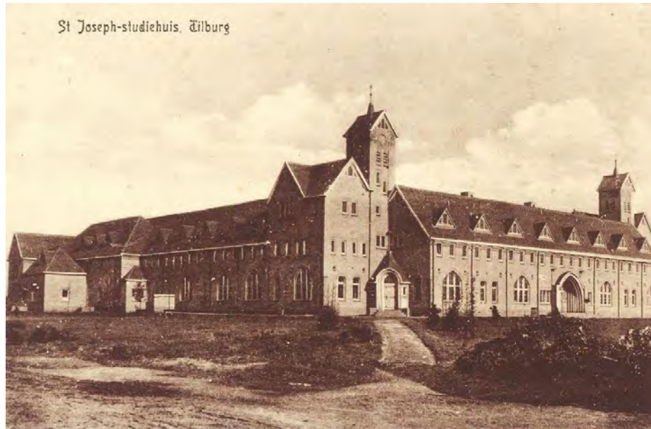
St. Josephstudiehuys van de St. Josephcongregatie van Mill Hill, gebouwd in de jaren 1914/1915. Het gebouw stond weldra bekend als 'de rooi pannen'. GAT 000365.
