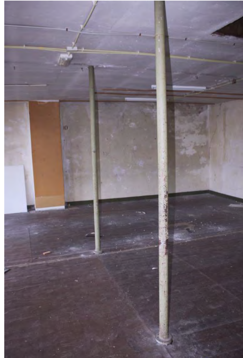
De ronde kolommen met basementen op de derde verdieping.
