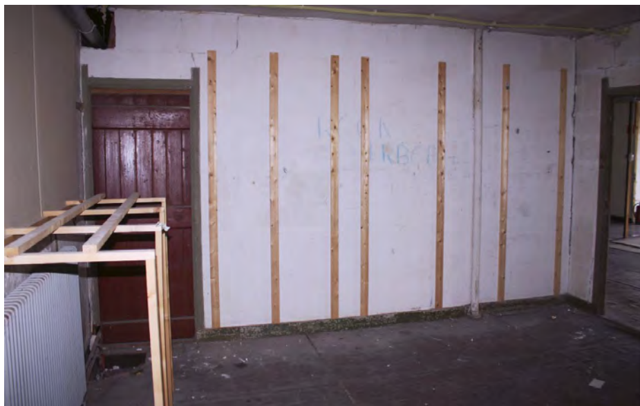
De linker ruimte tegen de achtergevel met doorgang in de scheidingsmuur, gezien richting de rechtergevel.
