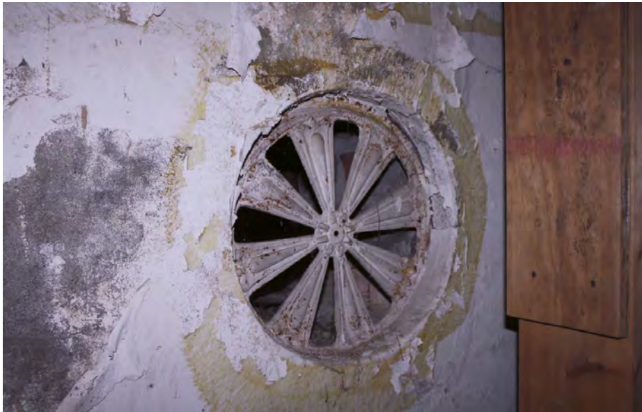
Detail van het ventilatierooster in de achtergevel van de kelder.
