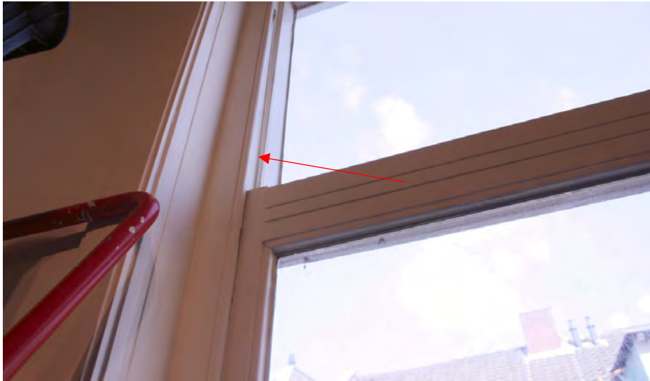
Detail van de binnenzijde van het rechter venster op de eerste verdieping, uitgevoerd met het oorspronkelijke vaste bovenlicht en doorlopende peerkraal.
