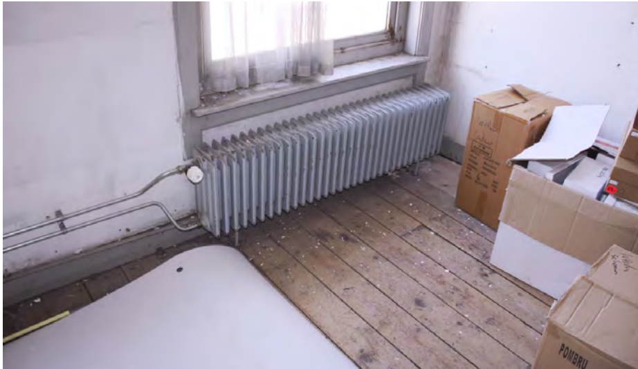
De oorspronkelijke ondervloer op de tweede verdieping bij het linker venster.
