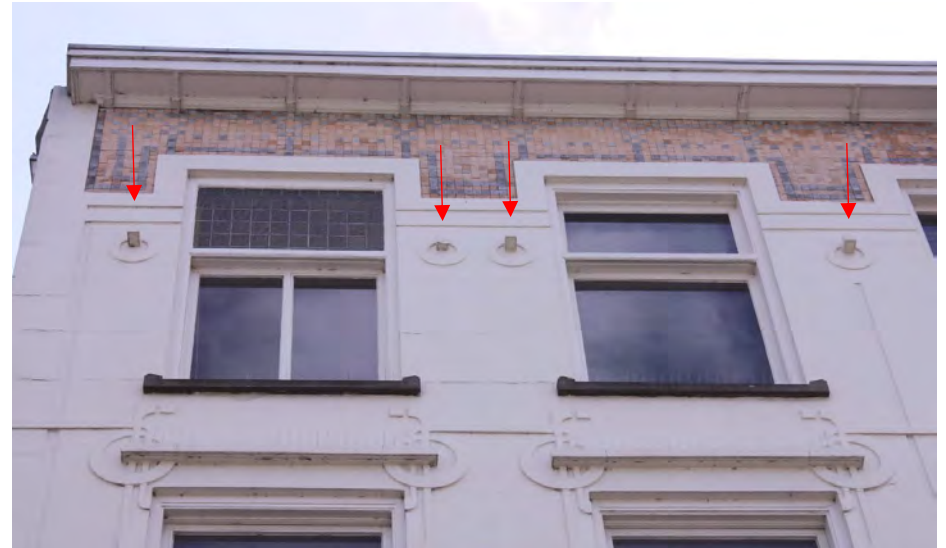
Tussen de bovenste vensters zijn ringen in het pleisterwerk opgenomen, die lijken te zijn opgehangen aan uitstulpingen.
