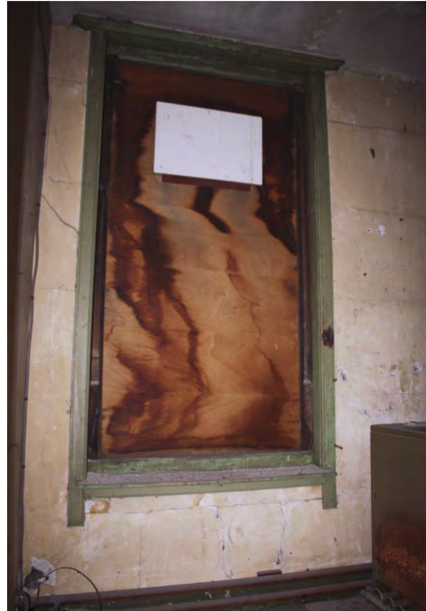
Het rechter venster op de derde verdieping bezit nog wel het oorspronkelijke raamkozijn met doorlopende stijlen.
