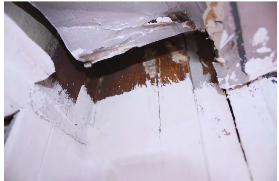
De kleurstelling van de raamkozijnen op de eerste verdieping zou uit een houtimitatie kunnen bestaan, zoals hier zichtbaar is bij het tweede raam van links.
