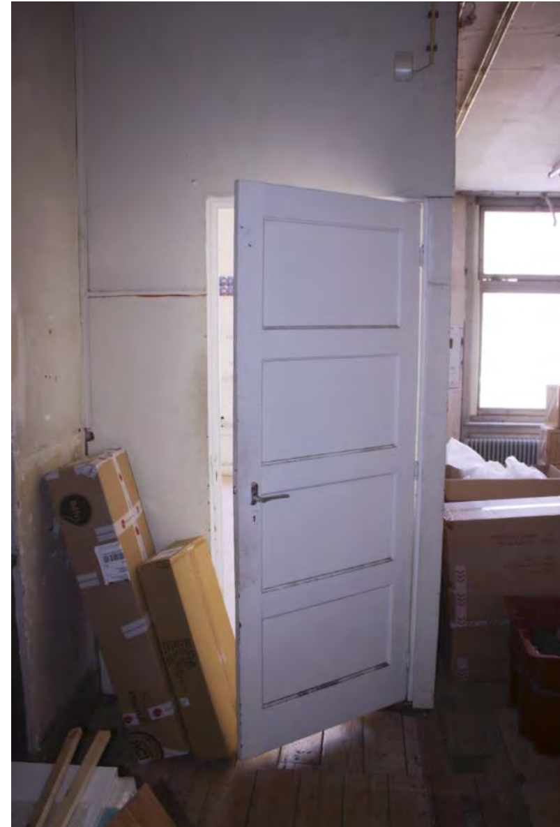
De afsluiting middels een Bruynzeeldeur bij de ruimte tegen de rechterzijde van de voorgevel.
