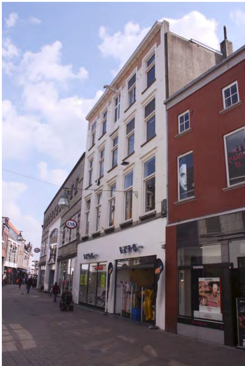
Zicht op de voorgevel van Heuvelstraat 20, gezien richting de Heuvel.
