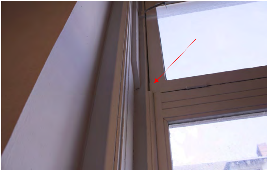
Detail van het tweede vensters van links op de eerste verdieping, uitgevoerd met een kiepraam. De peerkraal is hiervoor deels afgezaagd.
