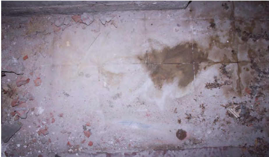
Detail van de tegelvloer ter hoogte van de voormalige kasten tegen de rechter gevel.
