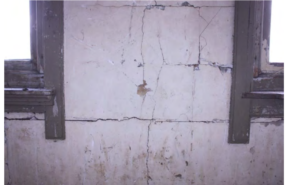
Detail van de vensterbank met architraaflijst (links) onder het tweede venster van links in de voorgevel op de derde verdieping.
