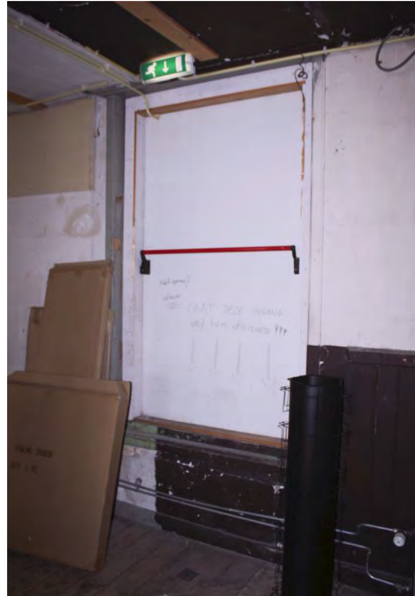
Het tweede venster van rechts op de tweede verdieping was van oorsprong een raam maar is later ingezet met een deur. Het oorspronkelijke kozijn is nog wel aanwezig.
