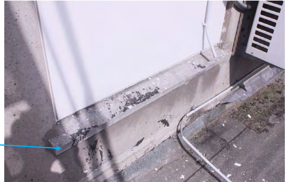
Detail van de hardstenen onderdorpel bij het tweede venster van links, gezien vanaf de Heuvelstraat.
