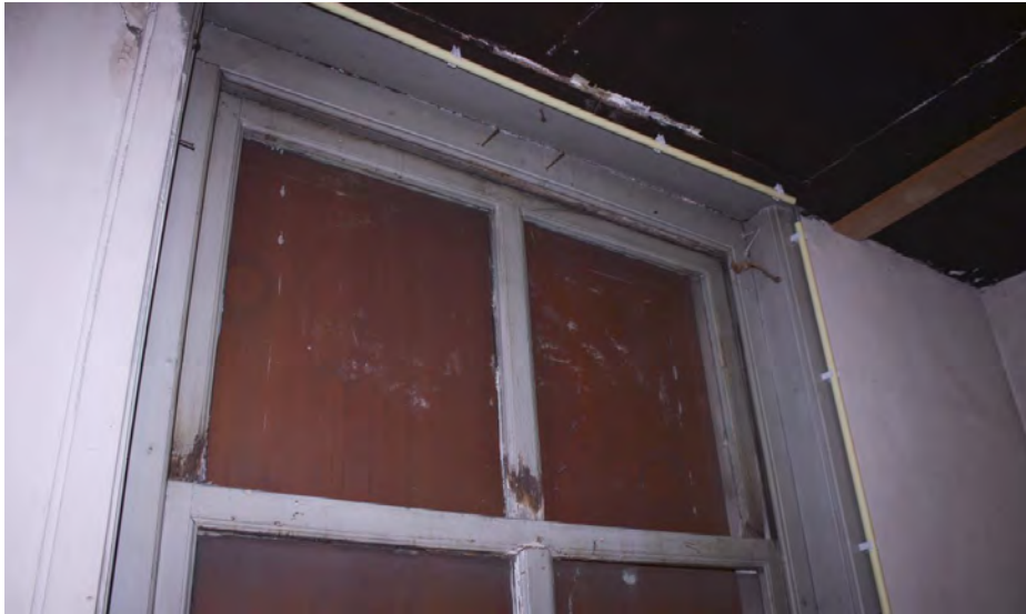
Detail van het bovenlicht bij het rechter venster op de tweede verdieping.
