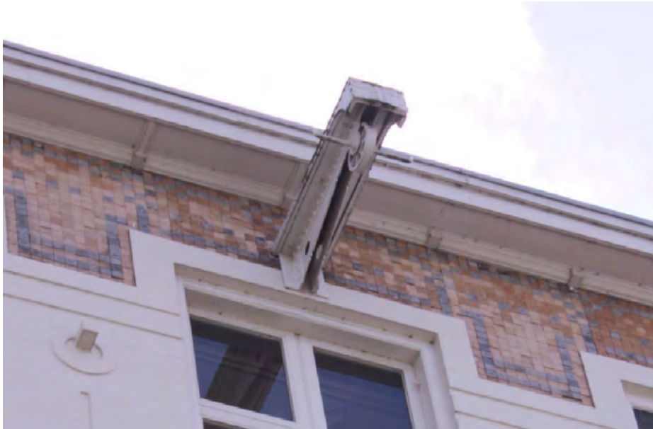
Centraal in de voorgevel is op de bovenste verdieping een hijsbalk met katrol op ijzeren consoles aanwezig.
