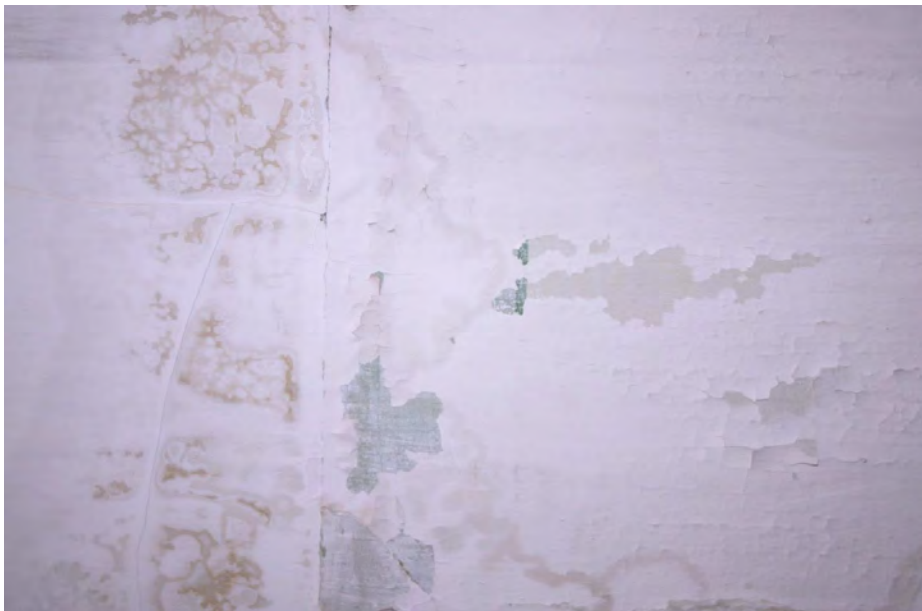
Boven de linker ruimte tegen de achtergevel is een oorspronkelijk plafond met schildering aanwezig.
