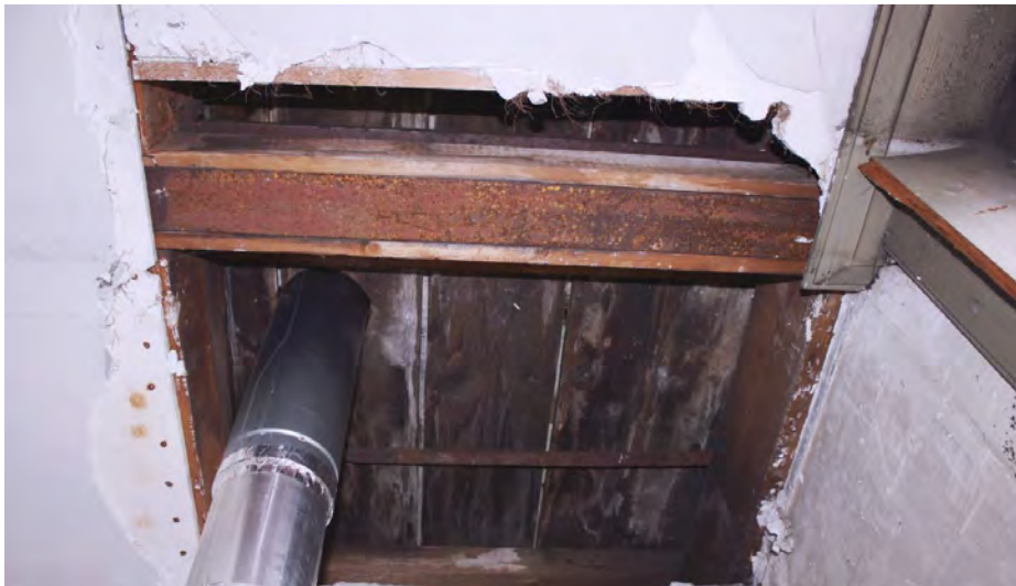
De enkelvoudige balklagen zijn in 1905 voorzien van ijzeren profielen, zoals hier zichtbaar is op de derde verdieping.
