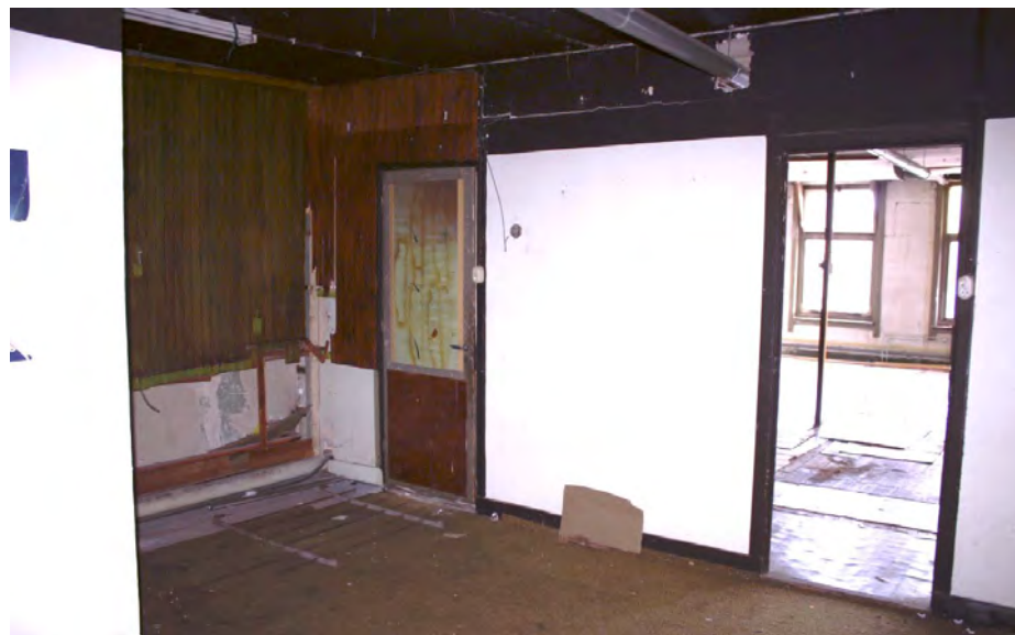
De rechter ruimte tegen de achtergevel, gezien richting de voorgevel.
