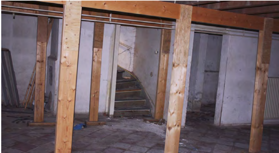
Zicht op de kelderopgang uit 1962 tegen de rechter gevel. Rechts van deze trap is tussen 1962 en 1987 een indeling gemaakt middels het aanbrengen van nieuwe binnenmuren. Links van de trap is de positie van de oorspronkelijke opgang.
