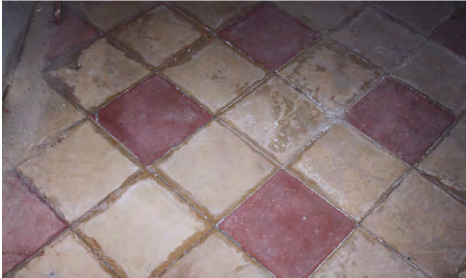
Detail van de keldervloer, bestaande uit gele en rode plavuizen.
