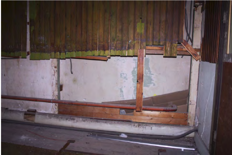
Achter de wandbekleding van schroten in de rechter ruimte tegen de achtergevel is een originele inbouwkast aanwezig.
