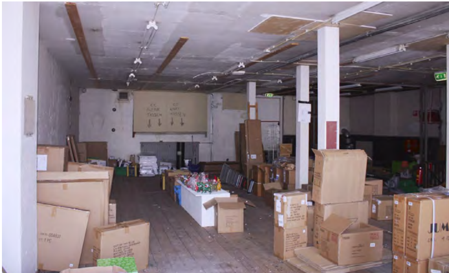
De tweede verdieping gezien richting de achtergevel.
