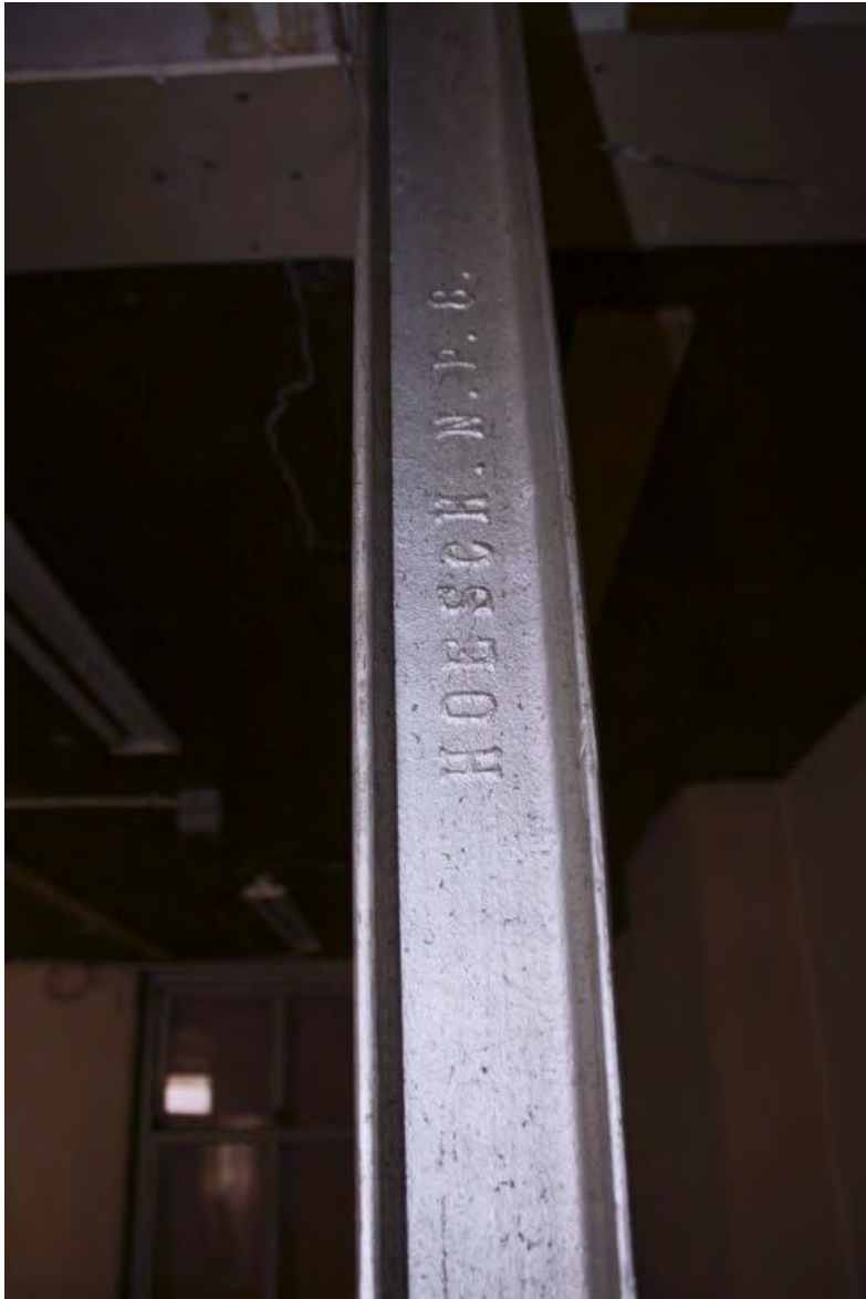
Detail van het opschrift van de fabrikant ( HOESCH ) van de ijzeren profielen die zijn gebruikt voor de kolom op de tweede verdieping.
