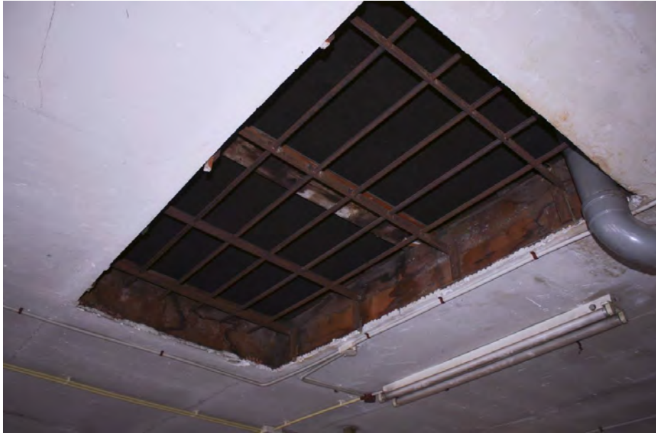
Detail van het dakrooster op de derde verdieping.
