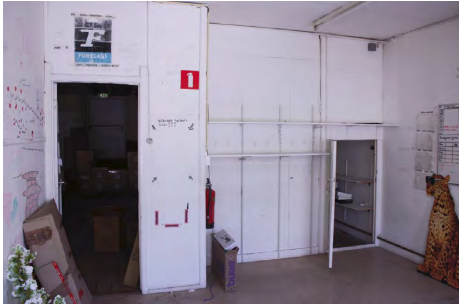
De ruimte tegen de rechterzijde van de voorgevel, gezien richting de achtergevel.
