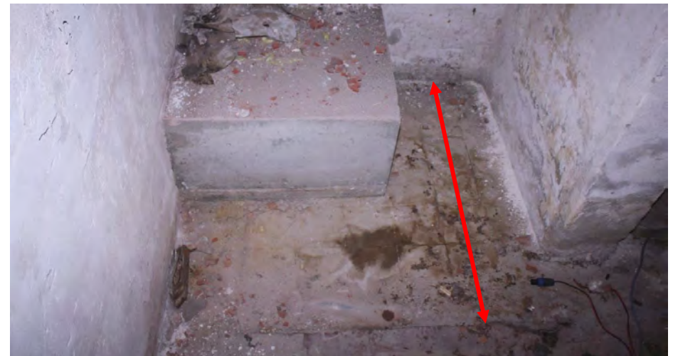
De oorspronkelijke diepte van de kasten tegen de rechtergevel zijn nog afleesbaar in de tegelvloer (rode pijl). De wand links is de rechterwand van de trapopgang. De muur rechts is een oorspronkelijke muurdam van een van de kasten.
