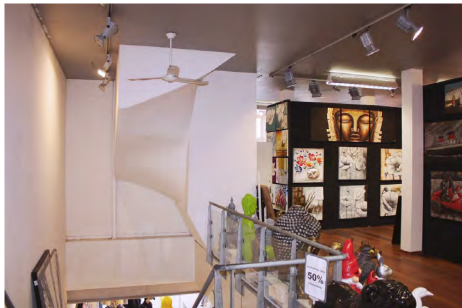
De trap naar de tweede verdieping hangt boven het trapgat van de opgang van de begane grond naar de verdieping.
