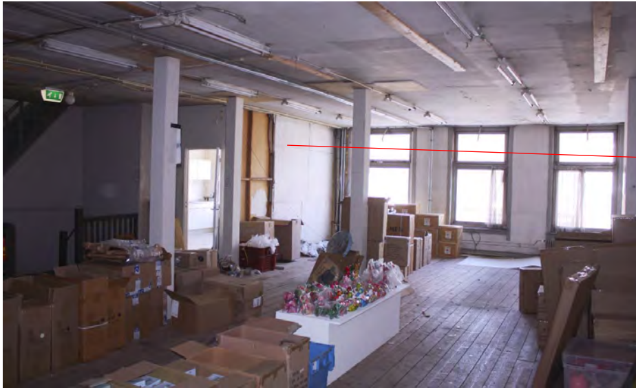
De tweede verdieping gezien richting de voorgevel, met links de binnenwand van na 1962.
