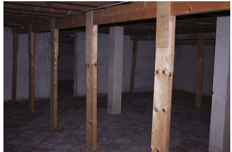
De kelder gezien van de achtergevel richting de voorgevel, met op de achtergrond de binnenwand uit 1962.
