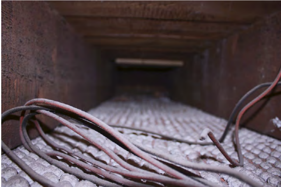
De secundaire stucplafonds op steengaas boven de eerste verdieping, ter hoogte van de oorspronkelijke trap. Er zijn mogelijk nog wel oorspronkelijke plafonds aanwezig boven de eerste verdieping.
