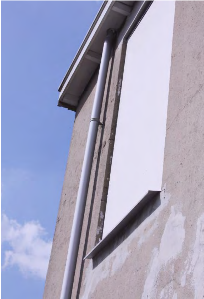
Het rechter venster op de derde verdieping heeft een moderne lekdorpel van kunststof.
