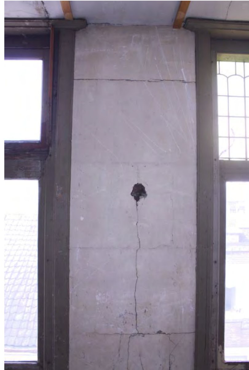
De muurdammen tussen de vensters zijn opgevuld met holle betonblokken, zoals hier zichtbaar op de derde verdieping.
