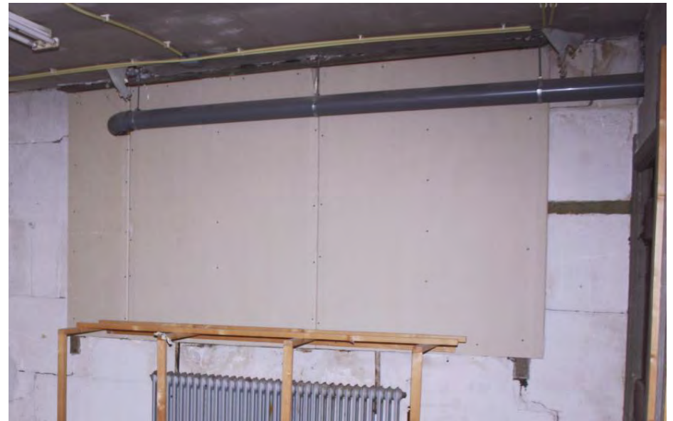
Het horizontale venster op de derde verdieping is afgetimmerd maar lijkt nog wel een oorspronkelijk kozijn te hebben.
