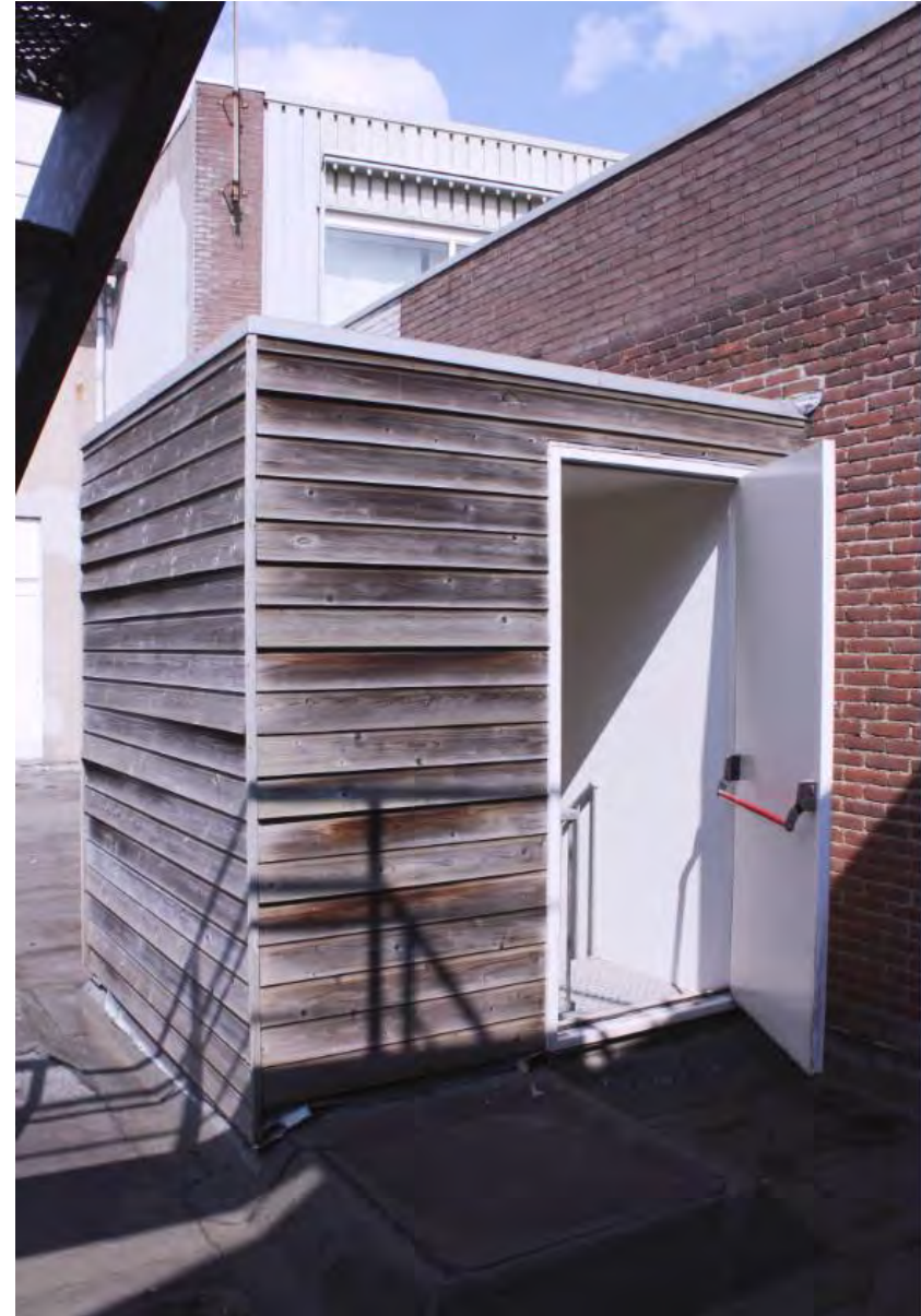
De stalen wenteltrap komt middels een houten betimmering uit op het plat dak van de achterbouw.
