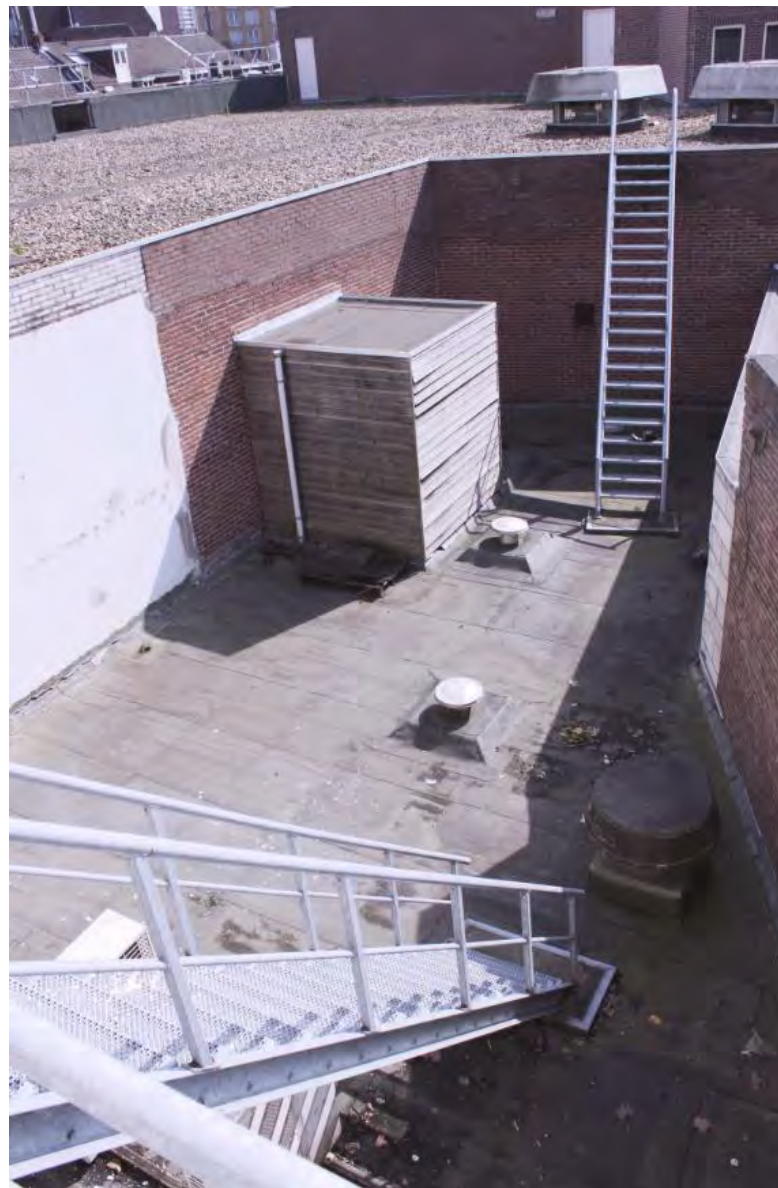
Zicht op het enkellaagse achterbouw onder een plat dak, gezien vanaf het bordes van de brandtrap tegen de achtergevel van de voorbouw.
