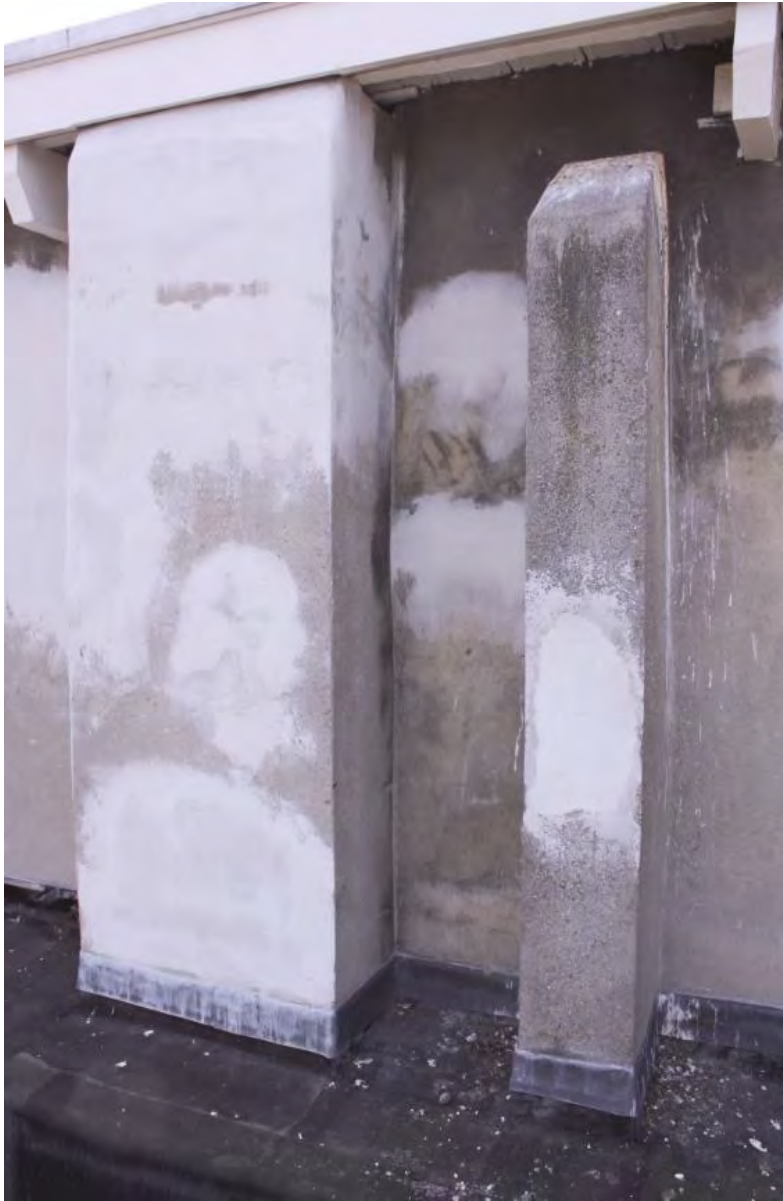
Het oorspronkelijke rookkanaal en de eerste steunbeer tegen de linker zijgevel, gezien vanaf de voorgevelzijde.
