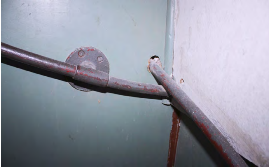
Detail van de leuning bij de trap naar de tweede verdieping.
