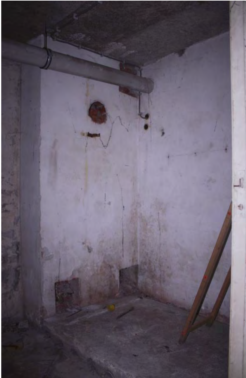
Zicht op het secundaire rookkanaal tegen de linker gevel, met op de keldervloer het betonnen fundament.
