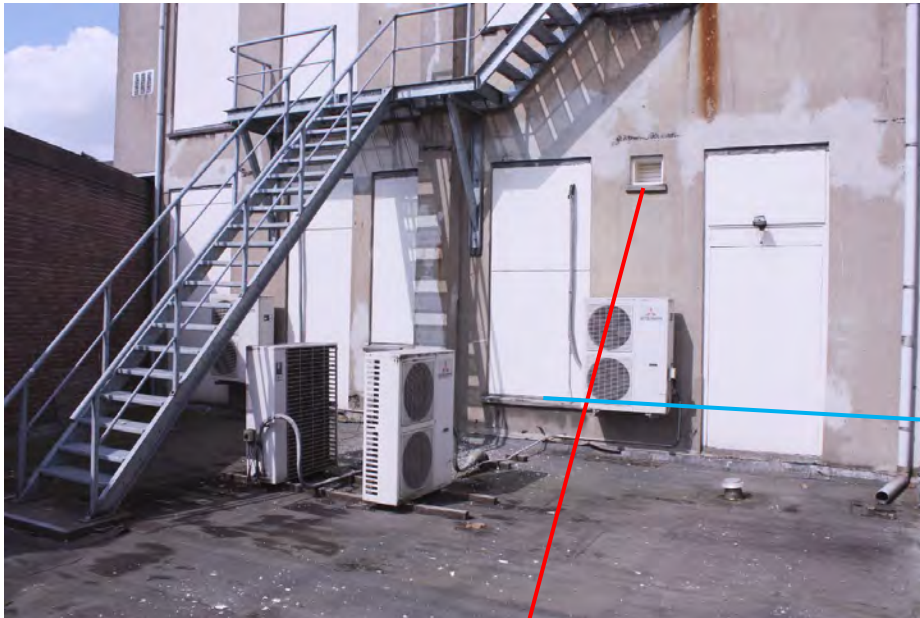
De indeling van de achtergevel op de eerste verdieping volgt de oorspronkelijke opzet.
