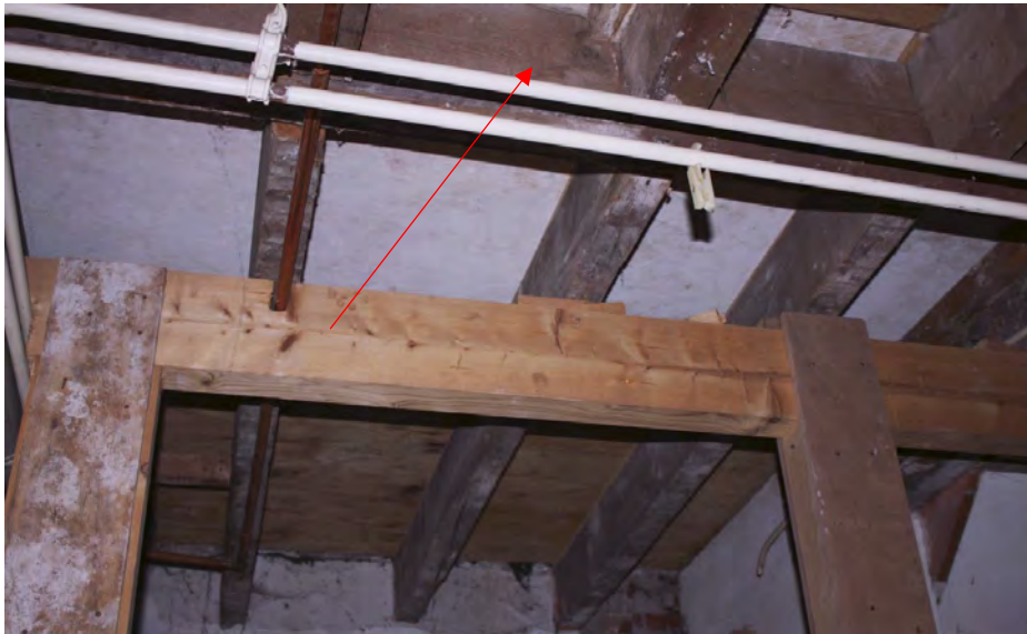
De raveelbalk van het oorspronkelijke trapgat is nog aanwezig in de balklaag (rode pijl).
