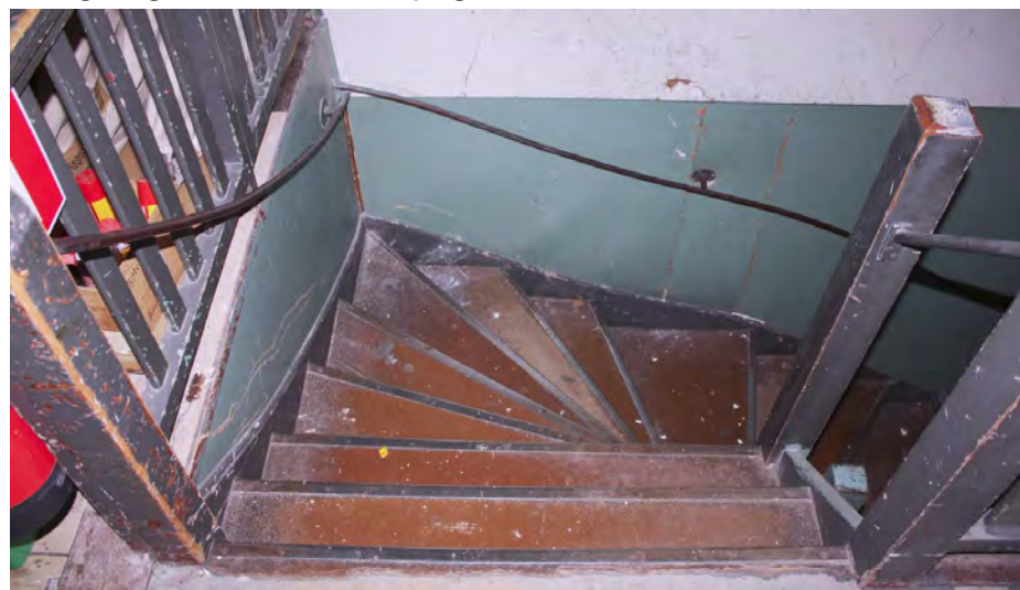
De trap naar de tweede verdieping gezien vanaf de bovenzijde.
