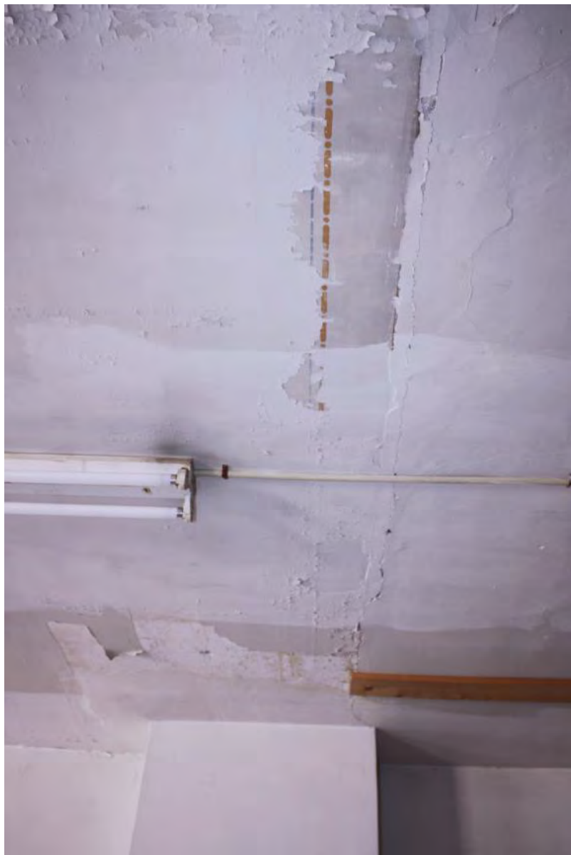
Het oorspronkelijke stucplafond op juten heeft boven de voormalige kamer aan de linkerkant tegen de voorgevel een schildering.
