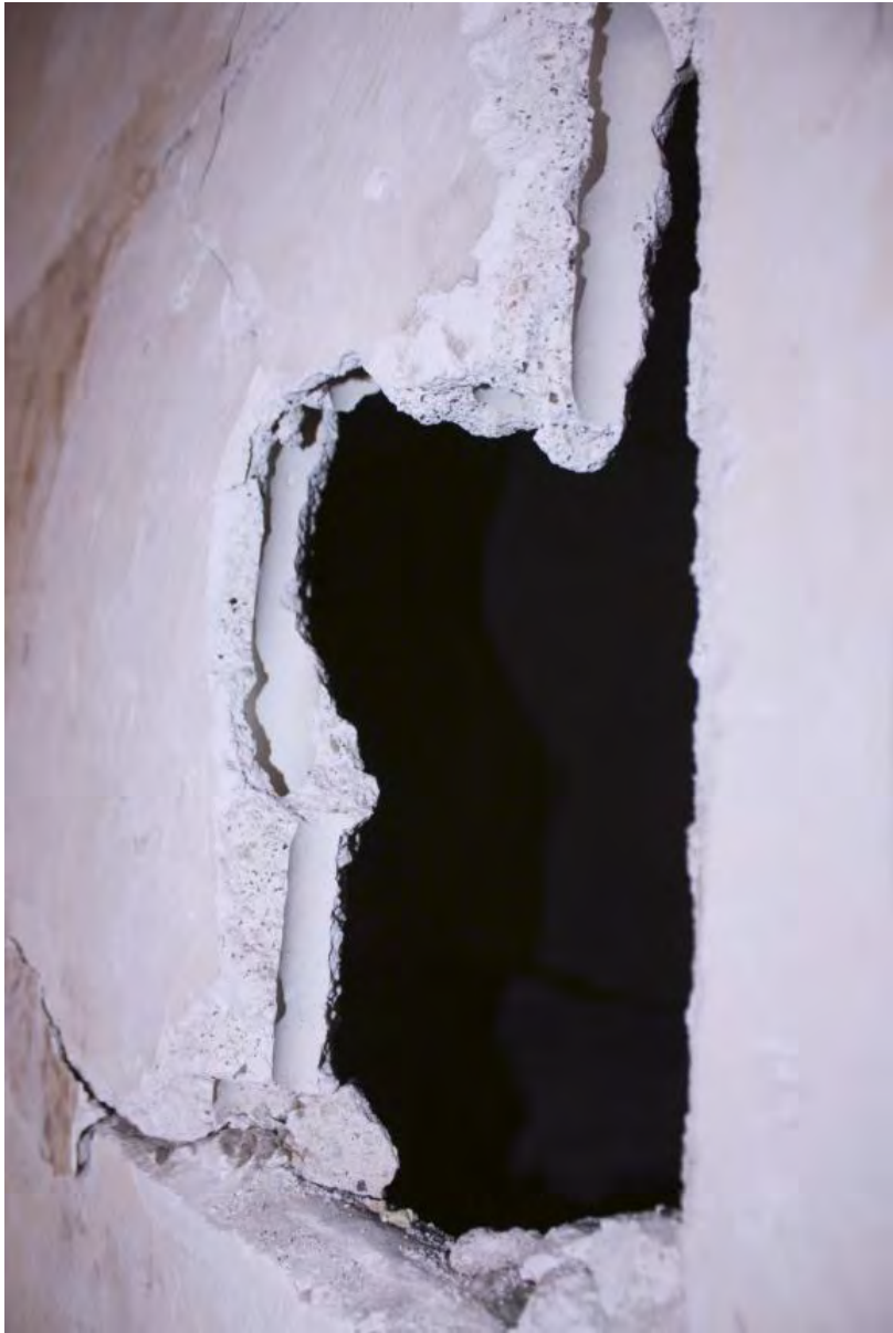
De oorspronkelijke binnenmuur aan de achterzijde van de derde verdieping is opgebouwd uit holle betonblokken.
