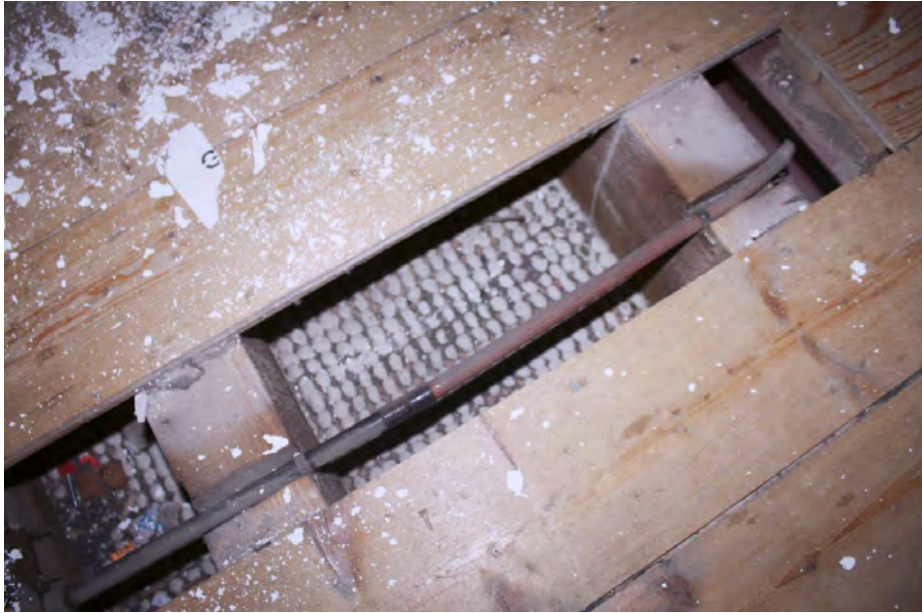
Detail van de enkelvoudige balklaag van de vloer van de tweede verdieping.
