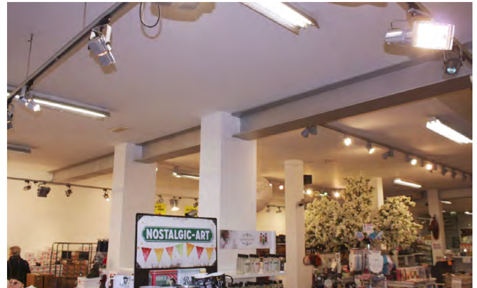
De later aangebrachte draagconstructie op de begane grond. Deze houten imitatie balken lijken van staal te zijn maar dienen vermoedelijk enkel een decoratieve functie. De omtimmerde kolommen kunnen wel oorspronkelijk zijn.
