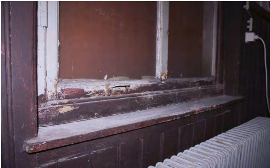
Detail van de onderzijde van het schuifraam met de oorspronkelijke handgrepen in het rechter venster op de tweede verdieping.
