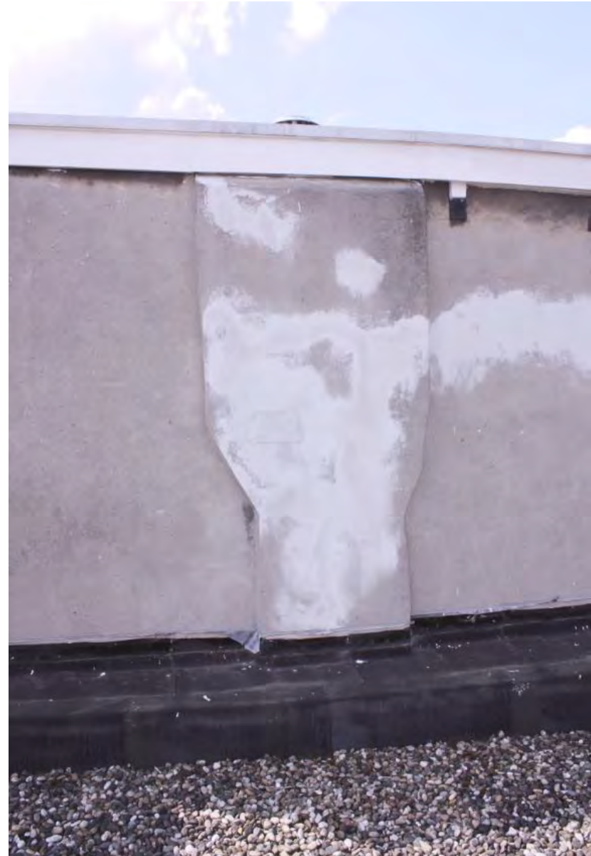
Het oorspronkelijke rookkanaal aan de achterzijde van de linker zijgevel.
