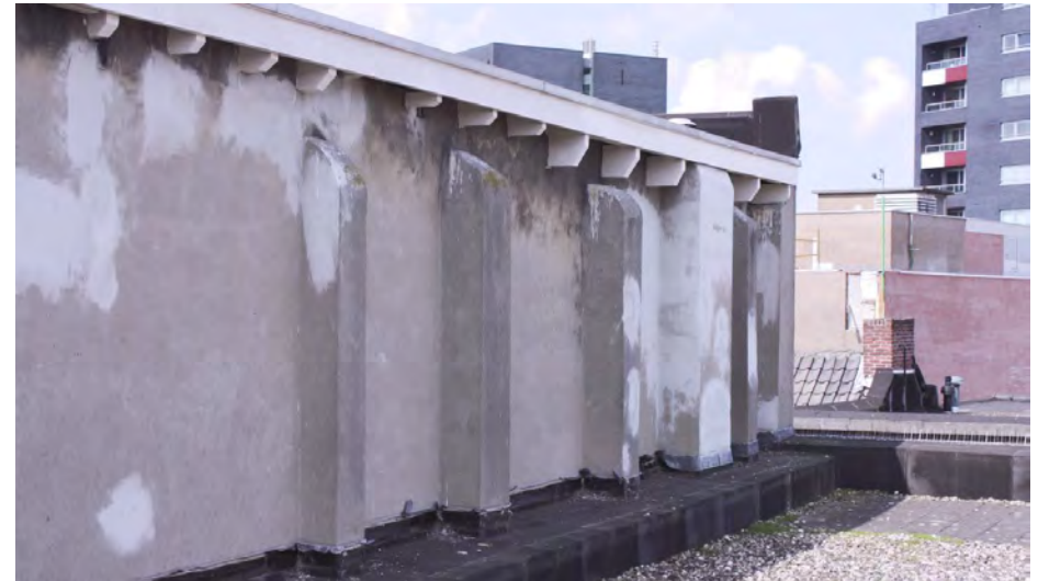
Zicht op de steunberen tegen de linker zijgevel, gezien richting de achtergevel. Tussen de derde en vierde steunbeer is een oorspronkelijk rookkanaal aanwezig. De balken van het plat dak zijn aan de voorzijde veel hoger.
