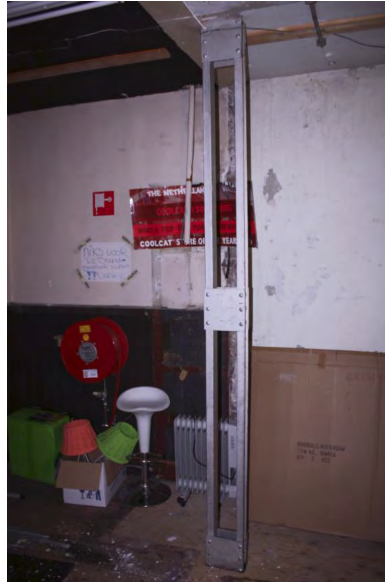
Kolom op de tweede verdieping, opgebouwd uit twee ijzeren profielen die worden gekoppeld middels een schetsplaat.
