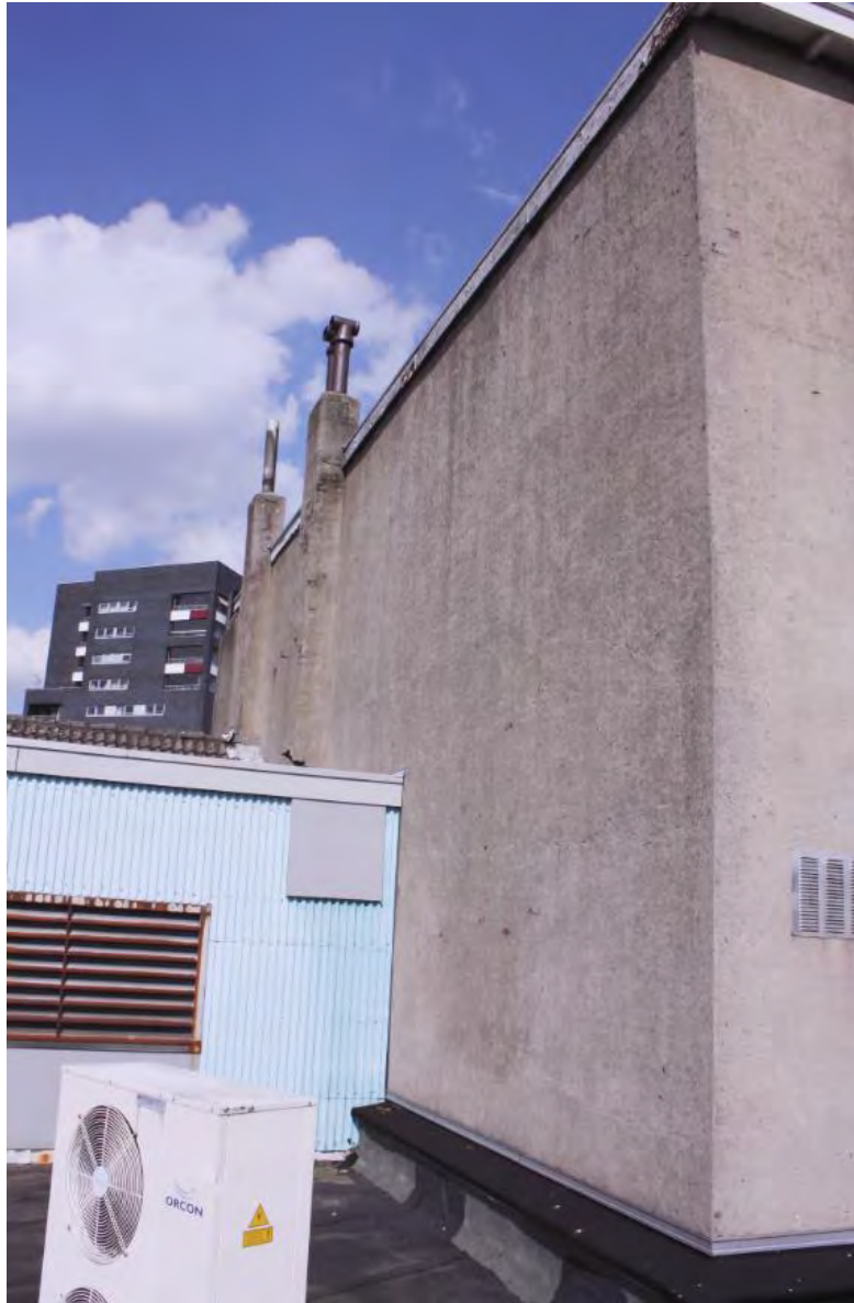
De rechter zijgevel gezien richting de Heuvelstraat.
