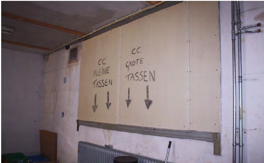
De binnenzijde van het horizontale venster op de tweede verdieping met doorlopende kozijnstijlen.
