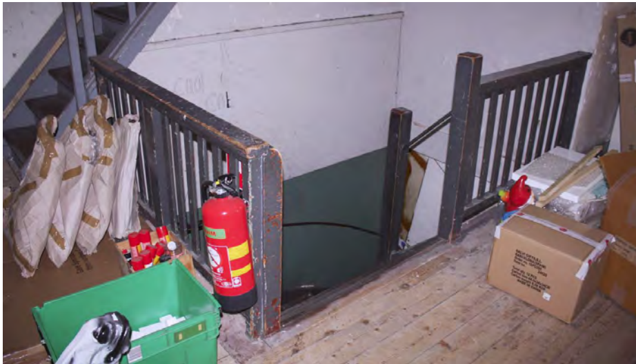
Detail van de balustrade van de trap op de tweede verdieping.
