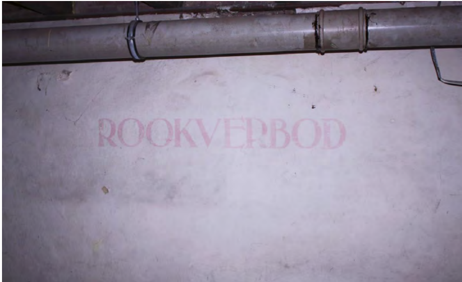
Tegen de linker gevel van de kelder is het woord ROOKVERBOD geschilderd.
