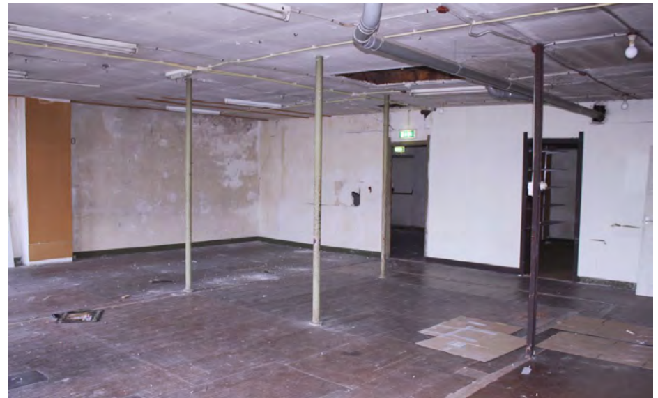
Derde verdieping gezien richting de achtergevel.
