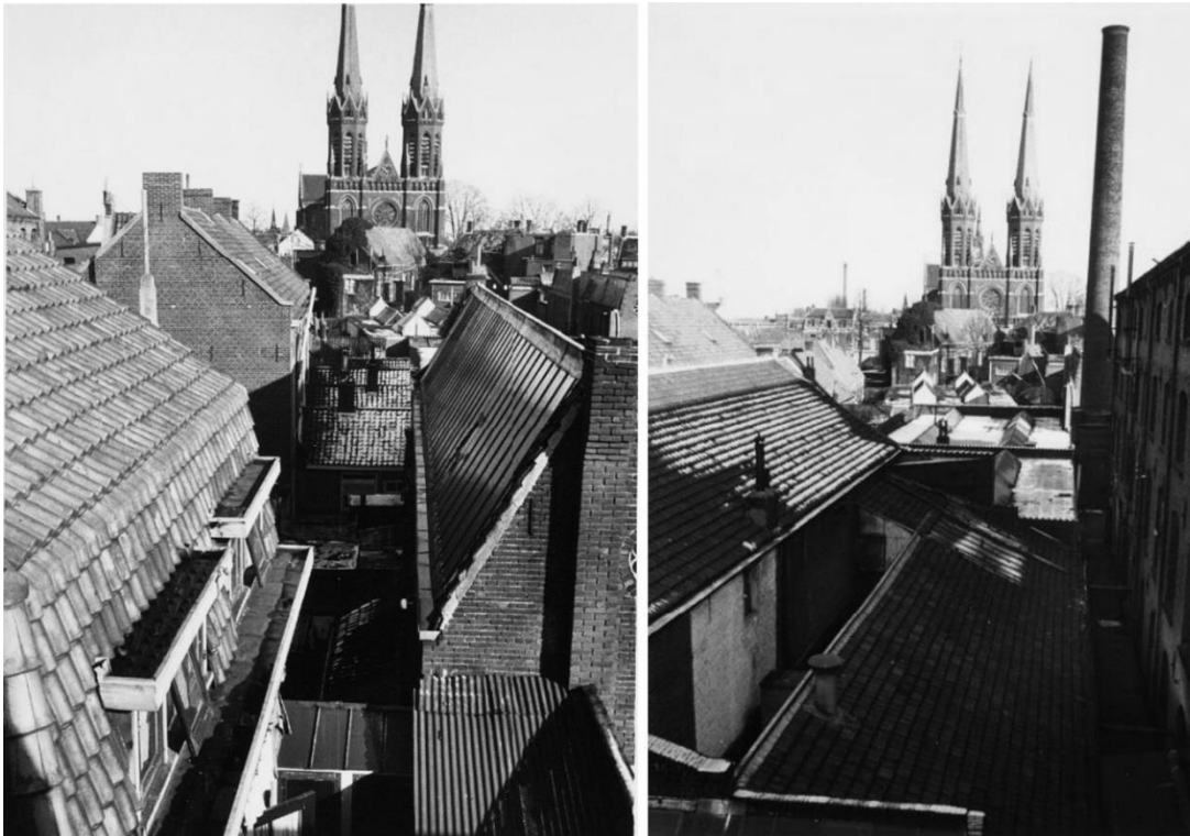
Figuur 3.16. Het complex van Brands gefotografeerd in 1954 vanaf het dak van de Vroom & Dreesmann. De kijkrichting is naar het oosten. Op de linker foto zijn links de huizen langs de Tuinstraat te zien (de blinde zijgevel is van nummer 16) en rechts het glazen sheddak waarvan op de rechter foto de andere dakhelft te zien is (bron: RAT beeldarchief foto's 028405 (links) en 028404 (links)).
