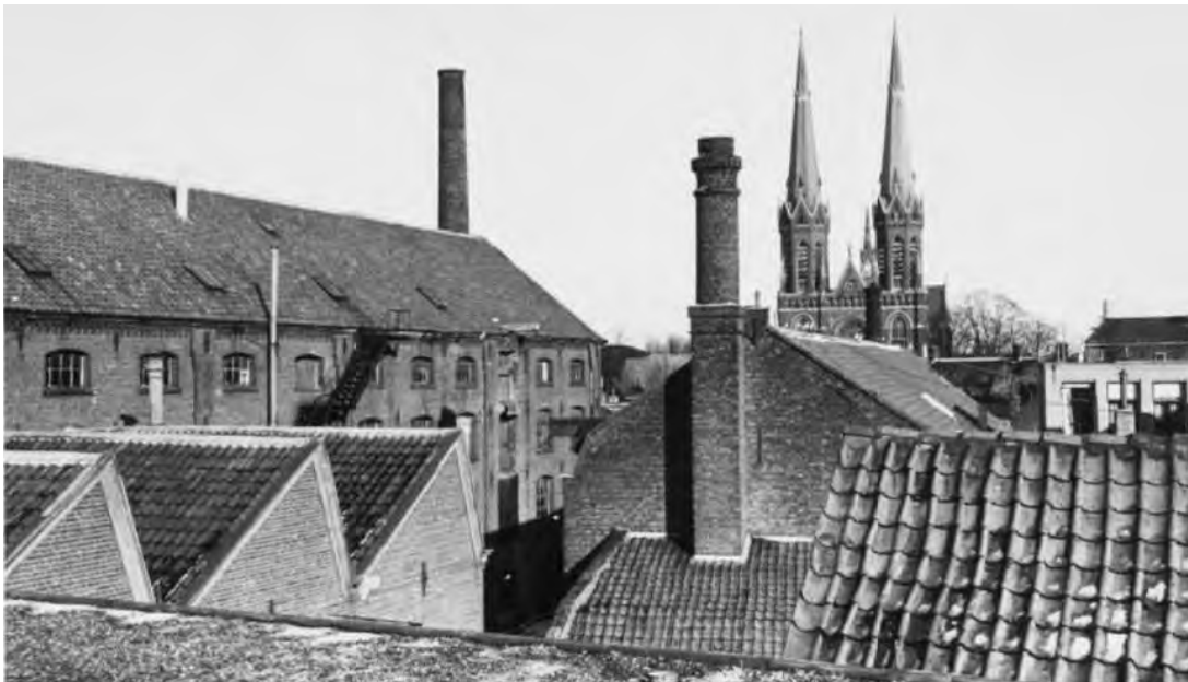
Figuur 3.19. Het vermoedelijk hoofdgebouw van Brands in 1954. Opname vanaf het dak van het V&D pand. Het pannendak rechts onder is van het pand Heuvelstraat 31, het sheddak met pannen en vierkante schoorsteen in het midden is van de bakkerij op Heuvelstraat 25 (bron RAT beeldarchief 028402).
