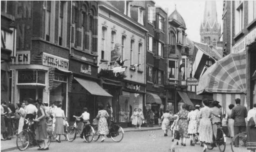
Figuur 3.27: Heuvelstraat ter hoogte van nummer 25 (witte gebouw) in 1955 (bron: RAT beeldarchief foto 021599).
