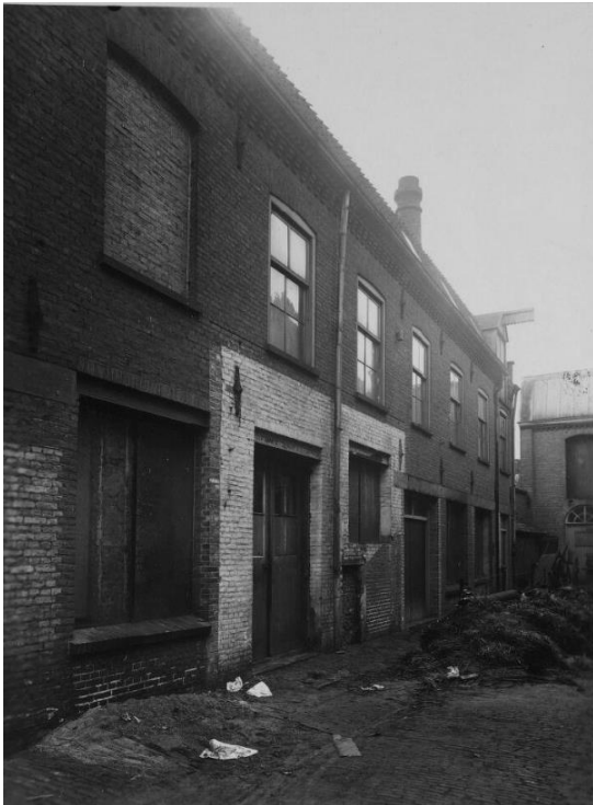
Figuur 3.21. Het gebouw van Brands aan de zuidzijde van het plangebied, omstreeks 1965 gefotografeerd (V&D-gebouw ontbreekt!). In het midden rechts is nog net de uitbouw van het hoofdgebouw te zien, terwijl boven het dak de schoorsteen van de bakkerij op Heuvelstraat 25 te zien is.
