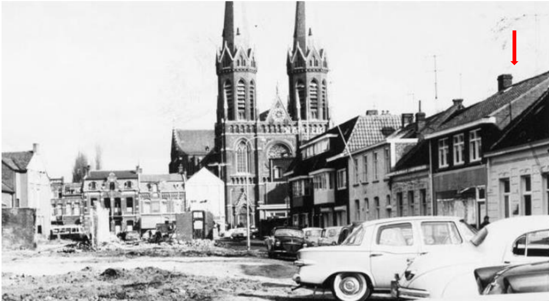
Figuur 3.8. Tuinstraat vanaf het terrein van de voormalige spinnerij, kijkend naar het oosten. Perceel 8 is met een rode pijl aangegeven. De foto dateert uit 1962 (bron RAT beeldarchief fotonummer 033537).
