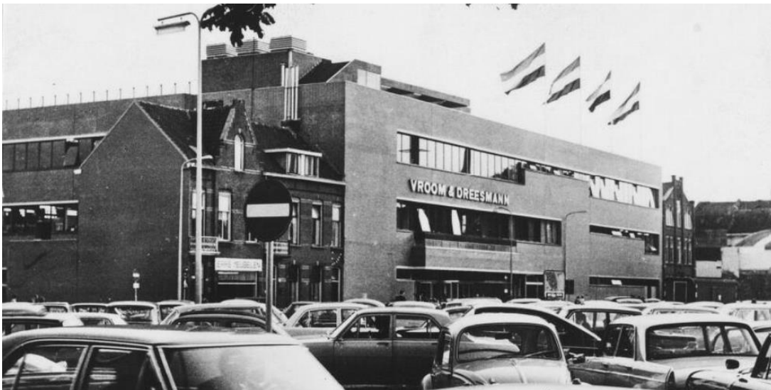
Figuur 3.12. De Tuinstraat vanaf het parkeerterrein aan de noordzijde van de straat. De foto dateert uit de late jaren zestig, na de voltooiing van het nieuwe V&D gebouw. Alleen panden 14 en 16 zijn nog aanwezig (bron RAT beeldarchief, foto 002680).
