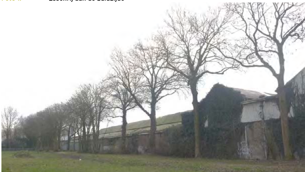
Foto 1. Essenrij aan de zuidzijde
