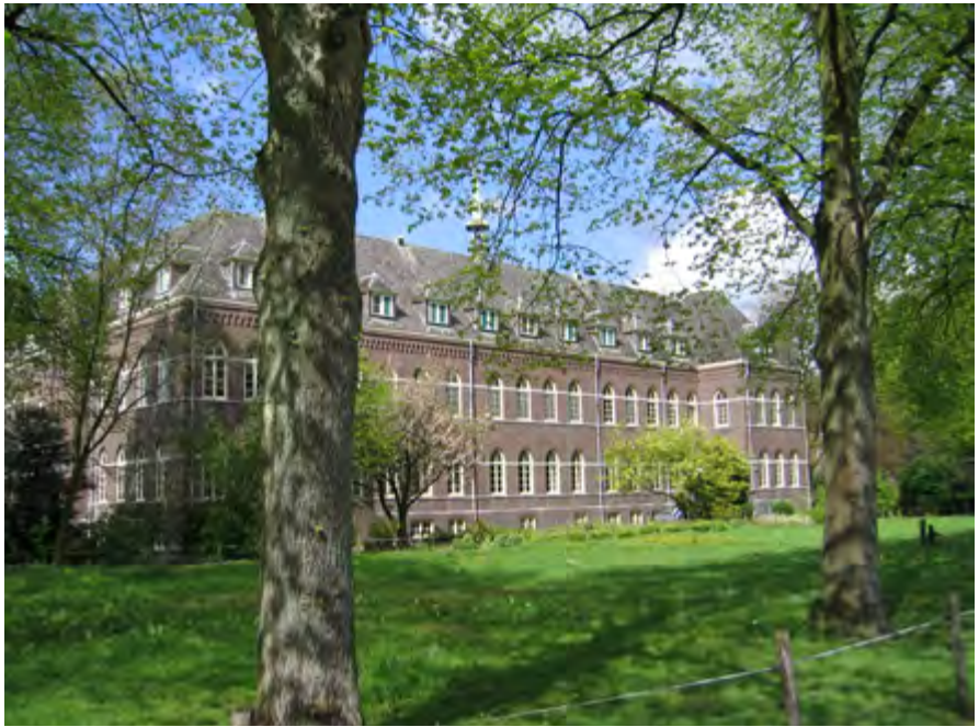
hoofdgebouw Adbij (zuidwestzijde)
