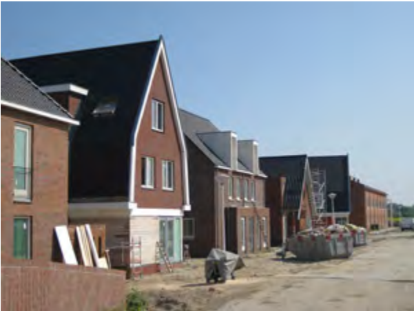
baksteen voert de boventoon
