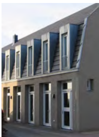
dakkapellen in lage deel mansardekap
