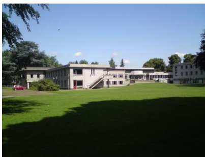
Achtergevel en westelijke zijgevel
